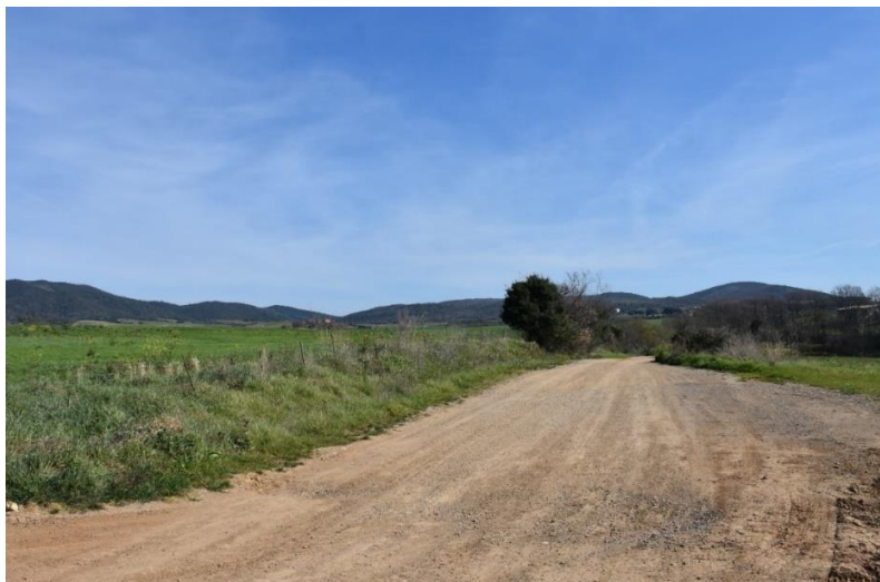
Figura 67- Inizio del cavidotto
