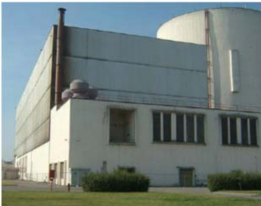
Figura 2 – Foto esterni Edificio Turbina (in primo piano edificio Annex Turbina e a destra Edificio Reattore)
