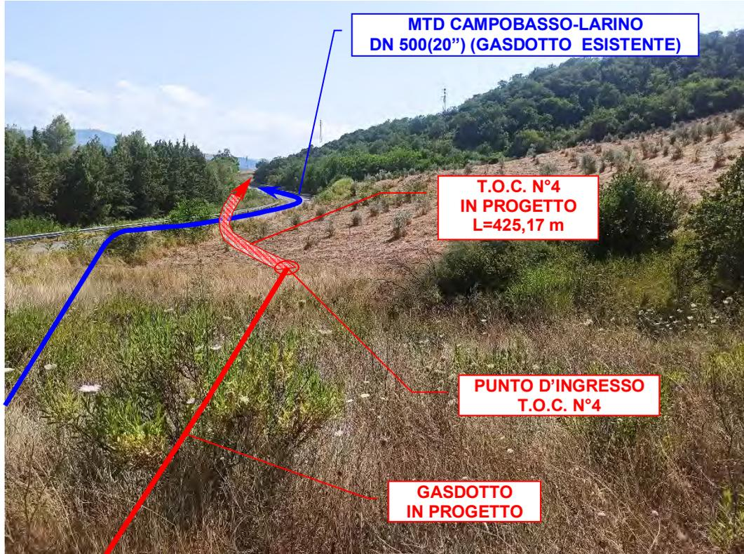
Foto n°23 – Ingresso Trivellazione Orizzontale Controllata (T.O.C. n°4) e 1° Attraversamento Strada Comunale ex Bifernina.
