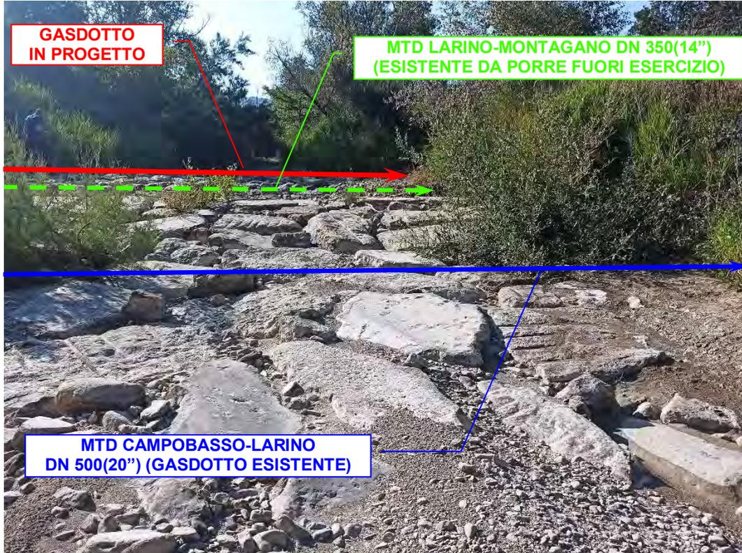
Foto n°35 – Attraversamento con scavo a cielo aperto del *Torrente Rio*.
