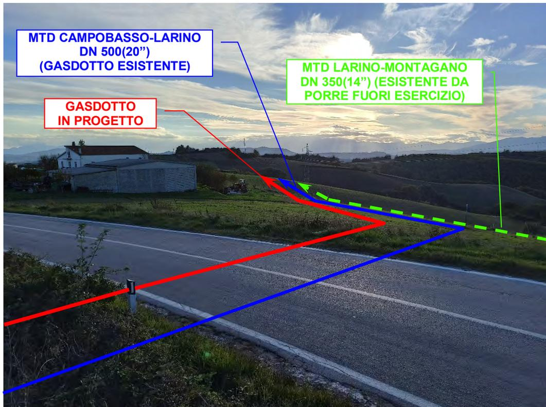
Foto n°103 – 5° Attraversamento Strada Provinciale n°13 con trivella spingitubo.
