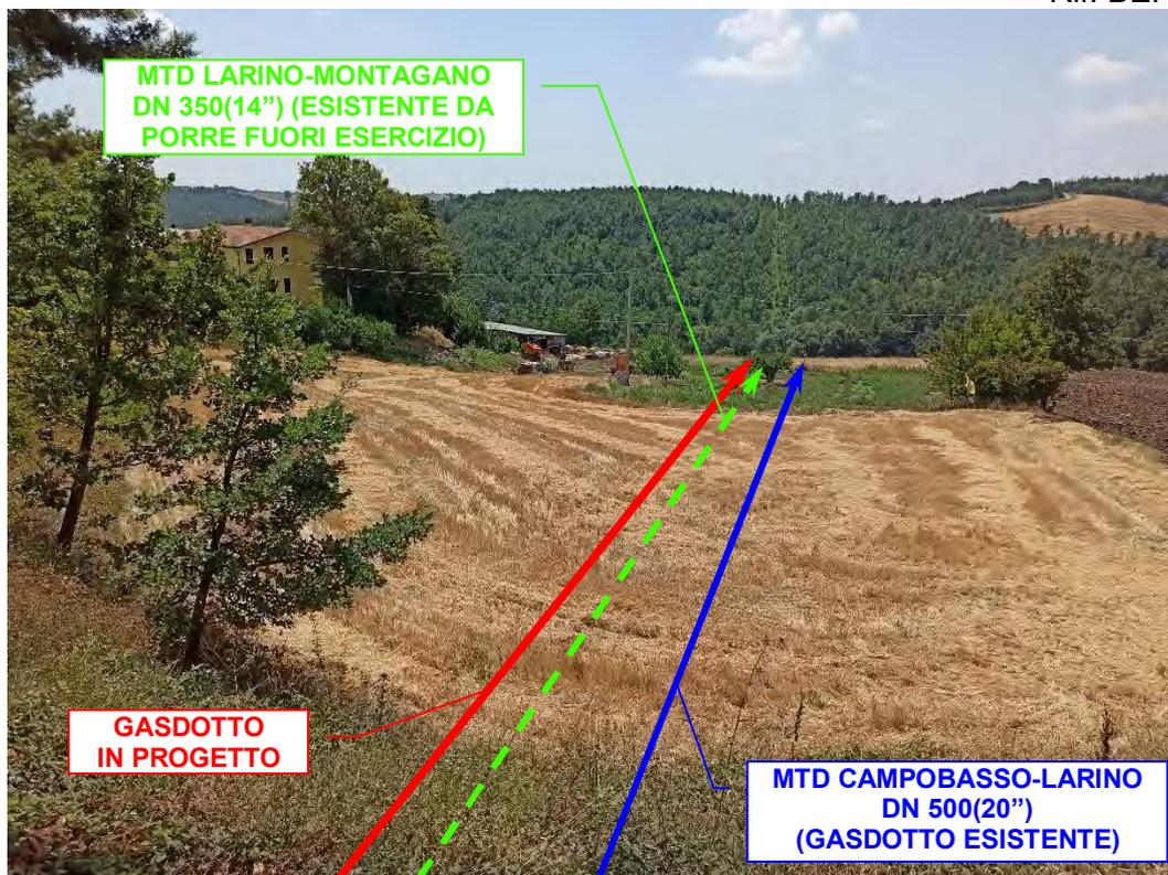
Foto n°96 – Vista panoramica gasdotto in dismissione (tratto verde), in progetto (tratto rosso) e in parallelismo con il gasdotto esistente (tratto blu), in località *Masseria Spina*.
