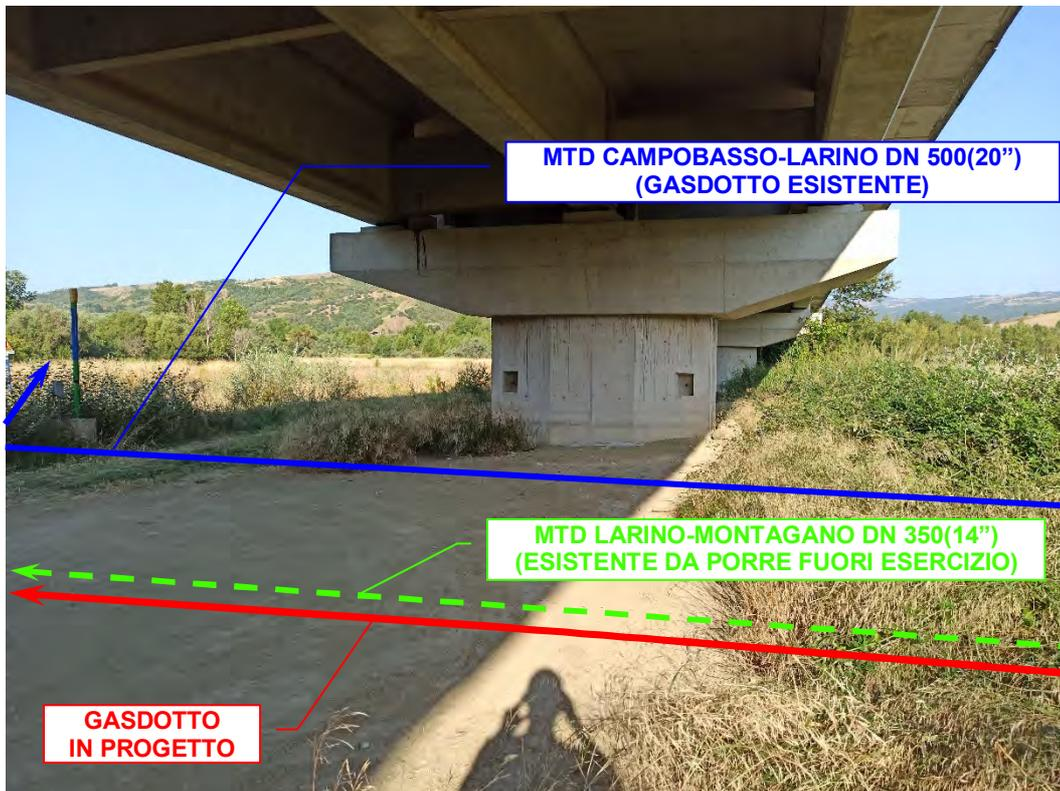
Foto n°36 –Attraversamento con scavo a cielo aperto, in sottopasso alla *Strada Statale n°748*.
