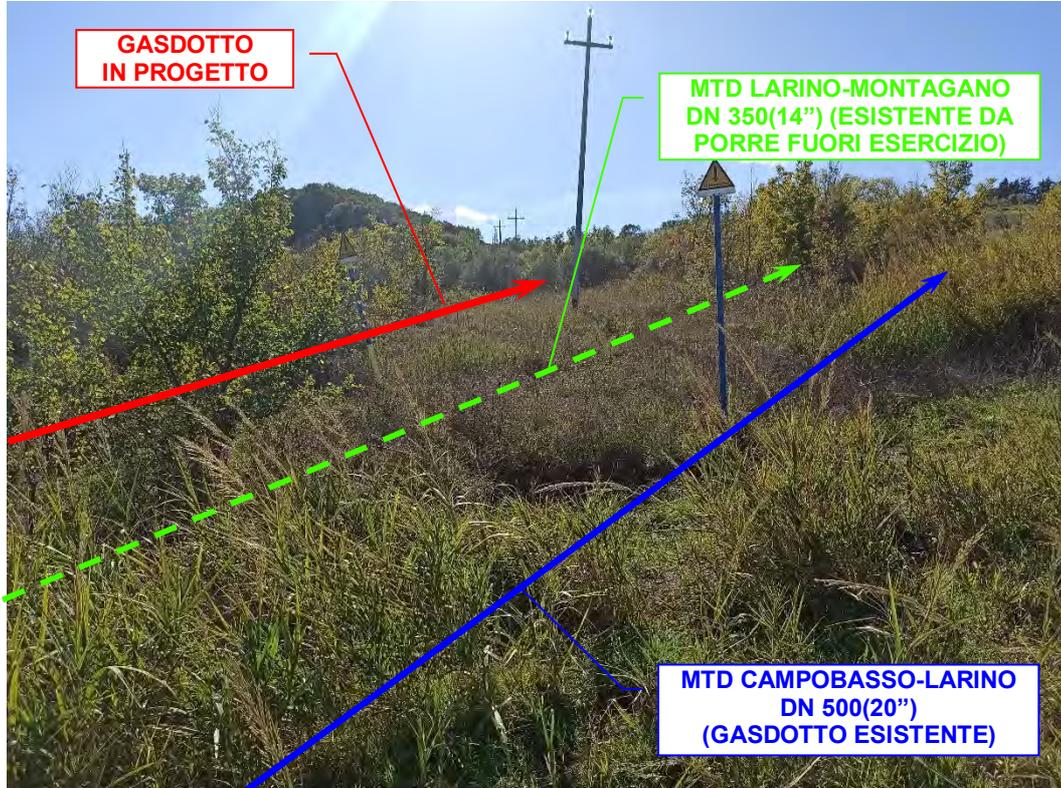
**Foto n°70** – Vista panoramica gasdotto in dismissione (tratto verde), in progetto (tratto rosso) e in parallelismo con il gasdotto esistente (tratto blu) e interferenza con Linea Elettrica Media Tensione, in località *Macchia Rana*.
