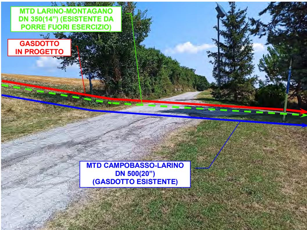
Foto n°95 – Attraversamento *Strada Comunale Ricciarello* (asfaltata) con scavo a cielo aperto.
