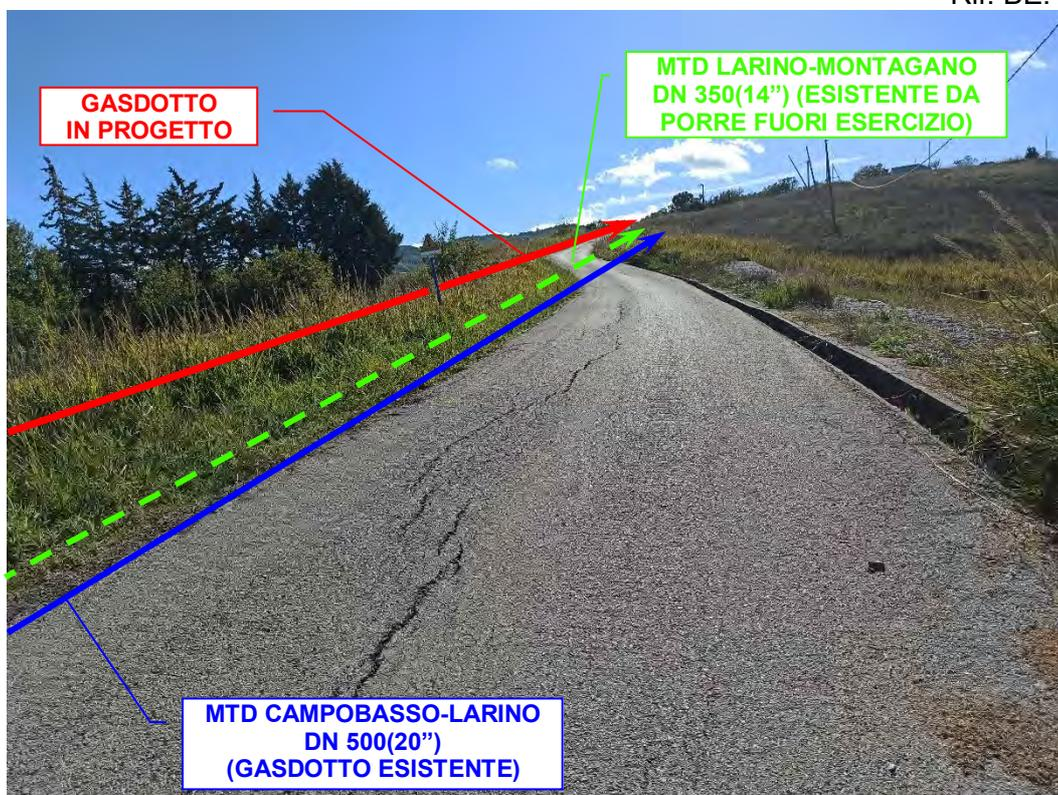
Foto n°72 – 2° Attraversamento con scavo a cielo aperto della Strada Comunale Sferracavallo (asfaltata).
