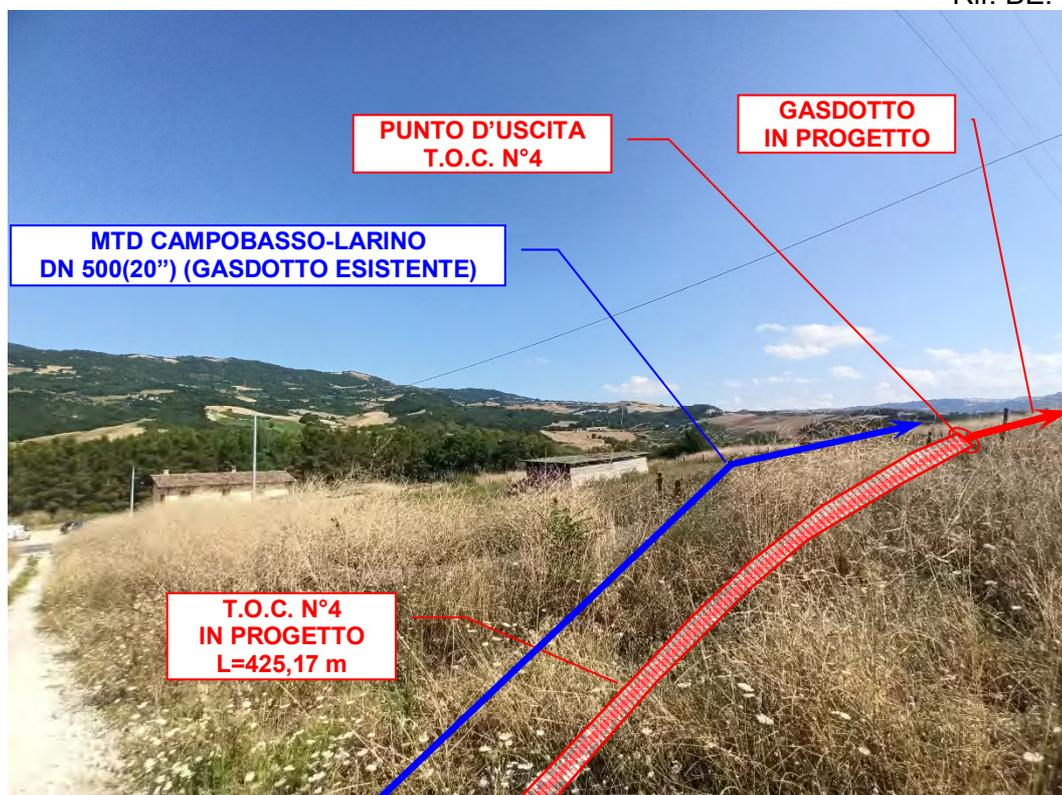
**Foto n°25** – Vista panoramica gasdotto in progetto e punto d'uscita Trivellazione Orizzontale Controllata (T.O.C. n°4) in località *Farotta*.
