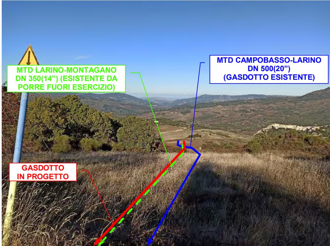
**Foto n°82** – Vista panoramica gasdotto in dismissione (tratto verde), in progetto (tratto rosso) e gasdotto esistente (tratto blu), in attraversamento e in parallelismo al gasdotto in progetto.
