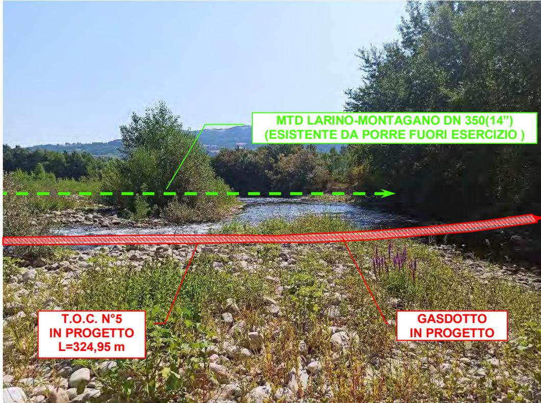
Foto n°31 – Vista attraversamento in T.O.C. Fiume Biferno.
