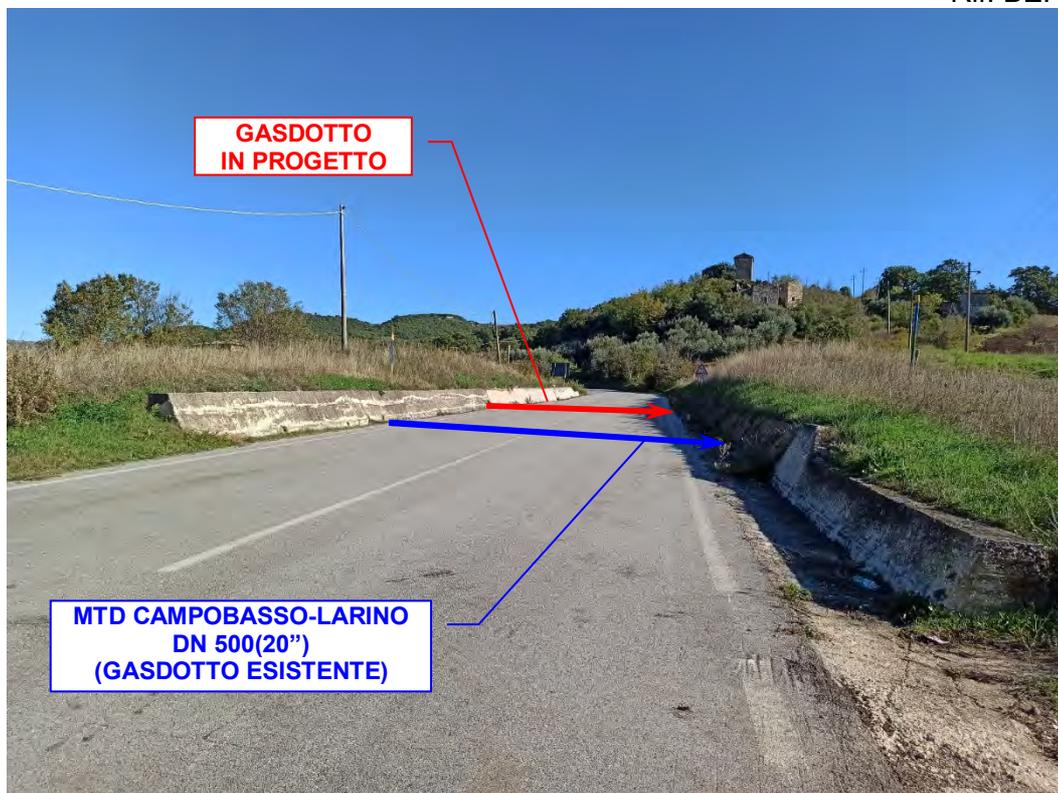
Foto n°55 – Attraversamento della *Strada Provinciale n°157* con trivella spingitubo.
