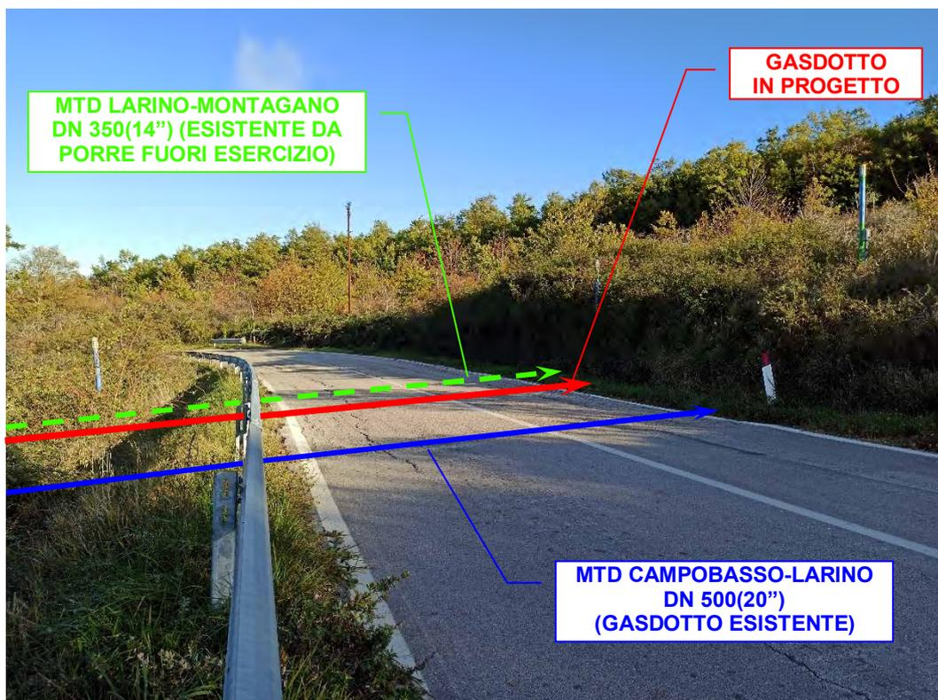
**Foto n°93** – 2° Attraversamento Strada Provinciale n°13 con trivella spingitubo.
