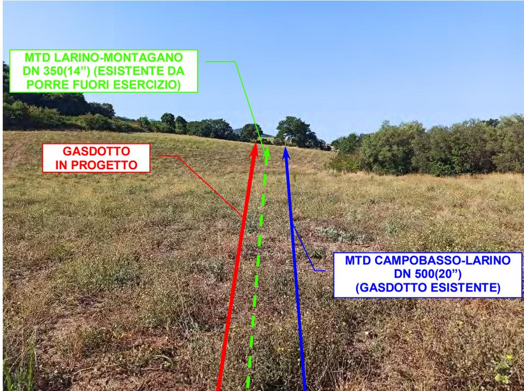
Foto n°39 – Vista parallelismi gasdotti esistenti e in progetto, in località Valle Cupa.
