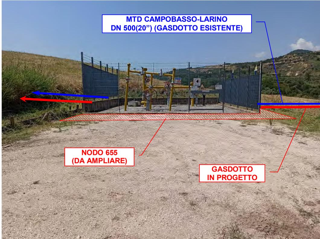
Foto n°41 – Punto di Intercettazione di Derivazione Importante (P.I.D.I.) – Nodo 655 da ampliare.
