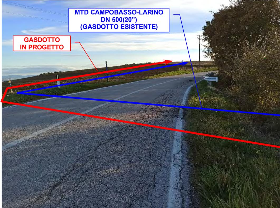
Foto n°102 – 4° Attraversamento Strada Provinciale n°13 con trivella spingitubo.
