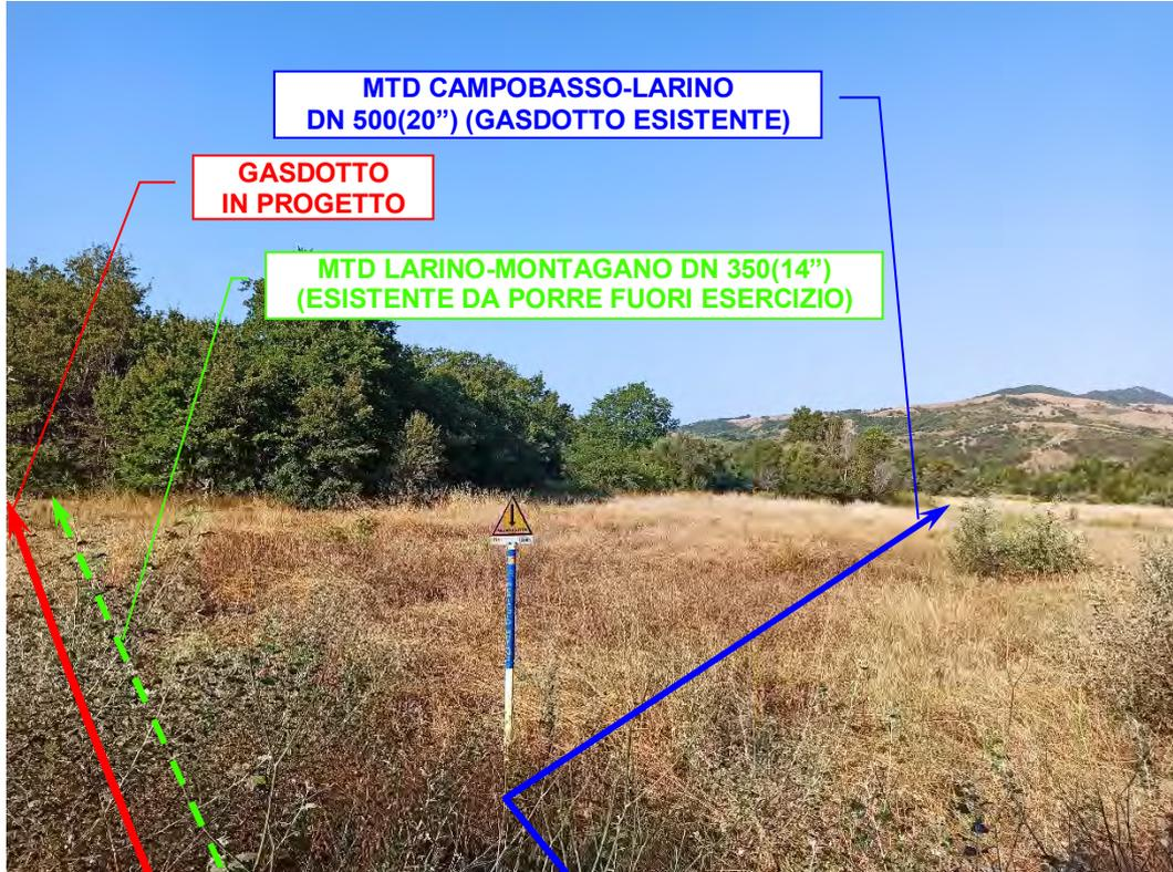
Foto n°37 – Vista panoramica gasdotti esistenti e in progetto dopo l'attraversamento della *Strada Statale N°748*
