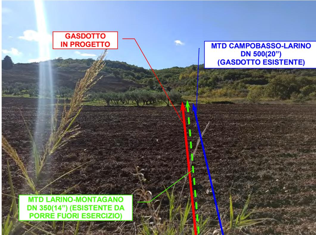
**Foto n°68** – Vista panoramica gasdotto in dismissione (tratto verde), in progetto (tratto rosso) e in parallelismo con il gasdotto esistente (tratto blu), in località *Caprara*.
