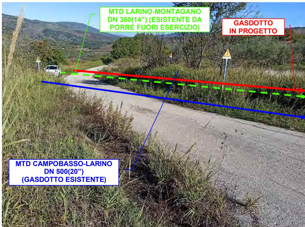
**Foto n°69** – 1° attraversamento con scavo a cielo aperto della *Strada Comunale Sferracavallo* (asfaltata).
