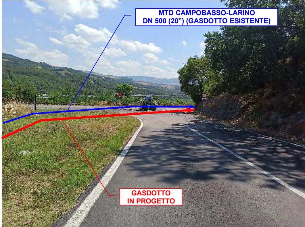
Foto n°13 – Vista attraversamento Strada Provinciale N°73b con scavo a cielo aperto.
