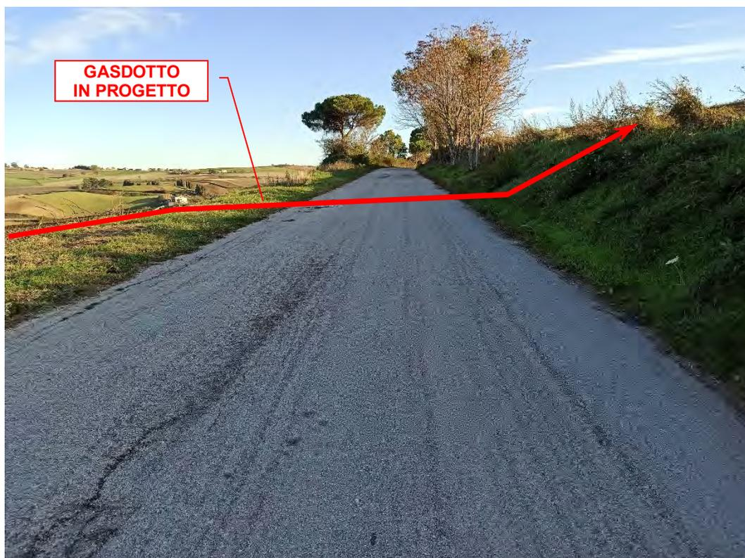
**Foto n°99** –Attraversamento *Strada Provinciale n°40* con trivella spingitubo.
