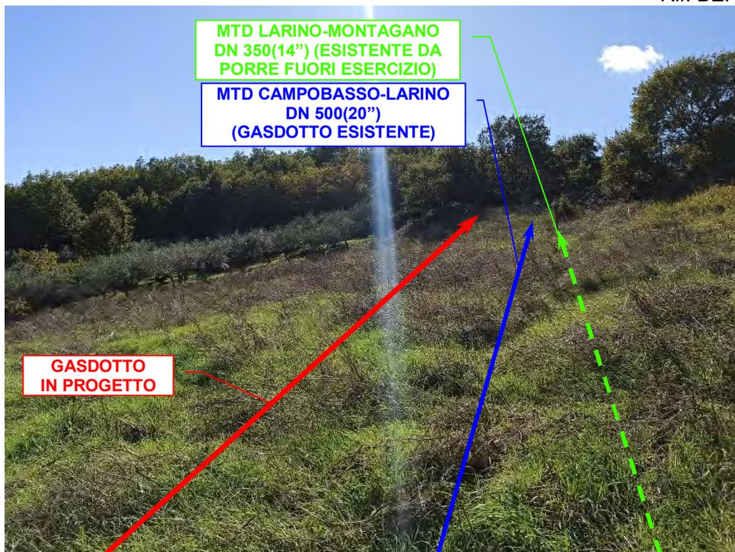
**Foto n°74** – Vista panoramica gasdotto in dismissione (tratto verde), in progetto (tratto rosso) e in parallelismo con il gasdotto esistente (tratto blu), area di occupazione per attraversamento con spingitubo della *Strada Provinciale n°71*.
