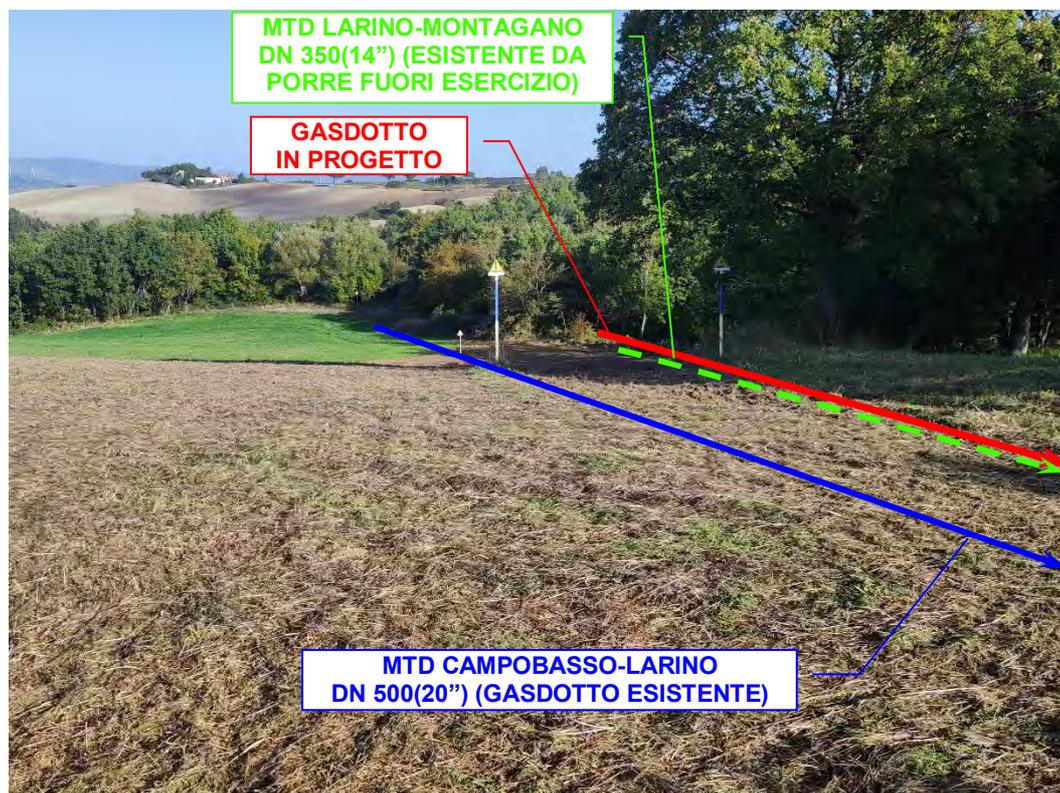
**Foto n°89** – Vista panoramica gasdotto in dismissione (tratto verde), in progetto (tratto rosso) e in parallelismo con il gasdotto esistente (tratto blu).
