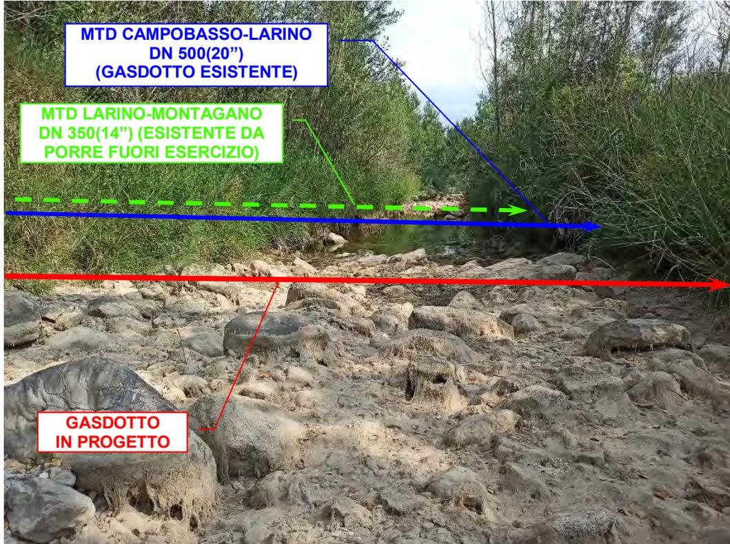
Foto n°62 – Attraversamento con scavo a cielo aperto del *Torrente Riomaio*.
