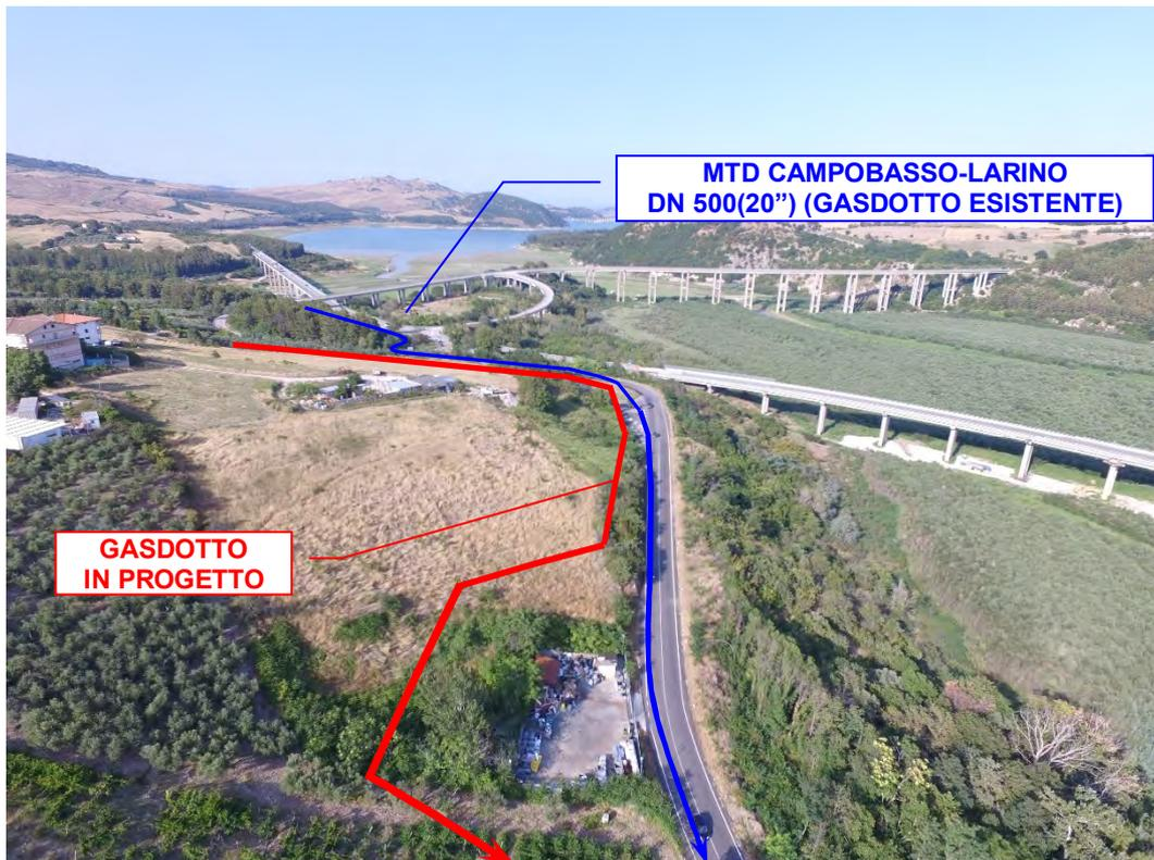
Foto n°14 – Vista panoramica gasdotto in progetto in parallelismo con Strada Provinciale n°73b e interferenza con isola ecologica del Comune di Guardialfiera.
