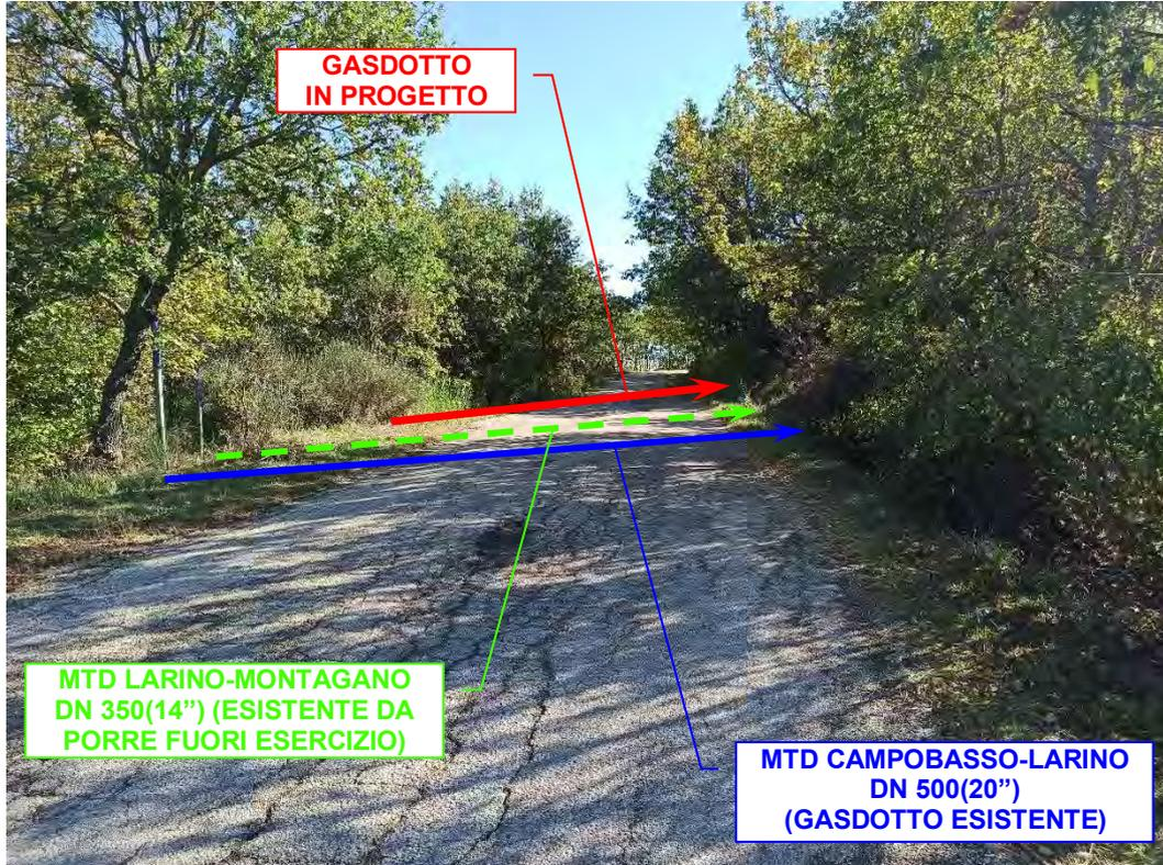
Foto n°76 – 2° Attraversamento della Strada Provinciale n°71 con trivella spingitubo.
