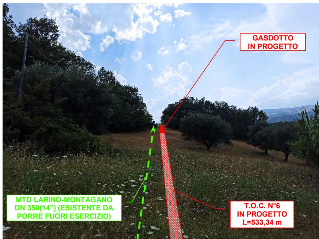
**Foto n°52** – Vista panoramica gasdotto in progetto e posa della condotta in Trivellazione Orizzontale Controllata (T.O.C. n°6) in un Oliveto, in località *Valle Ospedale*.
