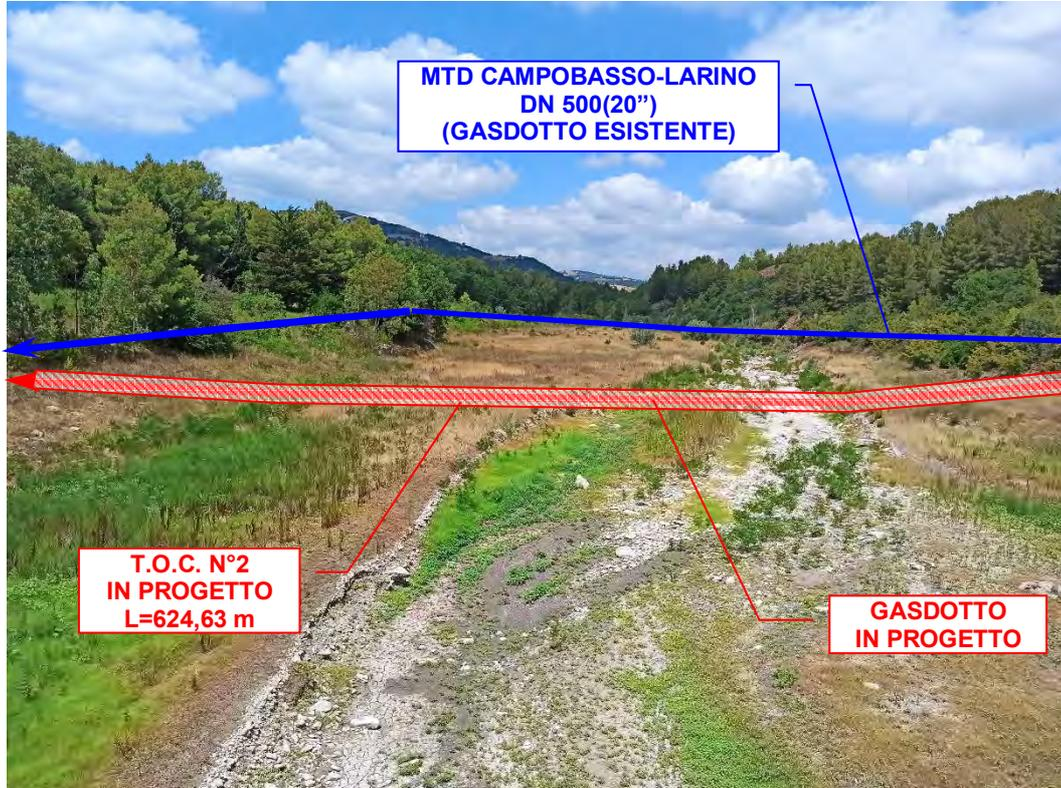
Foto n°7 – Vista attraversamento *Torrente Cervaro* in Trivellazione Orizzontale Controllata (T.O.C. N°2).
