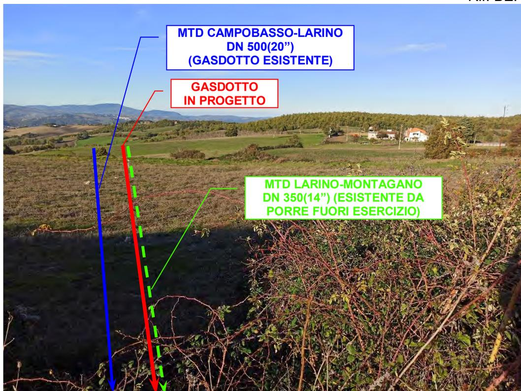
**Foto n°92** – Vista panoramica gasdotto in dismissione (tratto verde), in progetto (tratto rosso) e in parallelismo con il gasdotto esistente (tratto blu), prima dell'attraversamento della *Strada Provinciale n°13*.
