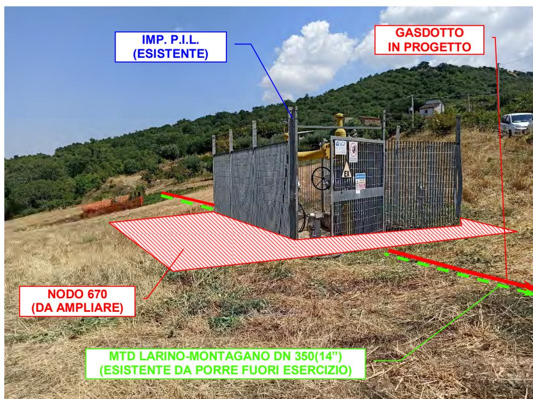
**Foto n°44** – Punto di Intercettazione di Linea – Nodo 670 da ampliare.
