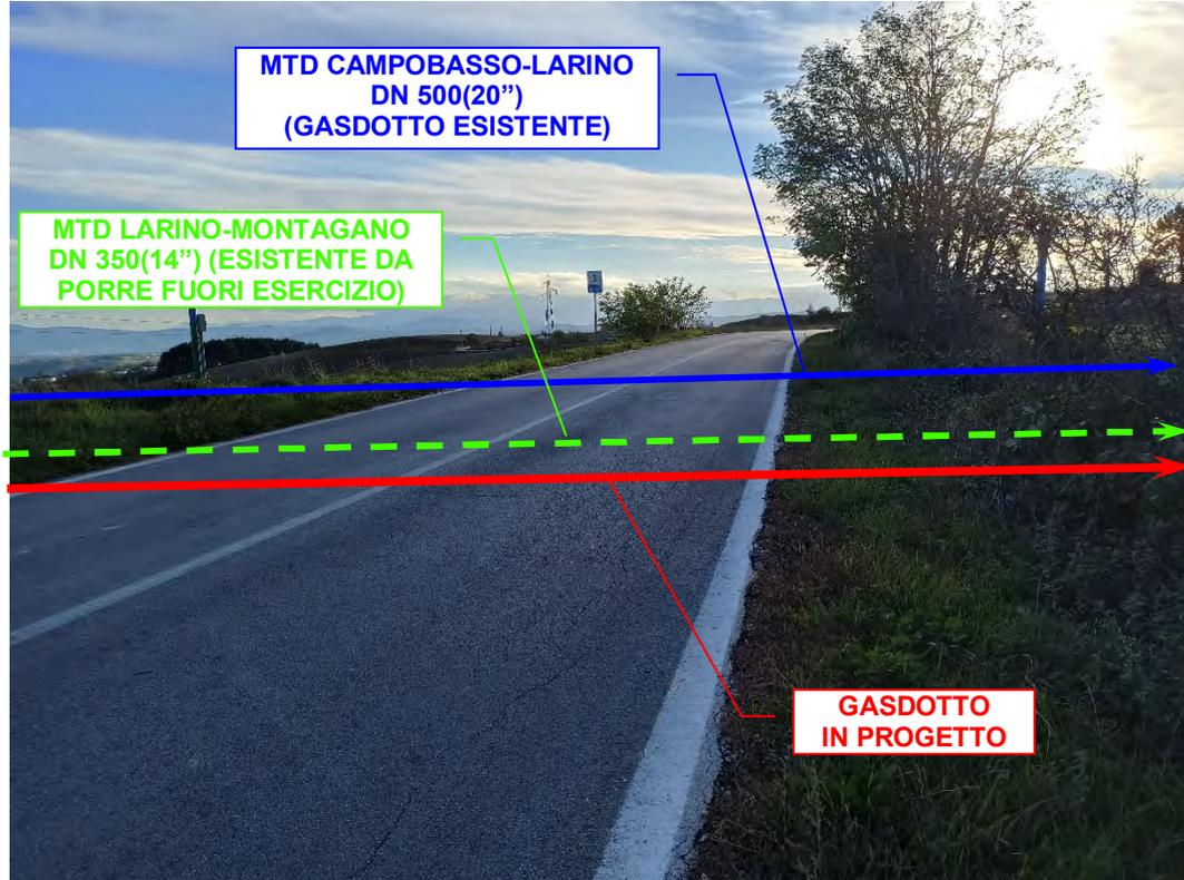
Foto n°100 – 3° Attraversamento Strada Provinciale n°13 con trivella spingitubo.
