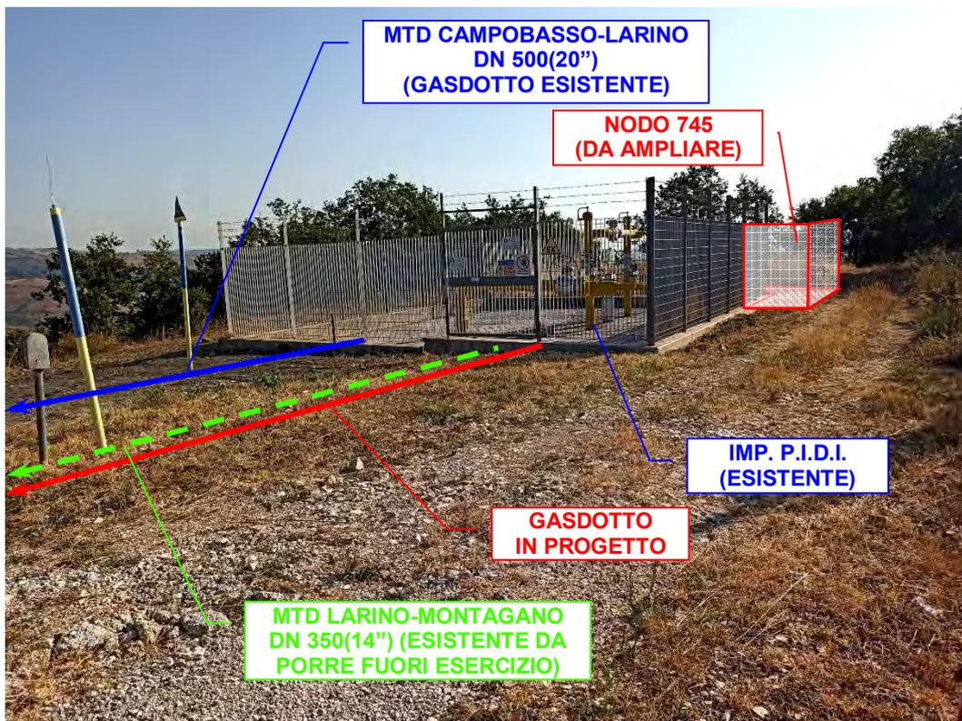
Foto n°77 – Punto di Intercettazione di Derivazione Importante (P.I.D.I.) – Nodo 745 da ampliare.
