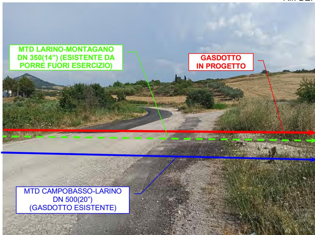
Foto n°66 – Attraversamento con scavo a cielo aperto della strada asfaltata e della *Strada Vicinale del Mulino* (identificata catastalmente).
