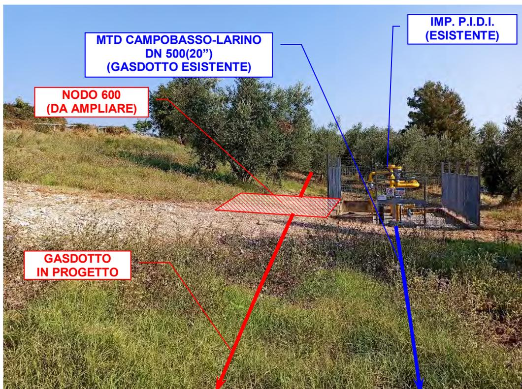
Foto n°12 – Vista Punto di Intercettazione di Derivazione Importante – Nodo 600 da ampliare.
