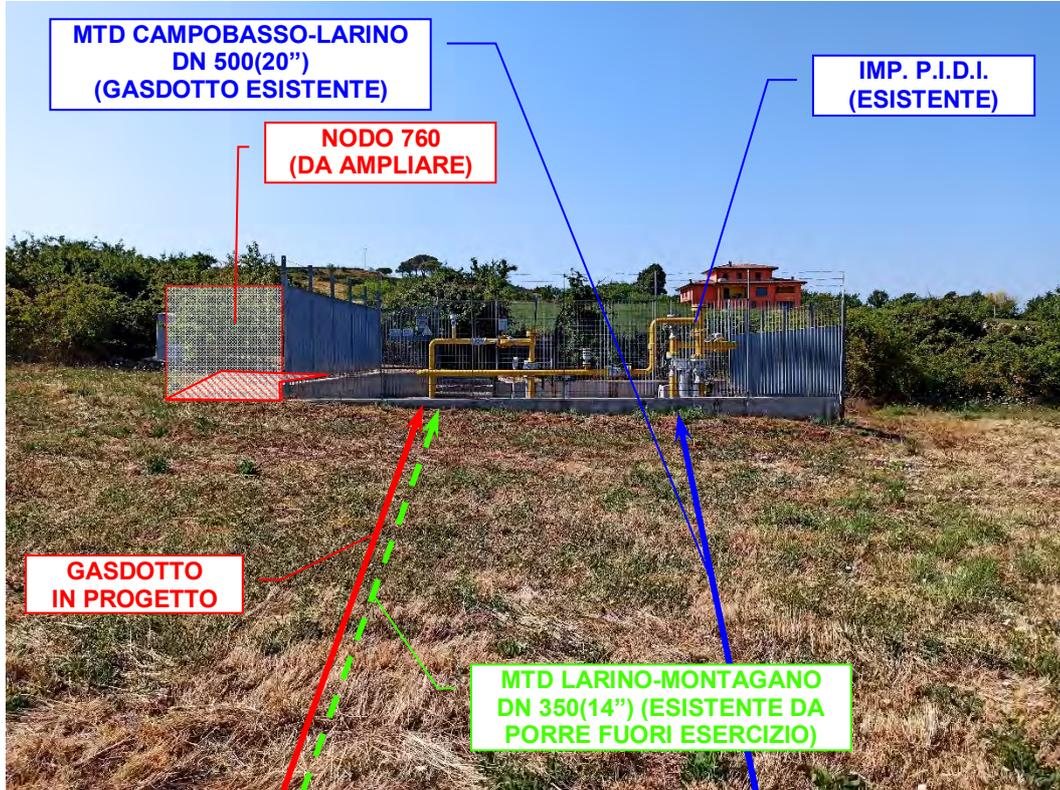
Foto n°84 – Punto di Intercettazione di Derivazione Importante – Nodo 760 da ampliare.
