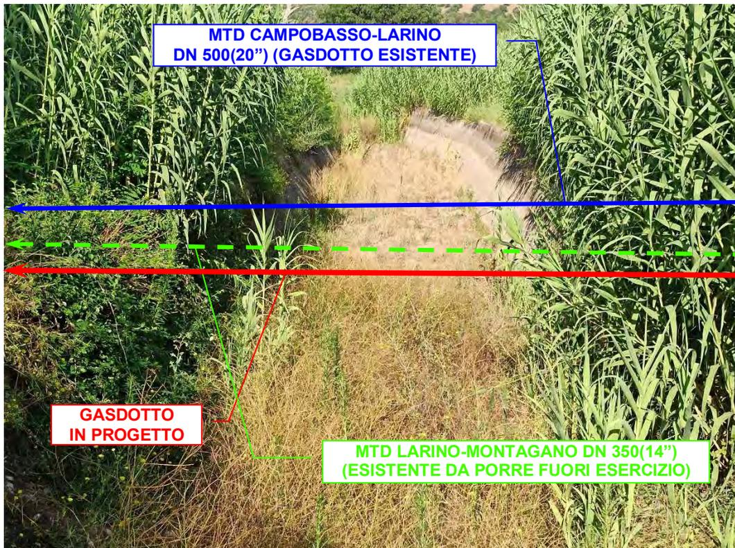
Foto n°38 – Attraversamento con spingitubo del Canale Enel rivestito in cls, in località *Valle Cupa*.
