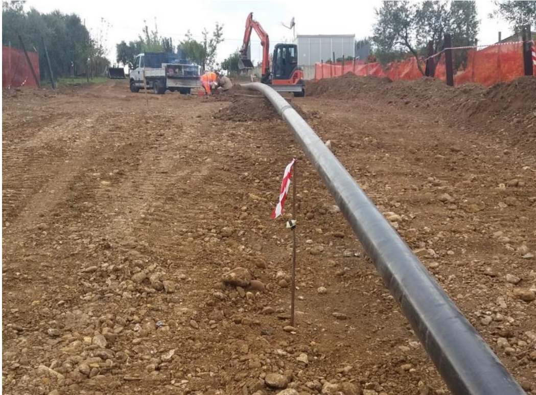
Fig. 6.5.1 - Saldatura della tubazione
