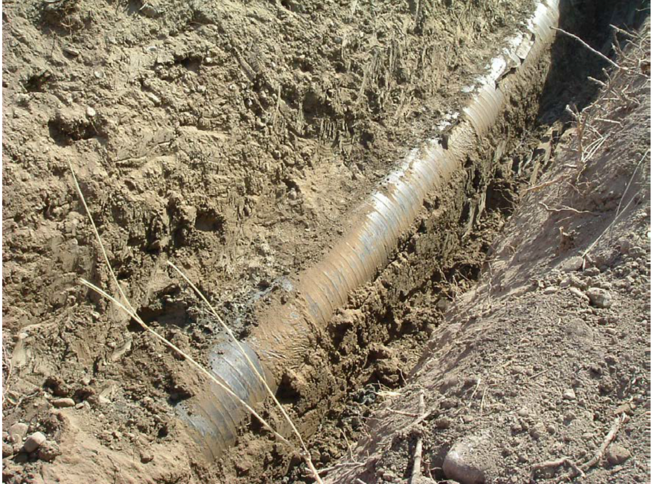
Fig. 7.3.1 – Scavo e scoperta della condotta esistente
