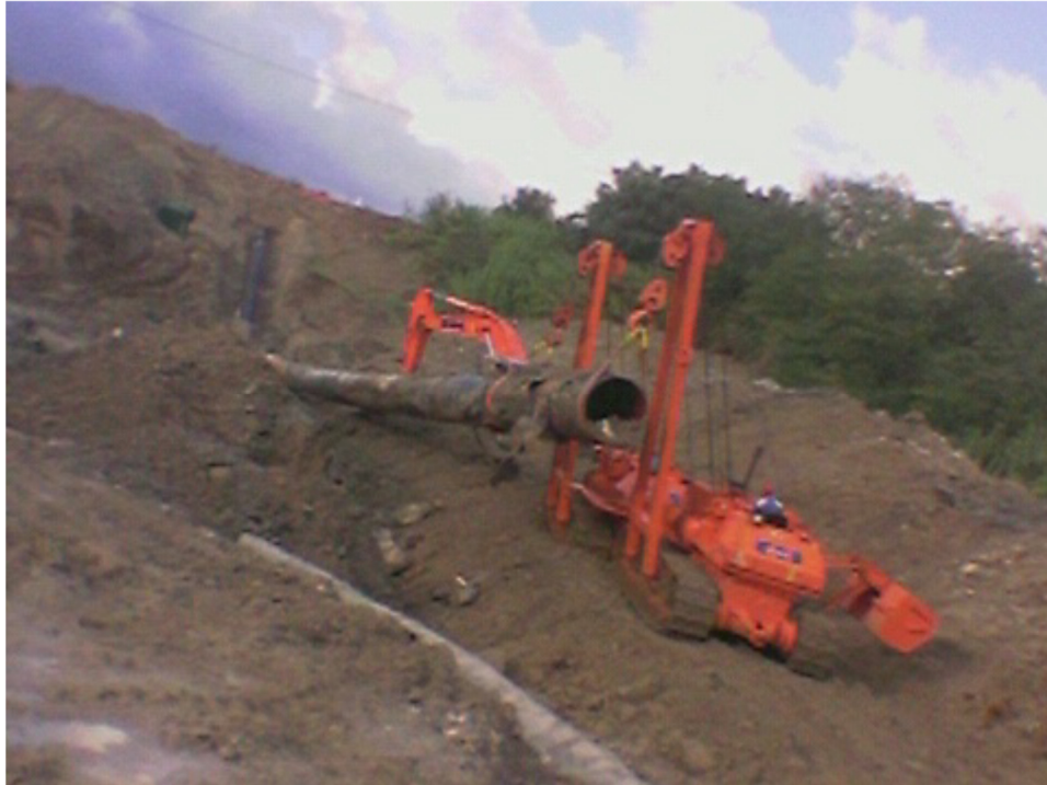
Fig. 7.4.1 – Sezionamento della condotta posta fuori esercizio
