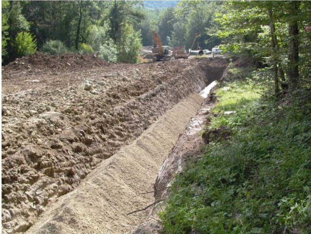
Fig. 6.12.1 – Posa e reinterro della condotta.
