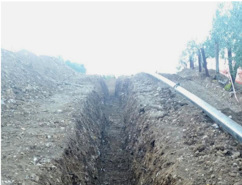
Fig. 6.7.1 - Scavo della trincea
