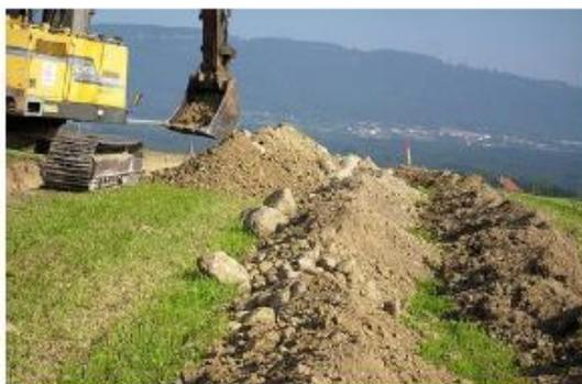
*Ripporto dello strato inferiore e superiore e rimozione del materiale di scavo superfluo.*
