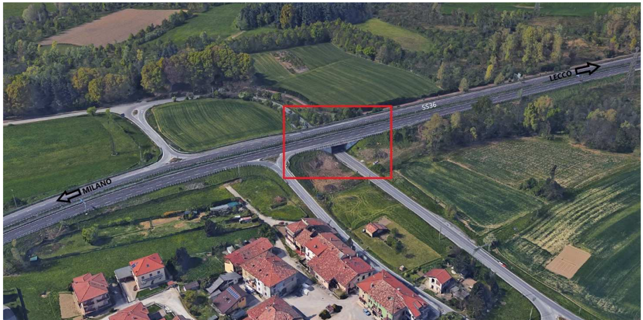
Figura 3-8 - Foto aerea del ponte di Veduggio
