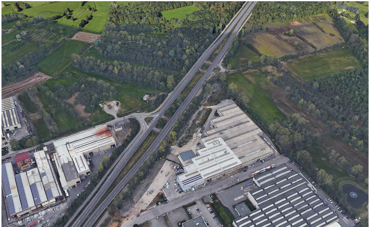
Figura 3-43 - vista aerea dello svincolo di Bosio Parini Nord
