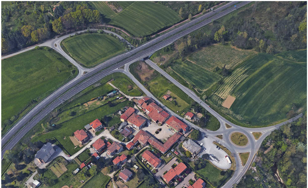
Figura 3-29 - Vista aerea dello svincolo di Veduggio con Colzano
