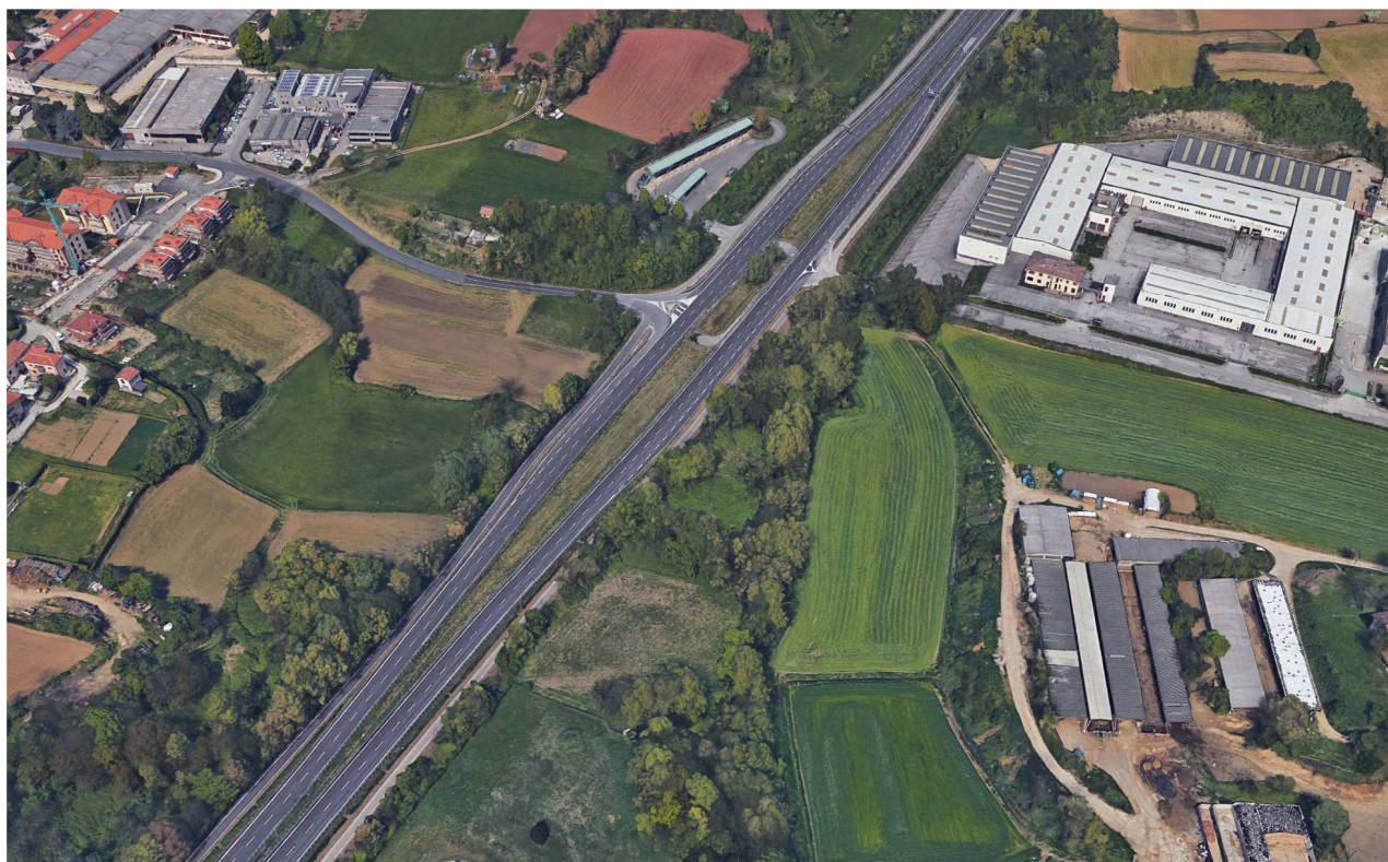
Figura 3-41 - Vista aerea dello svincolo di Cibrone
