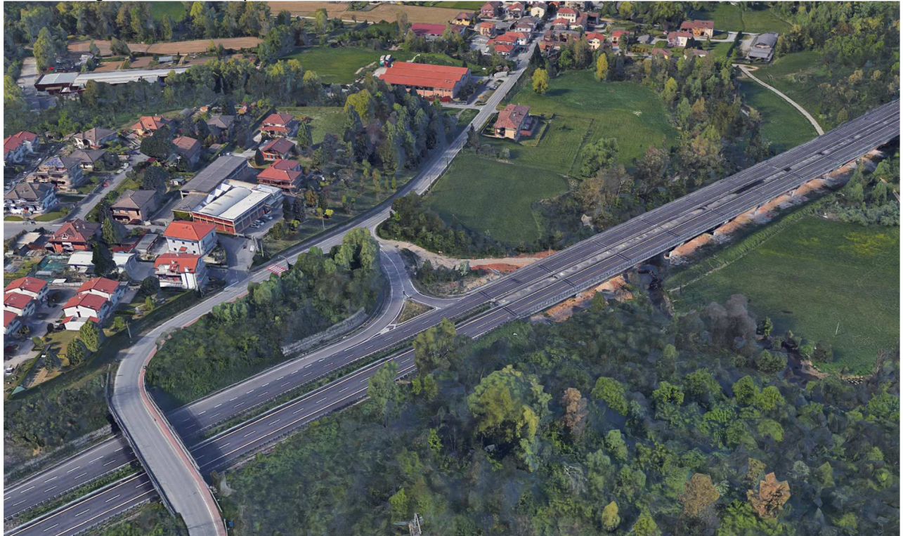
Figura 3-25 - Vista aerea dello svincolo Fornaci
