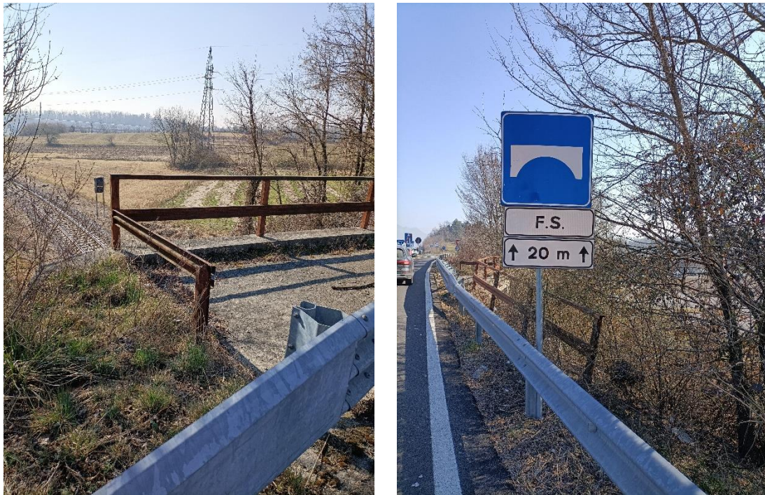
Figura 17 – Cavalcavia ferroviario nel tratto di S.S. 36 oggetto della trattazione
