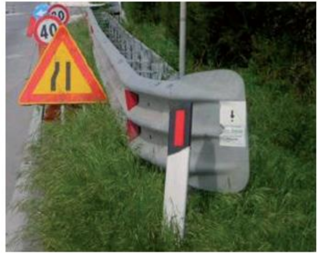
Figura 19 – Terminali semplici (fonte Quaderno tecnico Anas Vol. VI )
