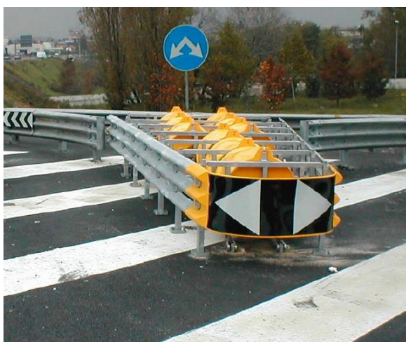
Figura 25 – Tipologico attenuatore d'urto redirettivo Classe 80
