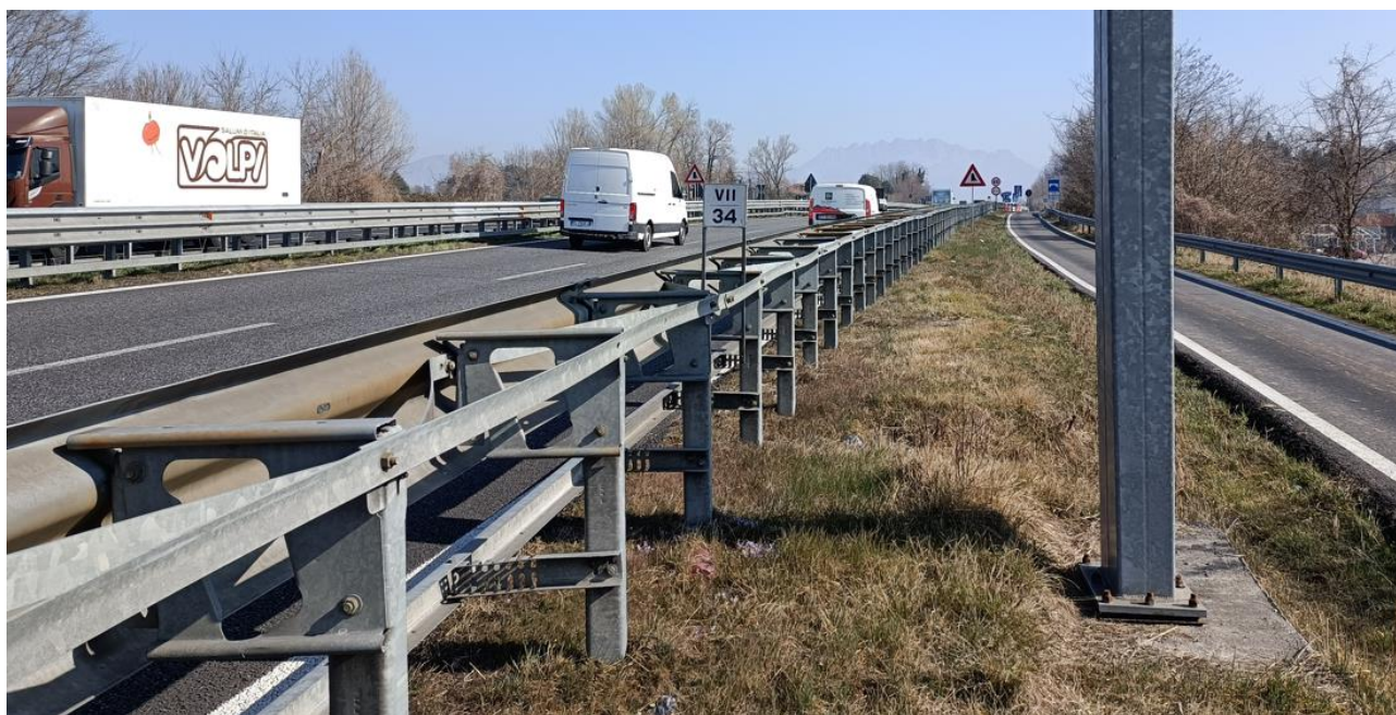
Figura 9 – Esempio di ostacolo non abbattibile installato correttamente
