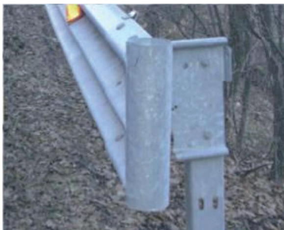
Figura 22 - Elemento terminale tubolare (fonte Quaderno tecnico Anas Vol. VI)
