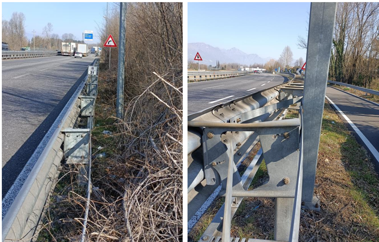
Figura 8 – Esempi di ostacoli non abbattibili in prossimità della barriera stradale lungo la S.S. 36
