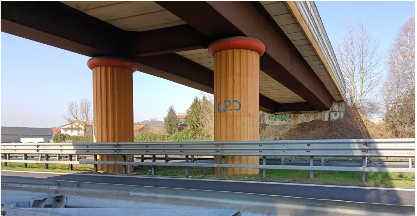
Figura 26 – Pile del viadotto all'interno dello spartitraffico al km 32+580
