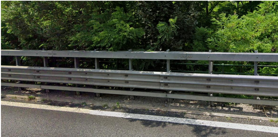
Figura 14 – Barriera tipologia Bordo ponte oggetto dell'intervento
