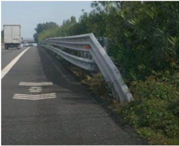
Figura 19 – Terminali semplici (fonte Quaderno tecnico Anas Vol. VI )
