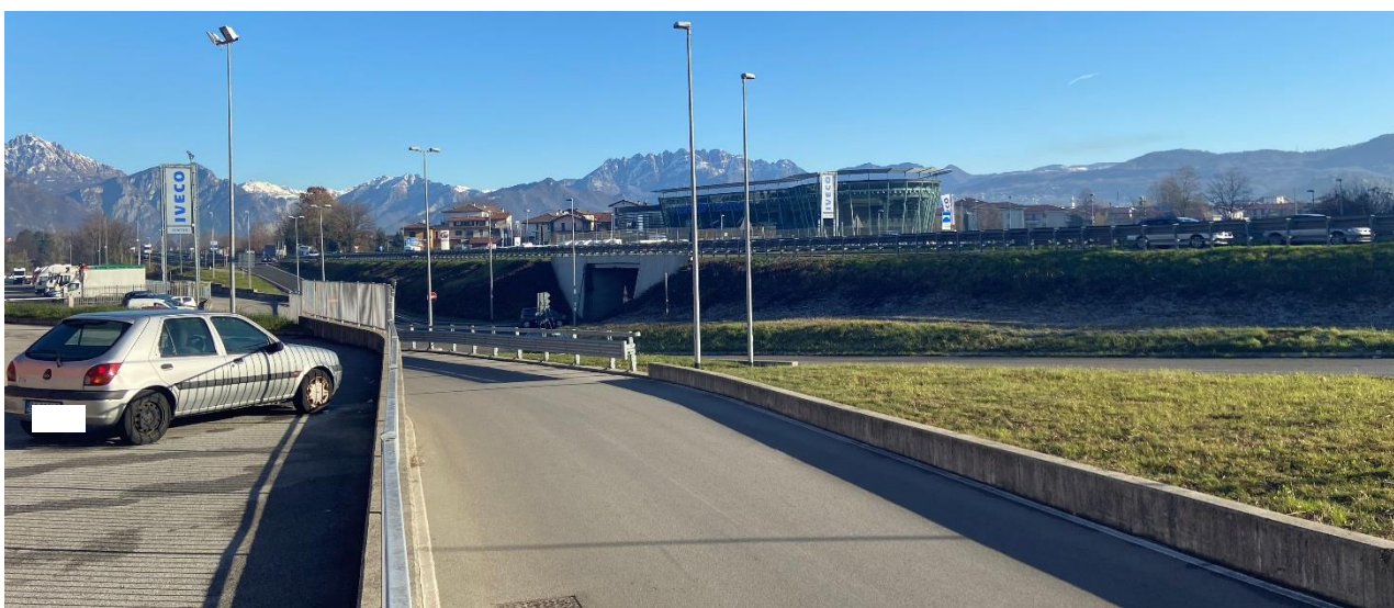
Figura 108: Vista da sud-ovest della SS36 all'altezza del km 37+1 (vista 12).
