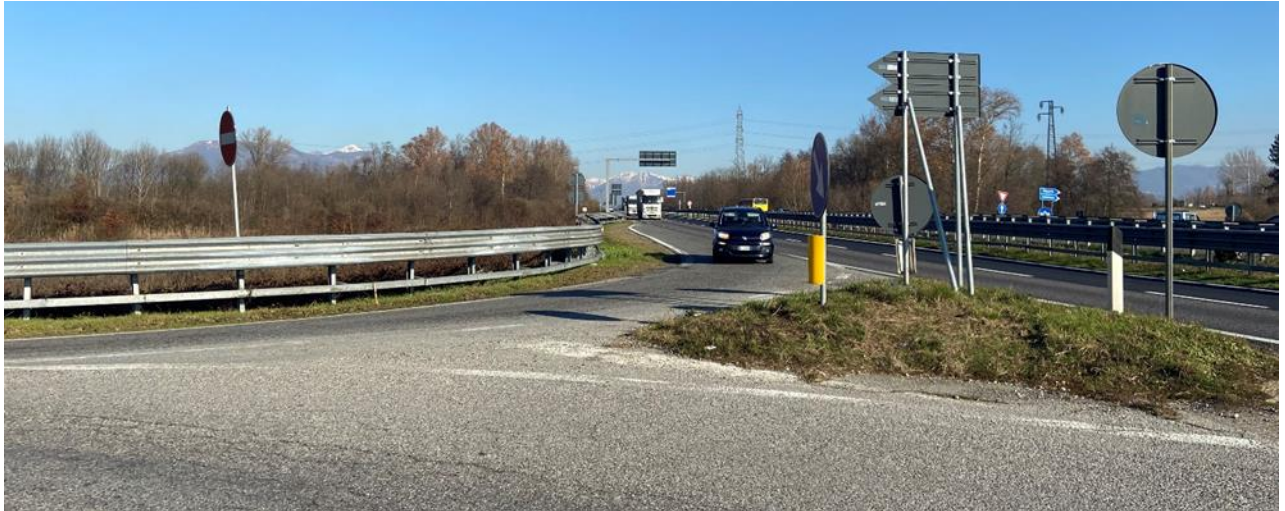
Figura 57: Vista da sud-est - Corsia di decelerazione D2 (vista 1).
