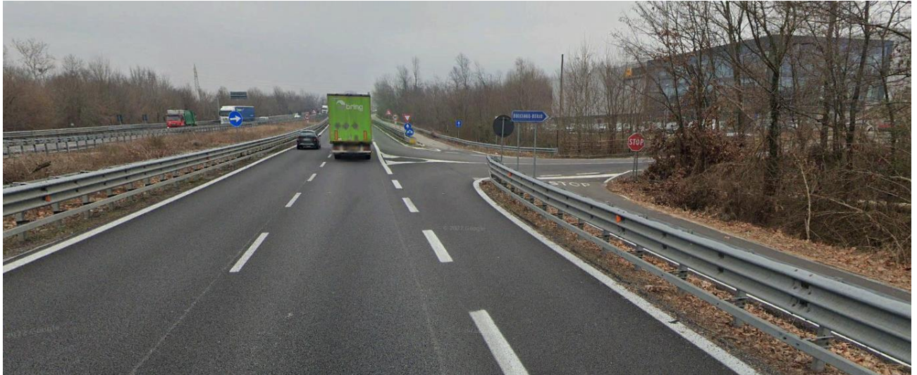
Figura 70: Vista dalla SS36 direzione Lecco, sulla destra lo svincolo Cibrone (vista 1).
