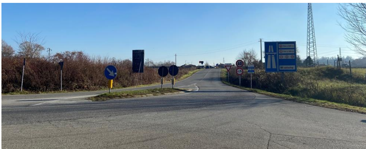
Figura 62: Vista da nord-ovest - Corsia di decelerazione D2 (vista 6).
