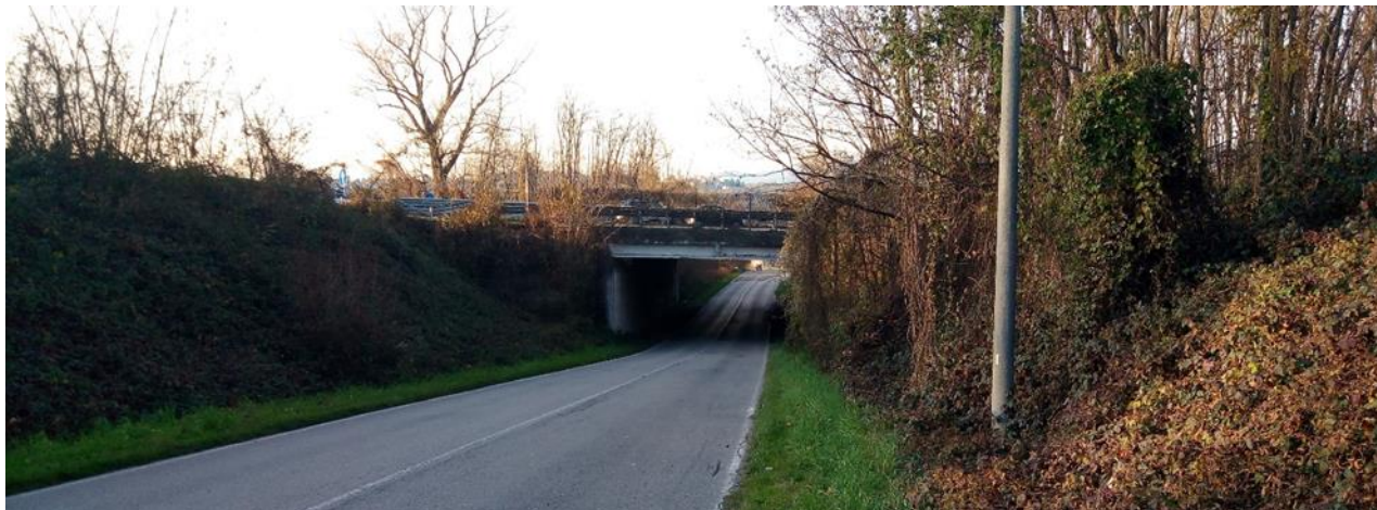
Figura 48: Vista da sud-est - Ponte Capriano.
