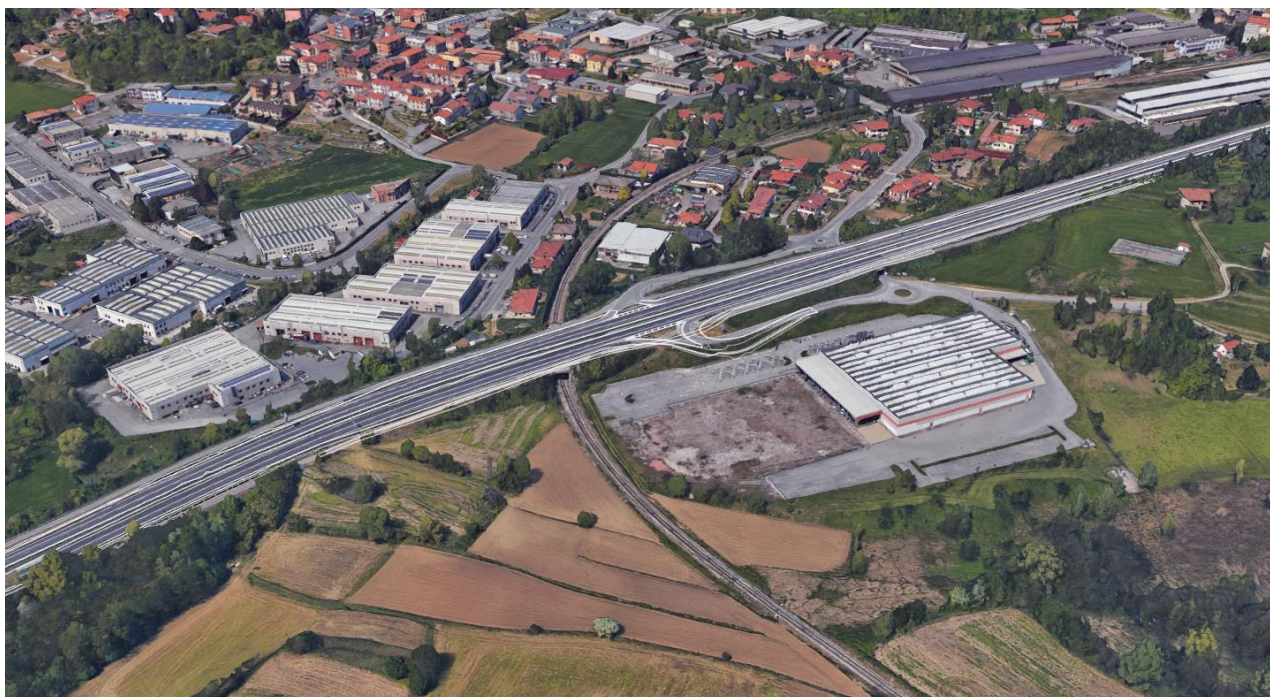
Figura 73: Vista a volo d'uccello da sud (Fonte: Google Earth) – Svincolo Costa Masnaga Sud
