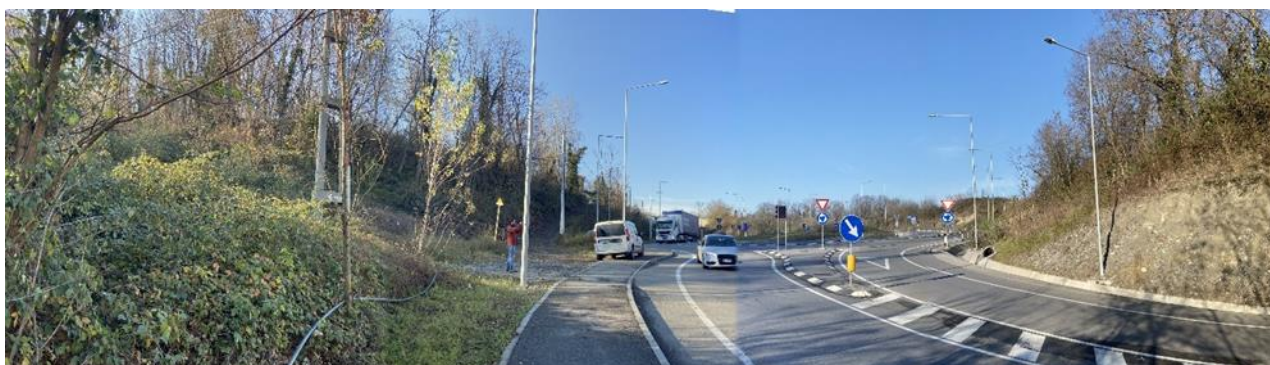
Figura 19: Vista da sud-est della curva Briosco oggetto di adeguamento (vista 2).
