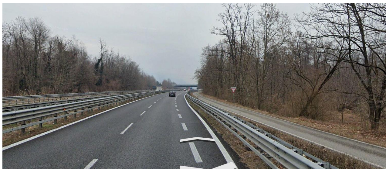
Figura 111: Vista lungo la SS36 dir. nord km 39+1 (vista 15). Fonte: Google maps.
