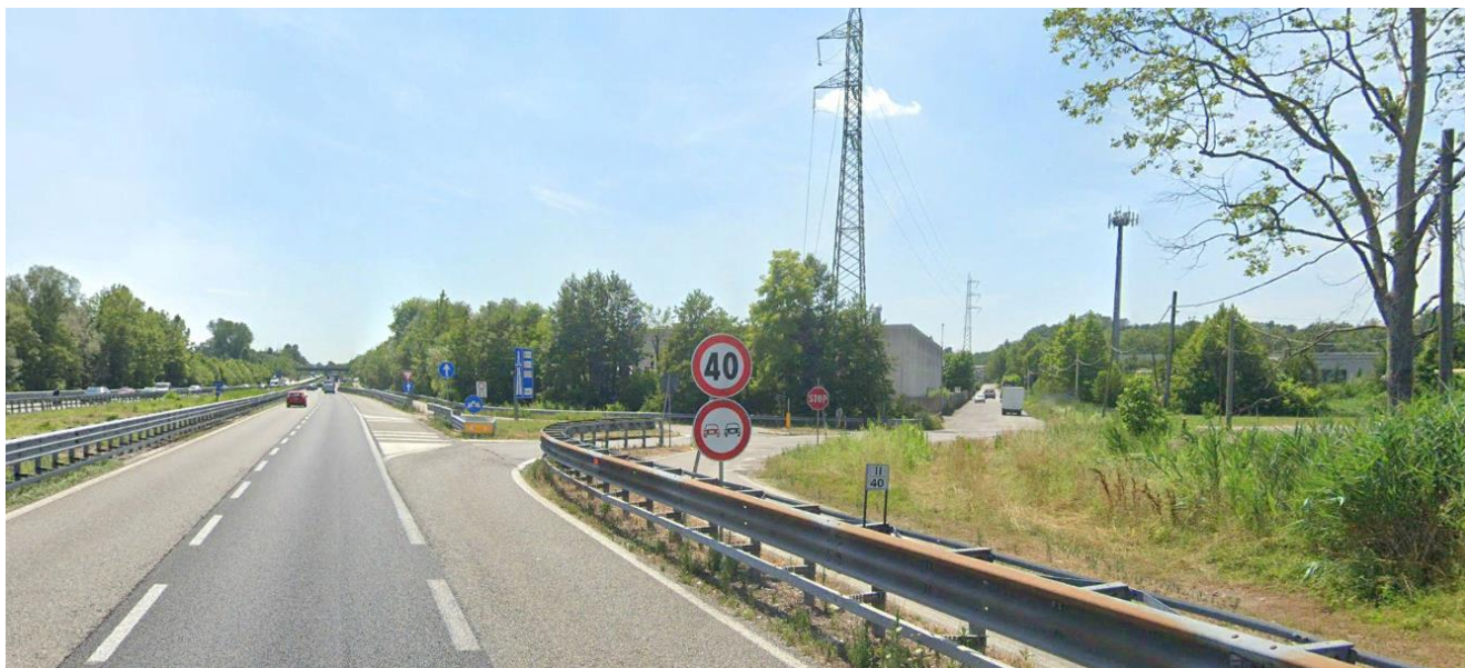
Figura 86: Vista da nord – Svincolo Bosisio Parini Nord – direzione Milano (vista 1).
