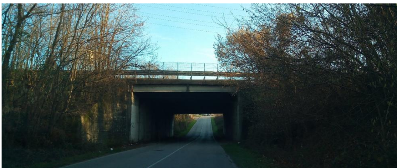
Figura 50: Vista da nord-ovest - Ponte Capriano.
