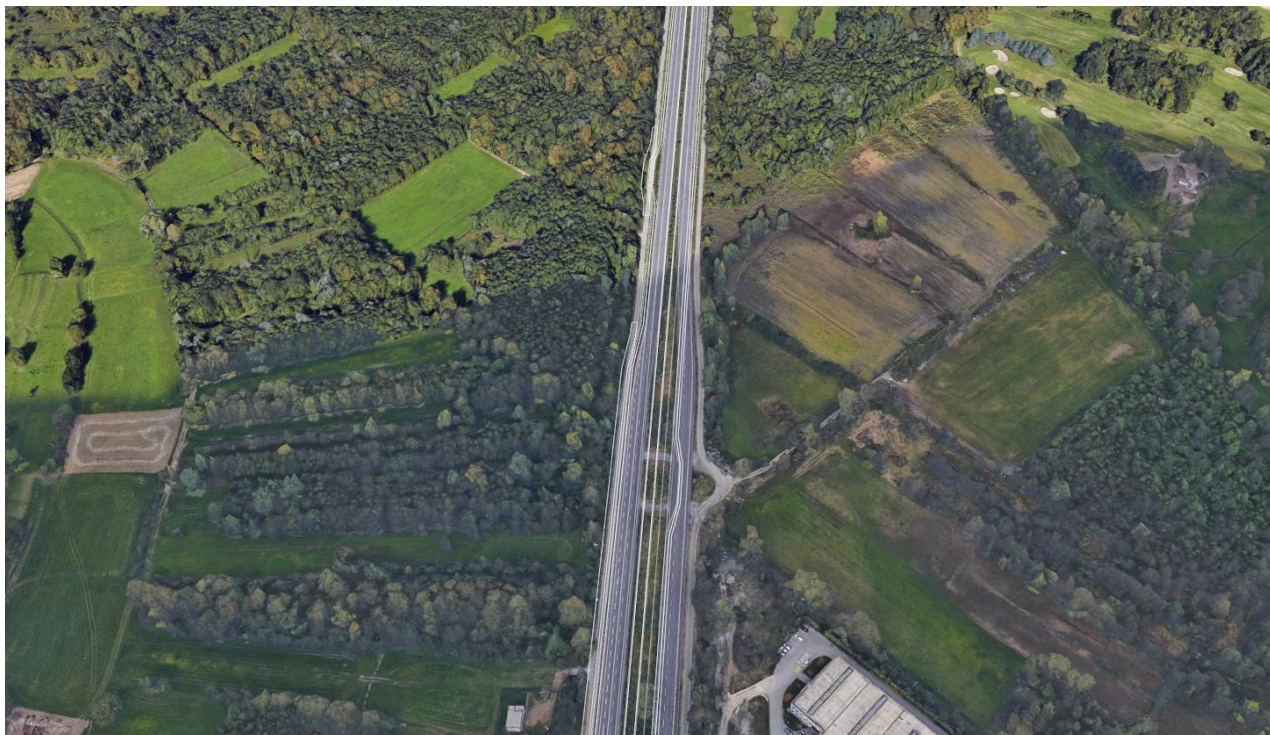
Figura 87: Vista a volo d'uccello da sud (Fonte: Google Earth) – Piazzole di sosta PS4
