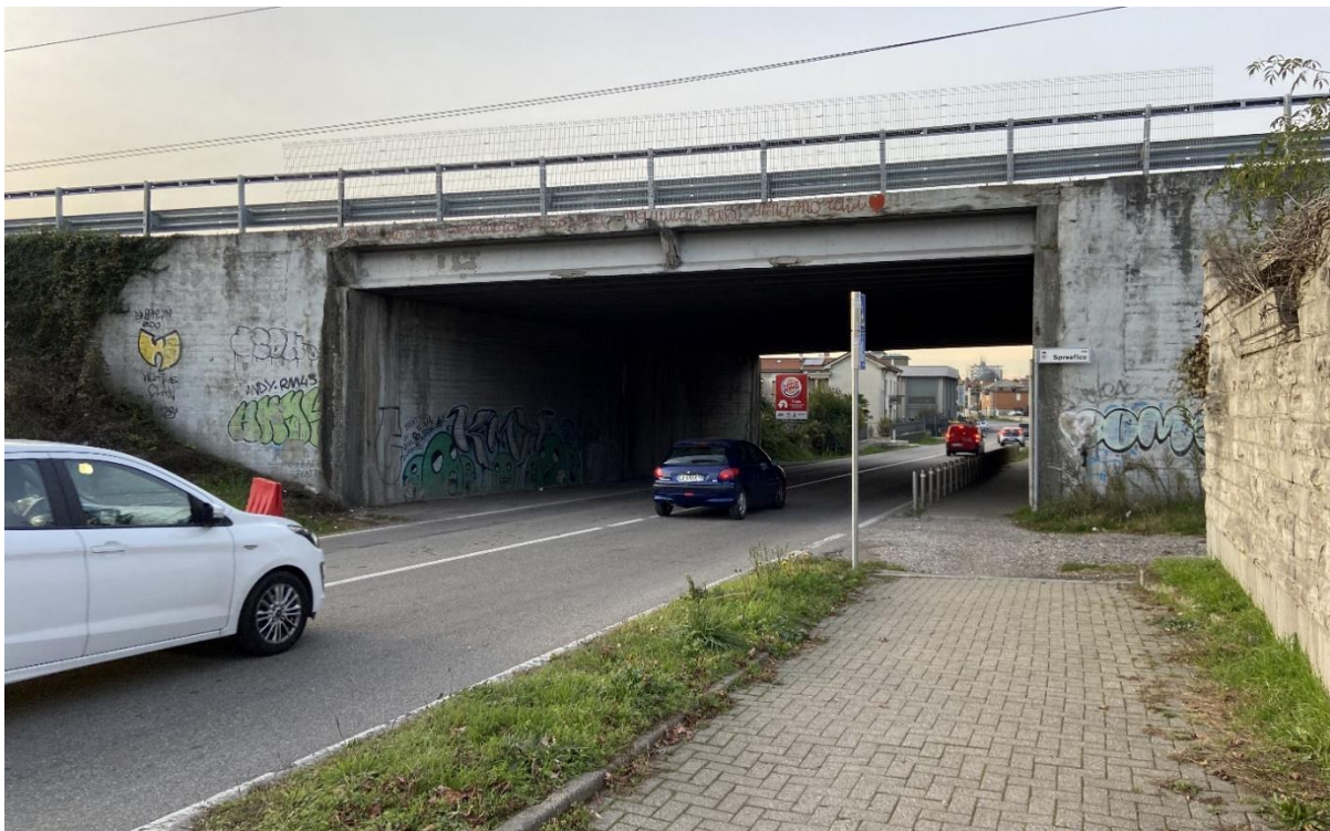
Figura 7: Vista del Ponte Giussano oggetto di adeguamento da est (vista 3).
