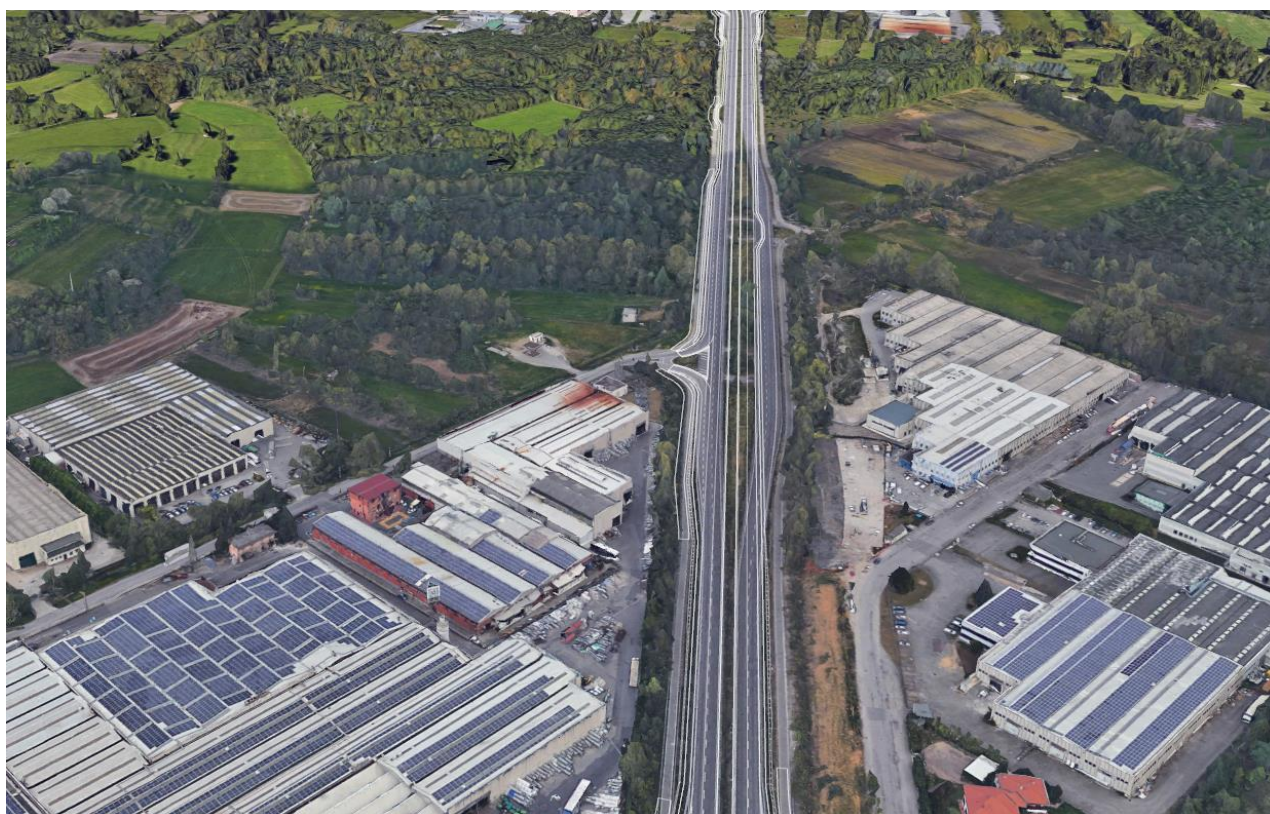
Figura 82: Vista a volo d'uccello da nord (Fonte: Google Earth) – Svincolo Bosisio Parini Nord
