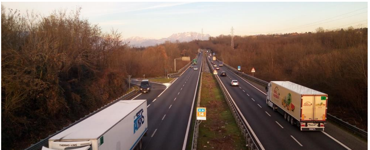
Figura 38: Vista da sud-ovest della corsia di decelerazione D1 (vista 6).
