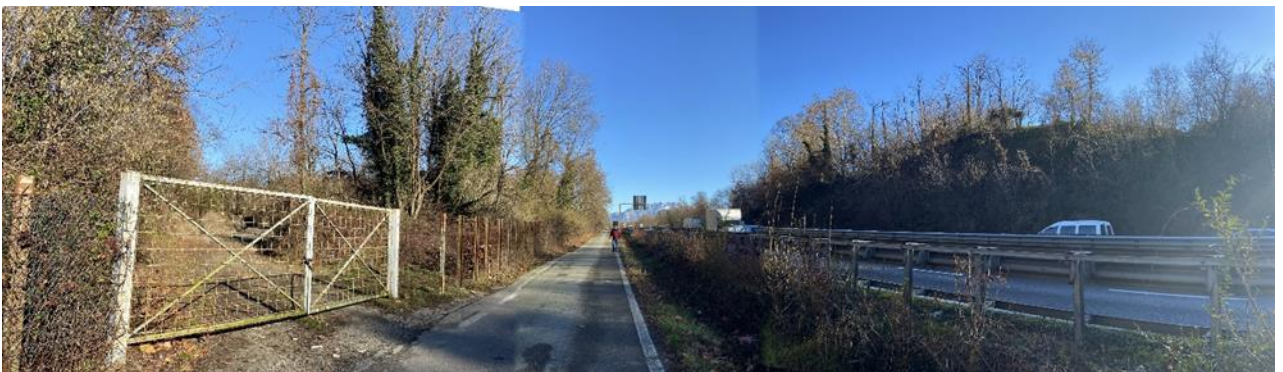
Figura 76: Vista da sud-ovest - Piazzole di sosta PS2 (vista 2).
