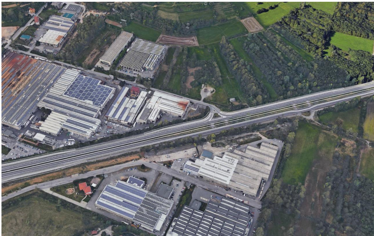
Figura 82: Vista a volo d'uccello da est (Fonte: Google Earth) – Svincolo Bosisio Parini Nord
