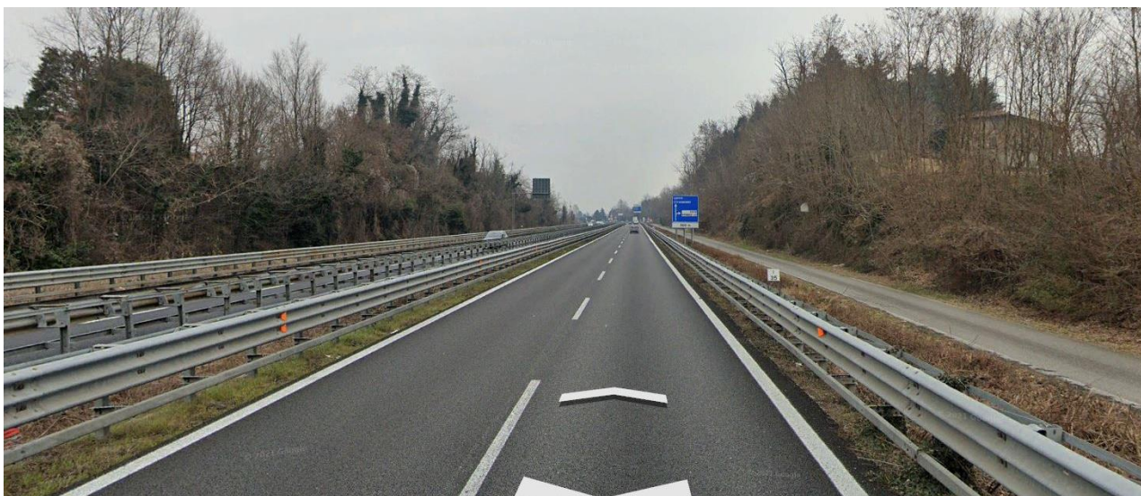
Figura 107: Vista lungo la SS36 dir. nord km 35+1 (vista 11). Fonte: Google maps.
