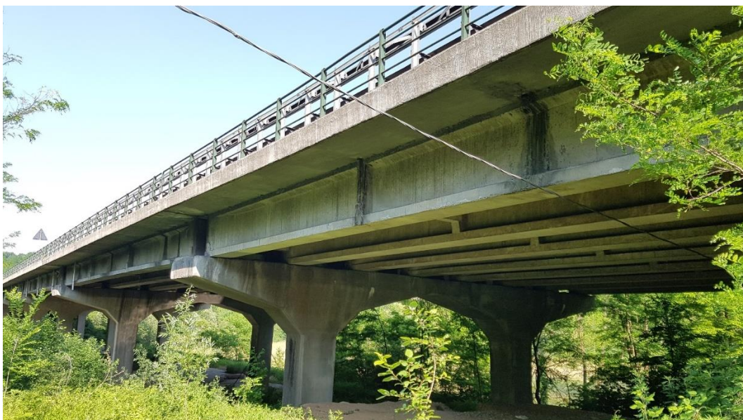
Figura 39: Vista da ovest della corsia di decelerazione D1 (vista 7).
