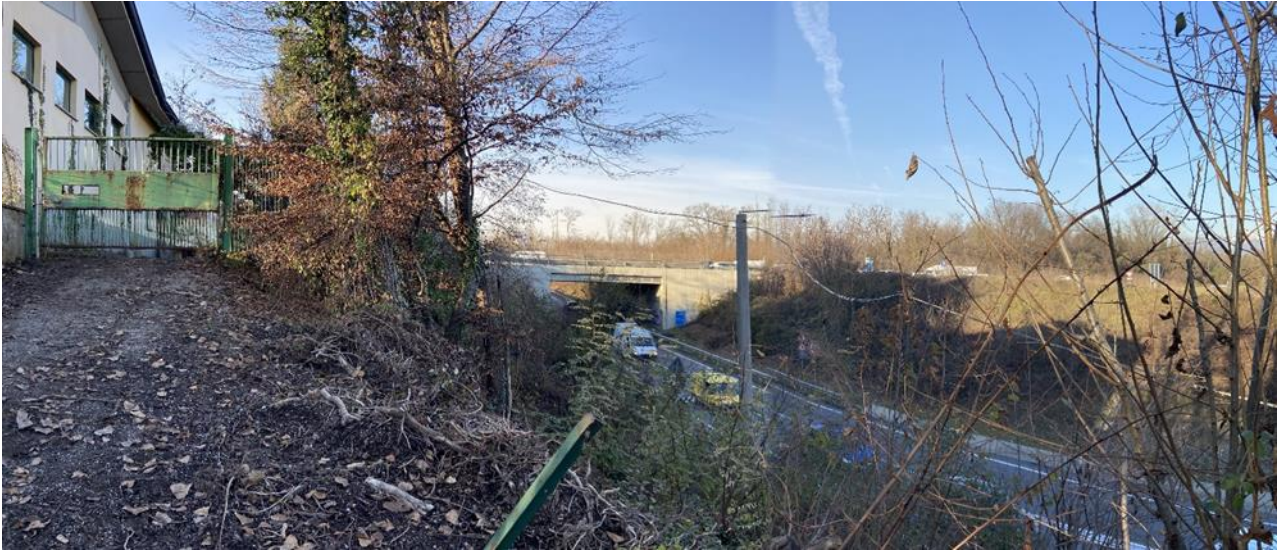
Figura 22: Vista del ricettore disabilitato prossimo alle aree di intervento (vista 5).
