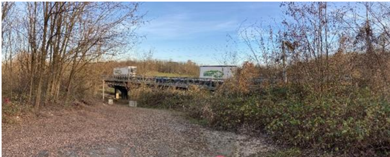
Figura 33: Vista da ovest della corsia di decelerazione D1 (vista 1).
