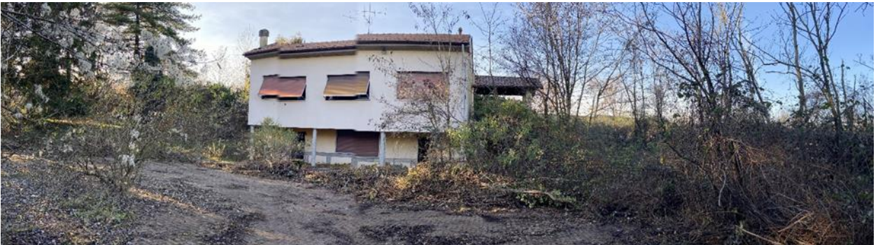
Figura 24: Vista dell'edificio da demolire per la nuova configurazione della curva Briosco (vista 7).
