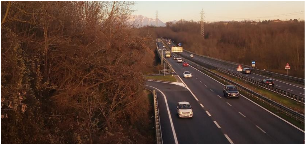
Figura 37: Vista da sud-ovest della corsia di decelerazione D1 (vista 5).
