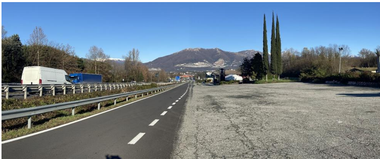
Figura 84: Vista da sud - Piazzole di sosta PS3 – direzione Lecco (vista 1).
