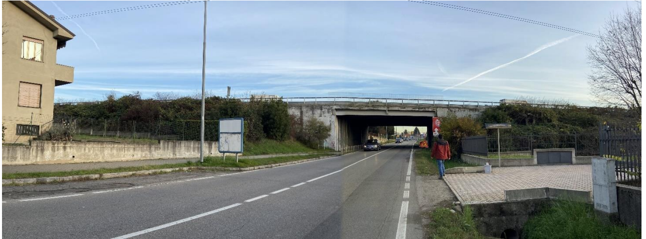
Figura 5: Vista del Ponte Giussano oggetto di adeguamento da ovest (vista 1).
