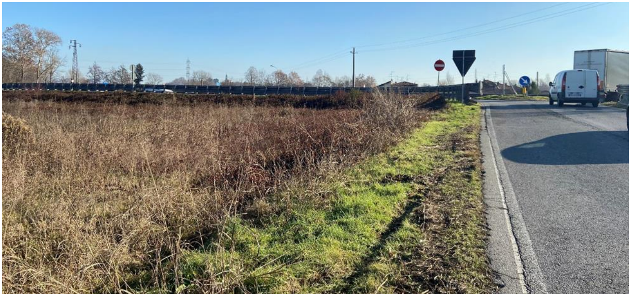
Figura 58: Vista da nord-ovest - Corsia di decelerazione D2 (vista 2).
