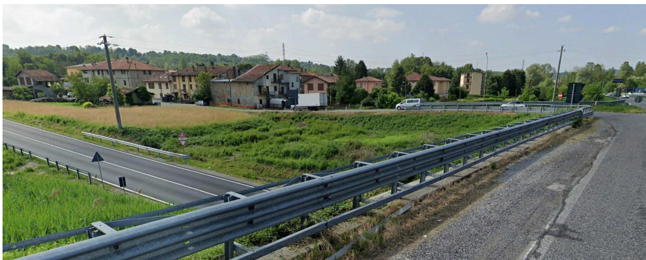
Figura 68: Vista da nord - Svincolo Veduggio dalla SS36, sullo sfondo il nucleo di Cascina Tremolada (vista 12).
