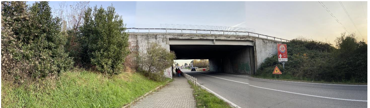
Figura 6: Vista del Ponte Giussano oggetto di adeguamento da ovest (vista 2).
