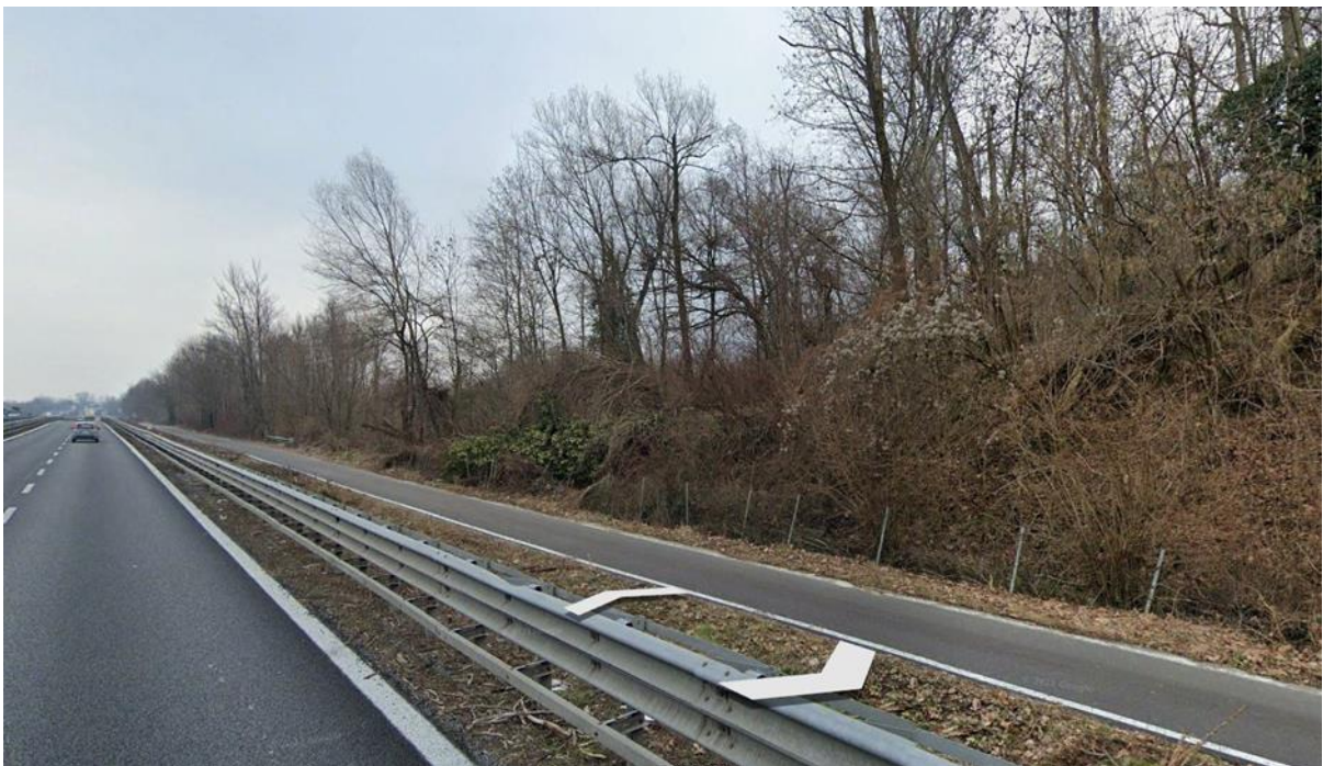
Figura 78: Vista da nord-est - Piazzole di sosta PS2 (vista 5).
