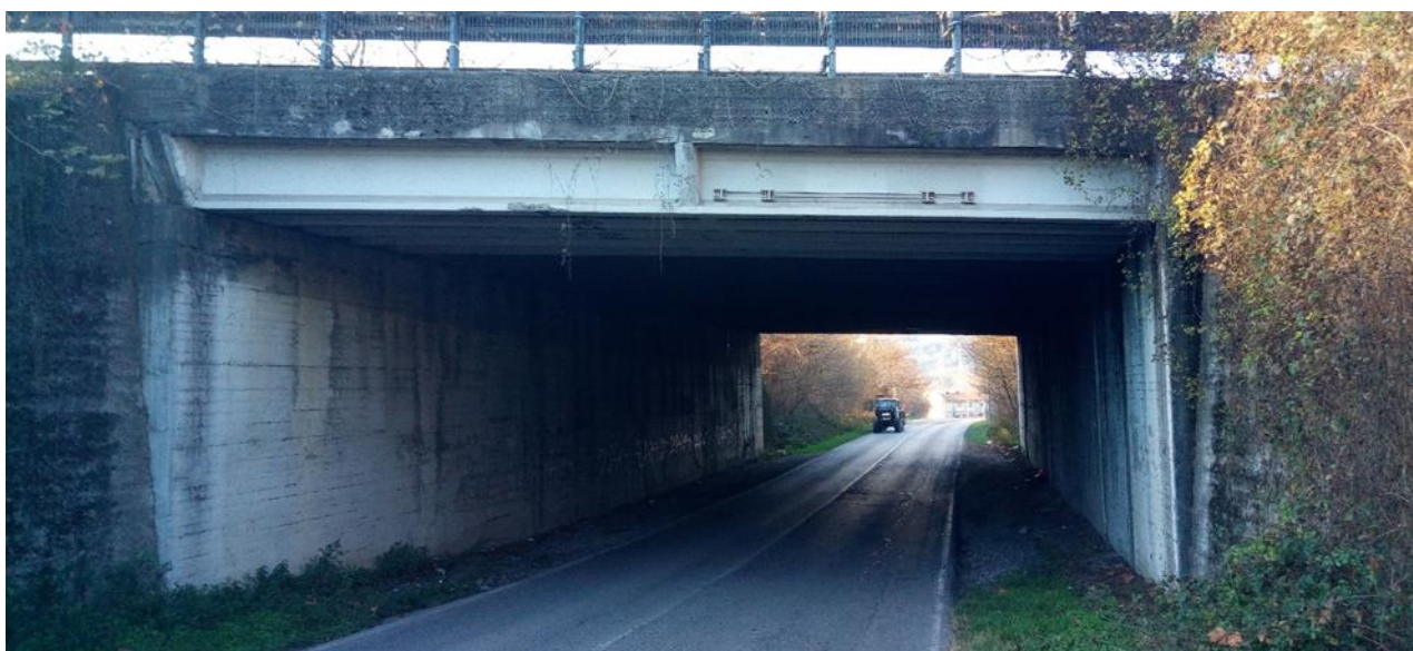
Figura 49: Vista da sud-est - Ponte Capriano.
