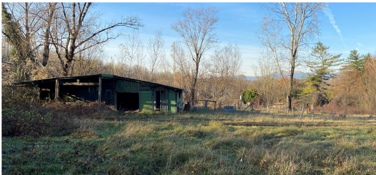
Figura 26: Vista da nord dell'area dove è previsto l'adeguamento della curva Briosco (vista 9).
