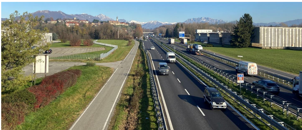
Figura 103: Vista della SS36 dir. nord km 32+6 (vista 7).
