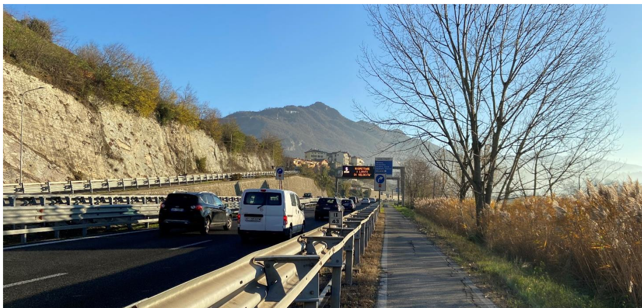
Figura 115: Vista della SS36 dir. nord km 43+9 (vista 19).
