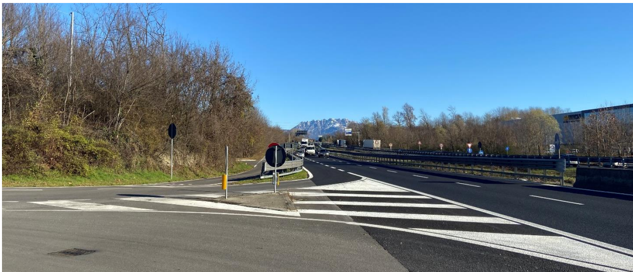
Figura 106: Vista lungo la SS36 dir. nord km 34+3 (vista 10).
