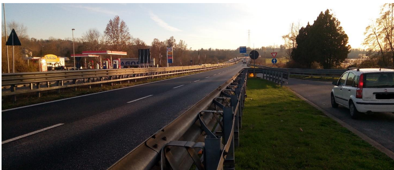
Figura 77 Vista lungo la SS36 dir. sud km 31+2 (vista 6).
