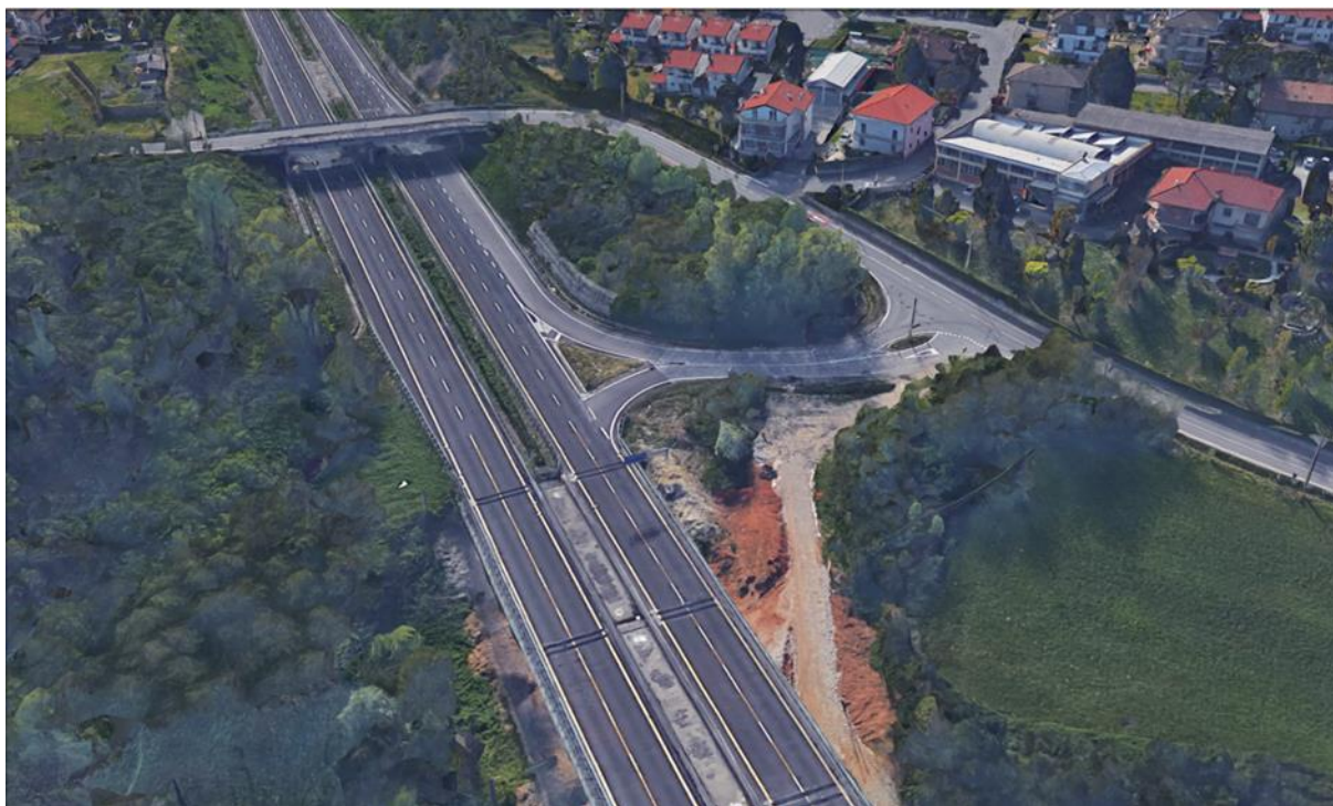
Figura 30: Vista a volo d'uccello da nord-est (Fonte: Google Earth) – Corsia di decelerazione D1.
