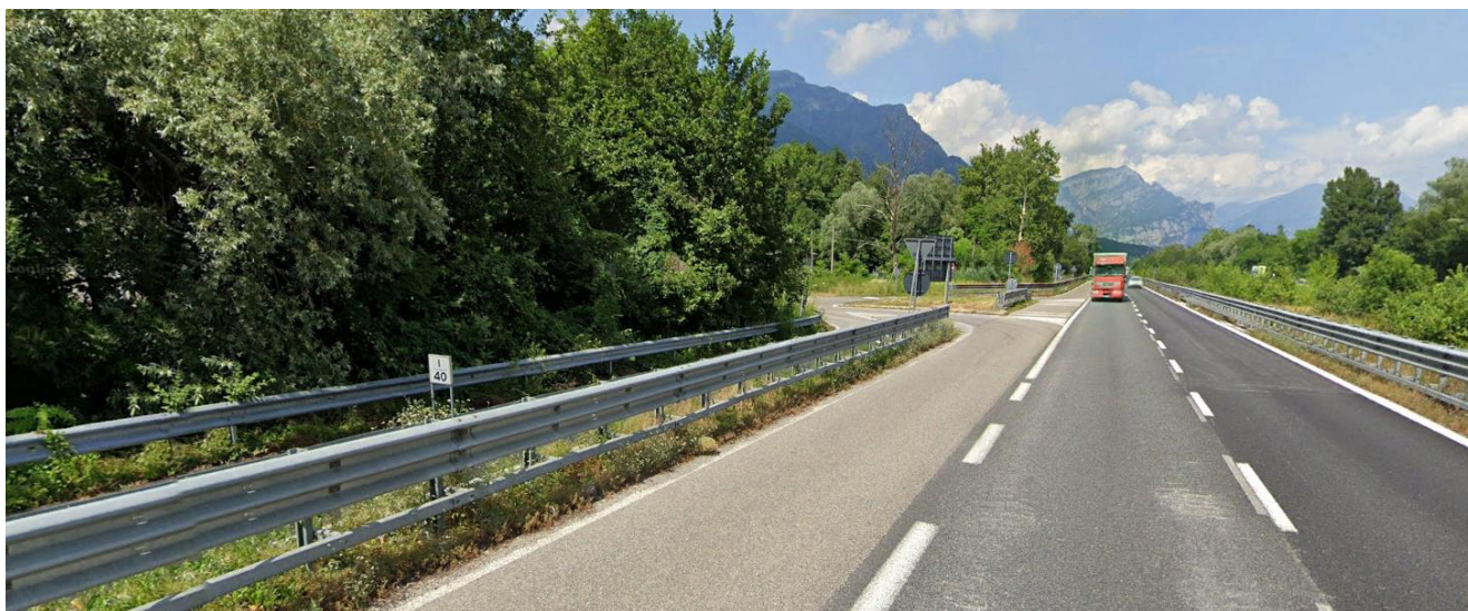
Figura 86: Vista da sud – Svincolo Bosisio Parini Nord – direzione Milano (vista 2).
