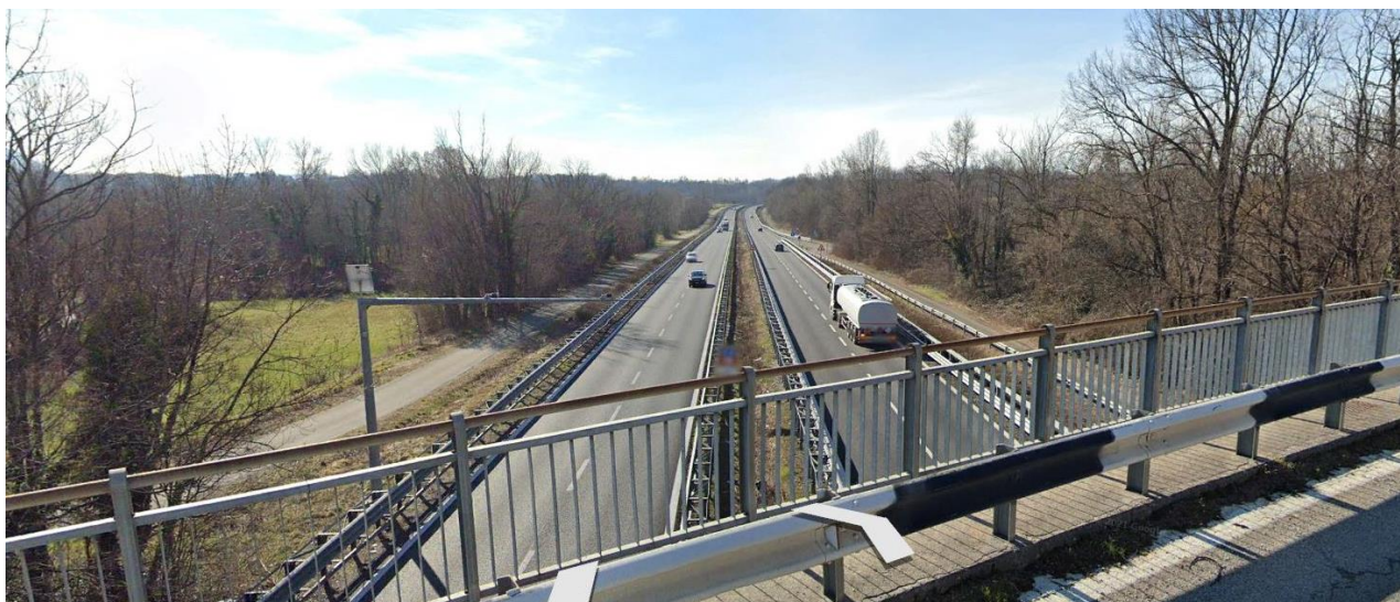
Figura 113: Vista della SS36 dir. sud km 42+4 (vista 17). Fonte: Google maps.
