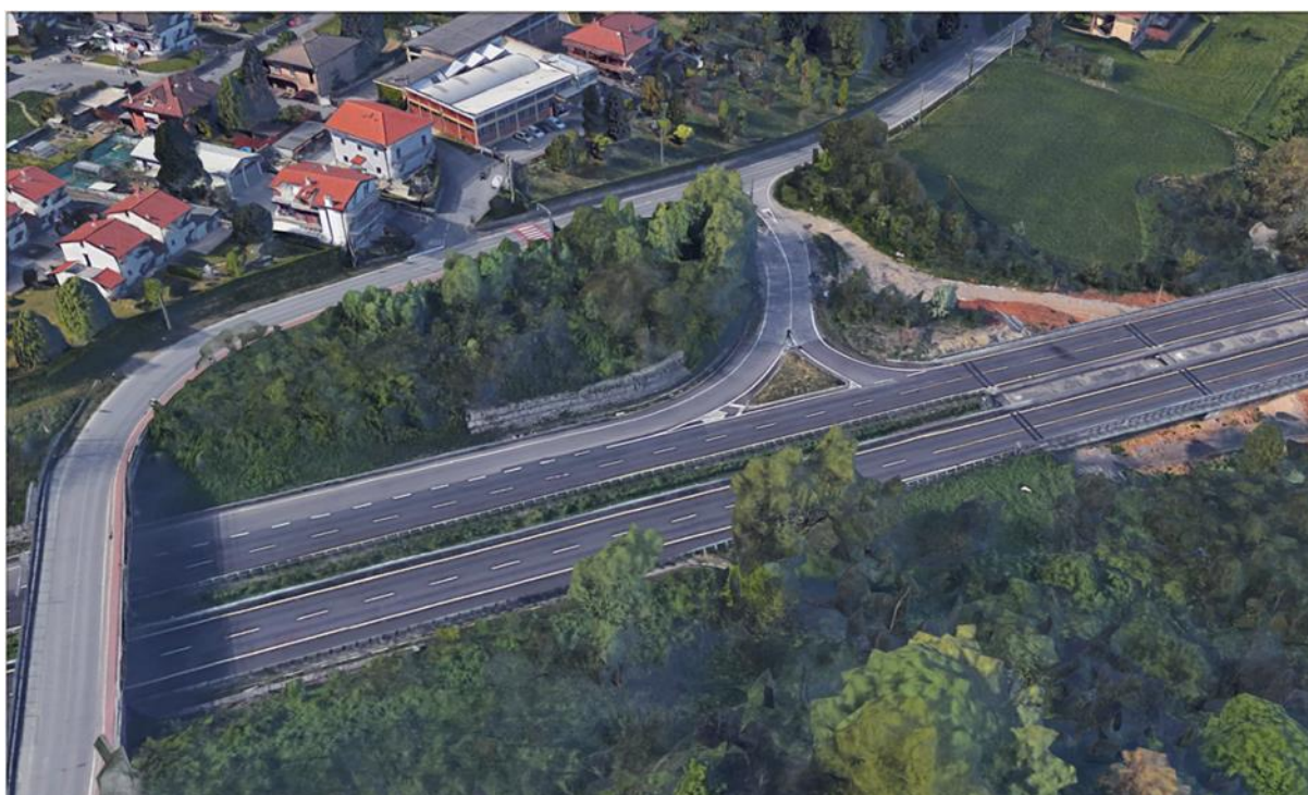
Figura 29: Vista a volo d'uccello da sud-est (Fonte: Google Earth) – Corsia di decelerazione D1.
