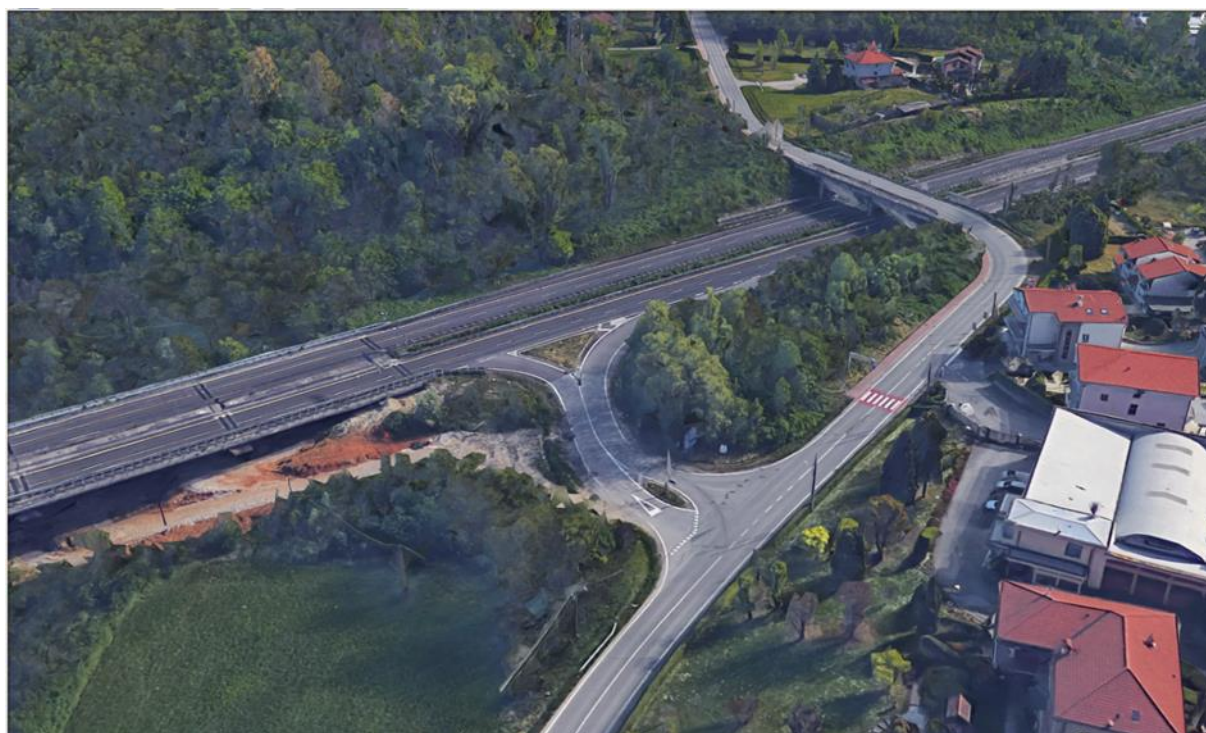
Figura 31: Vista a volo d'uccello da nord-ovest (Fonte: Google Earth) – Corsia di decelerazione D1.
