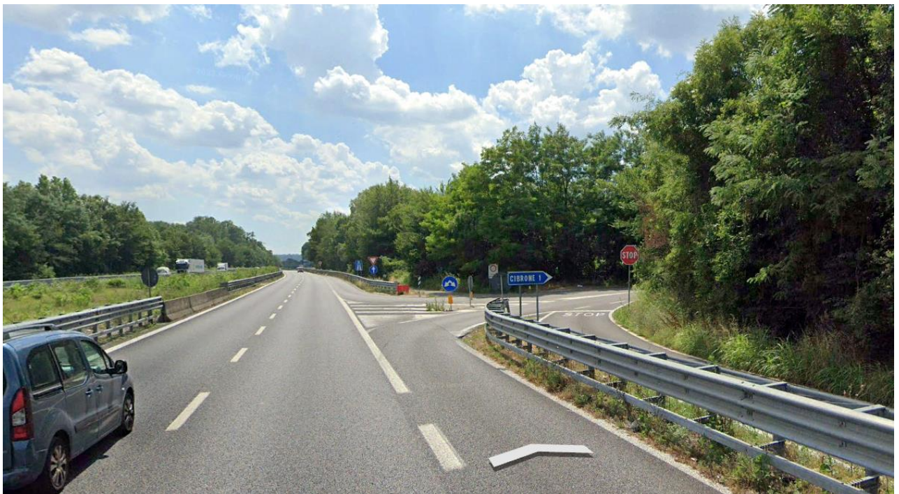
Figura 70: Vista dalla SS36 direzione Milano, sulla destra lo svincolo Cibrone (vista 2).
