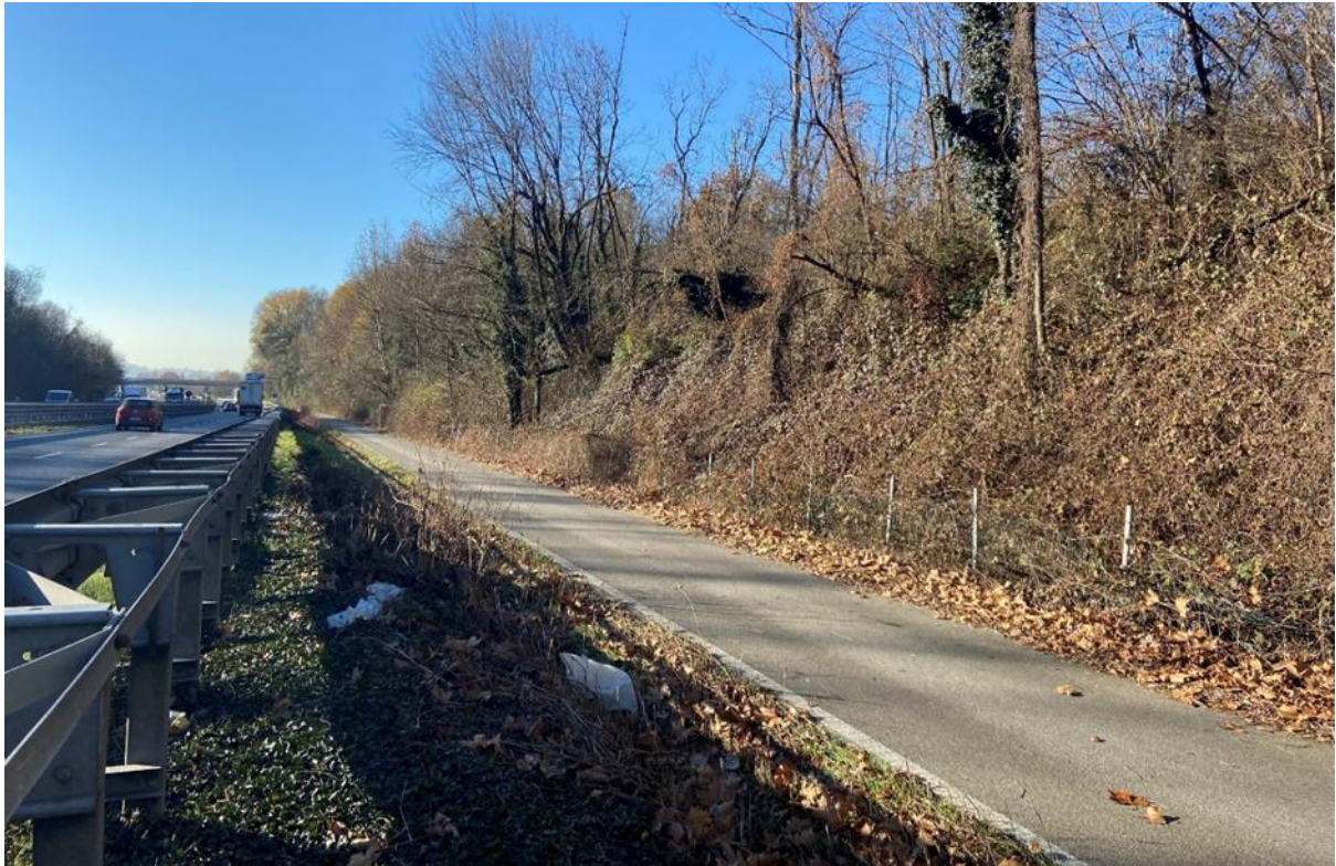
Figura 78: Vista da nord-est - Piazzole di sosta PS2 (vista 4).
