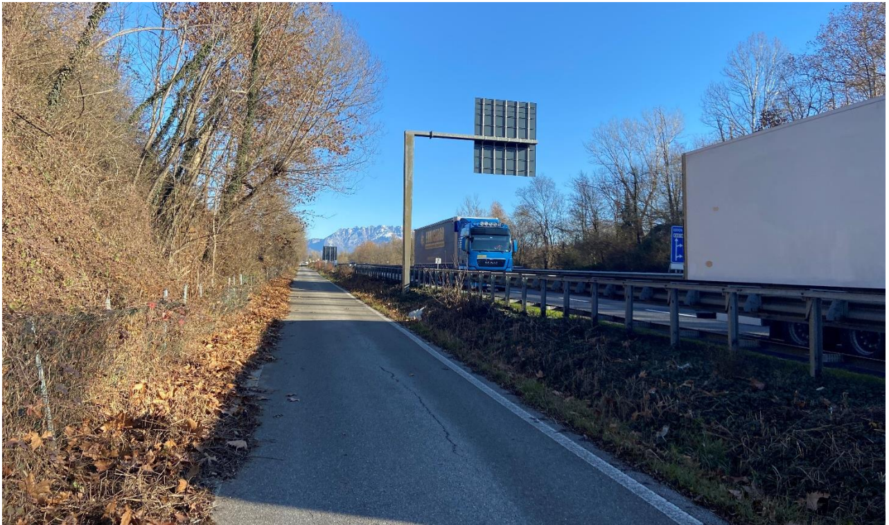
Figura 75: Vista da sud-ovest - Piazzole di sosta PS2 (vista 1).
