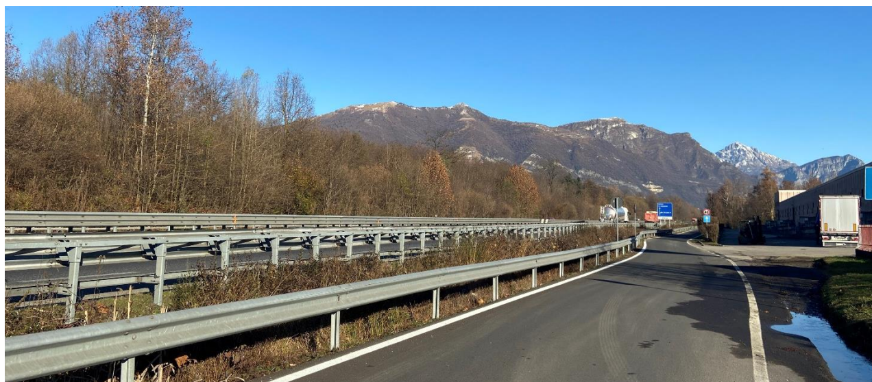
Figura 110: Vista della SS36 dir. nord km 38+6 (vista 14).
