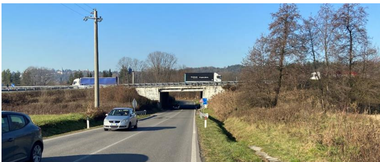
Figura 64: Vista da sud-est - Ponte Veduggio (vista 8).
