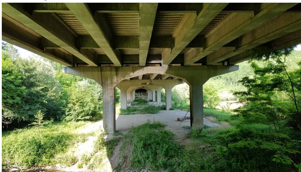
Figura 41: Vista da sud-ovest della corsia di decelerazione D1 (vista 9).
