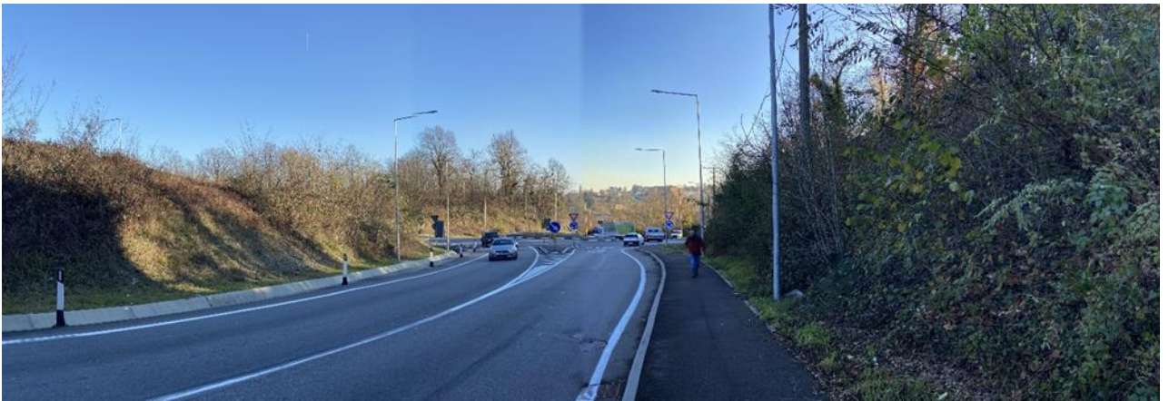
Figura 23: Vista da nord-ovest della curva Briosco oggetto di adeguamento (vista 6).
