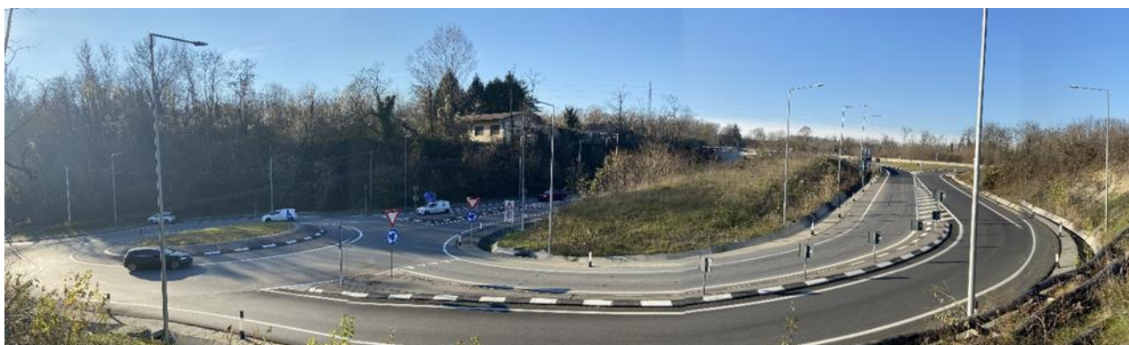
Figura 20: Vista da est della curva Briosco oggetto di adeguamento (vista 3).
