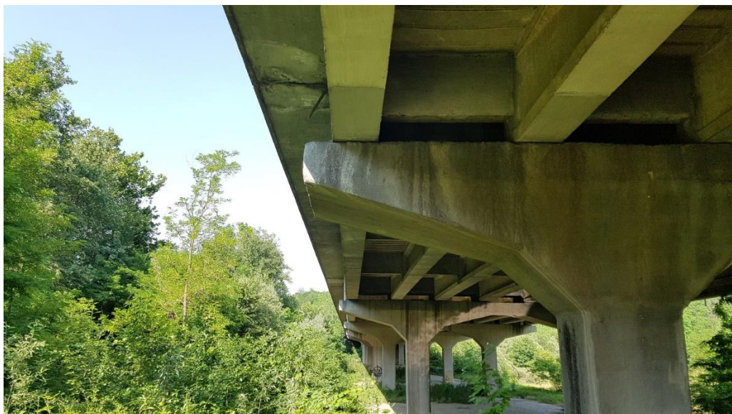
Figura 40: Vista da sud-ovest della corsia di decelerazione D1 (vista 8).
