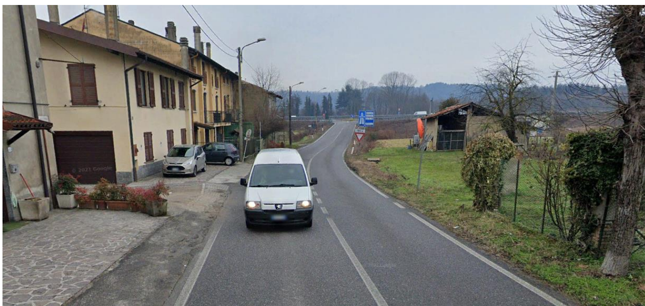
Figura 65: Vista da sud-est - Svincolo Veduggio - attuale rampa uscita carreggiata nord (vista 9).
