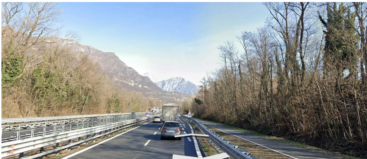
Figura 112: Vista lungo la SS36 dir. nord km 41+2 (vista 16). Fonte: Google maps.
