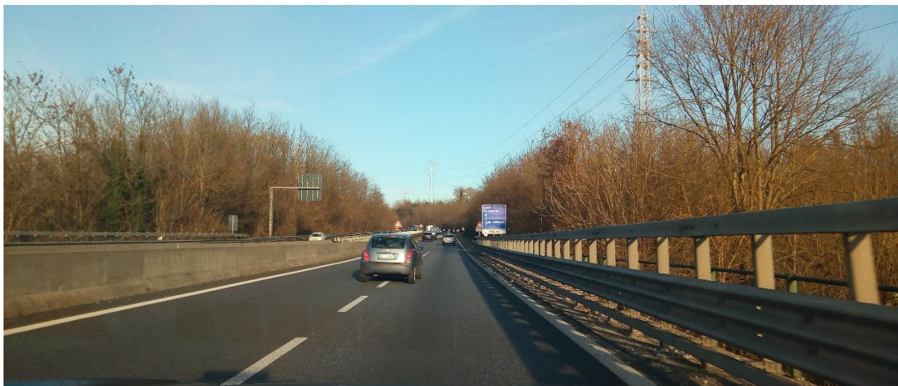
Figura 97: Vista lungo la SS36 dir. nord km 29+5 (vista 1).
