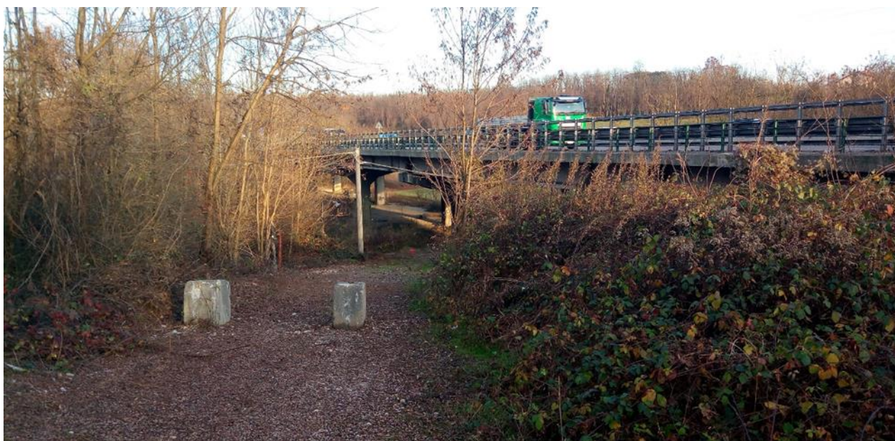
Figura 34: Vista da ovest della corsia di decelerazione D1 (vista 2).
