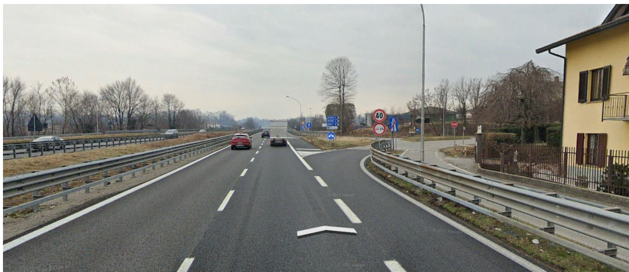
Figura 109: Vista lungo la SS36 dir. sud km 37+9 (vista 13). Fonte: Google maps.
