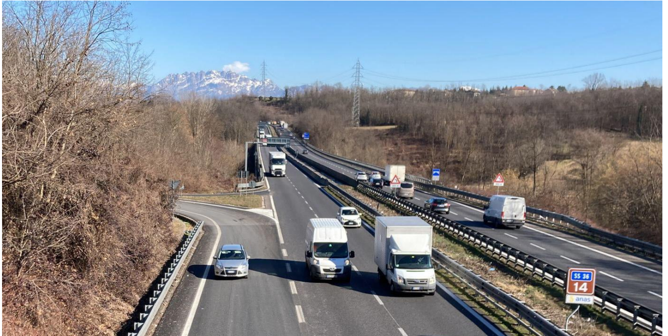
Figura 13: Vista dal sovrappasso sulla SP102 verso l'intervento sul viadotto Bevera - STATO ATTUALE
