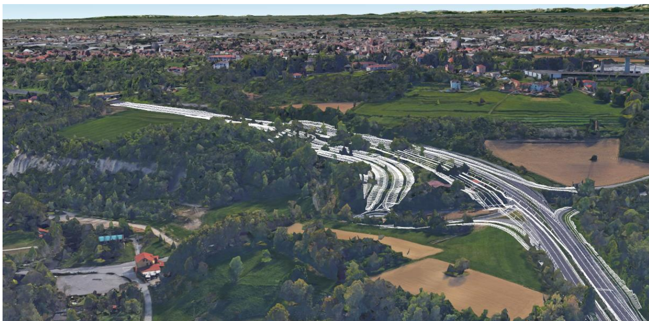
Figura 4: Vista a volo d'uccello con sovrapposizione del progetto da nord (Fonte: Google Earth) – Curva Briosco.
