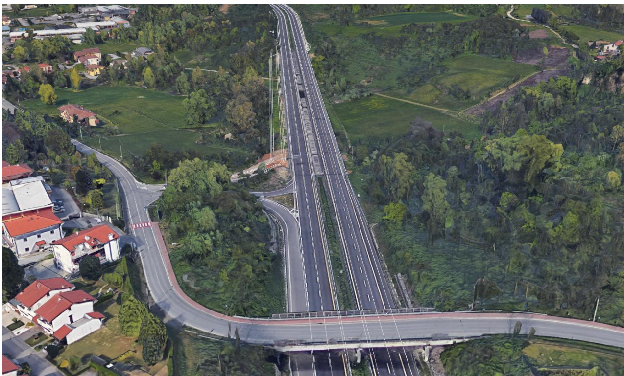
Figura 11: Vista a volo d’uccello da sud-est (Fonte: Google Earth) – Corsia di decelerazione D1.
