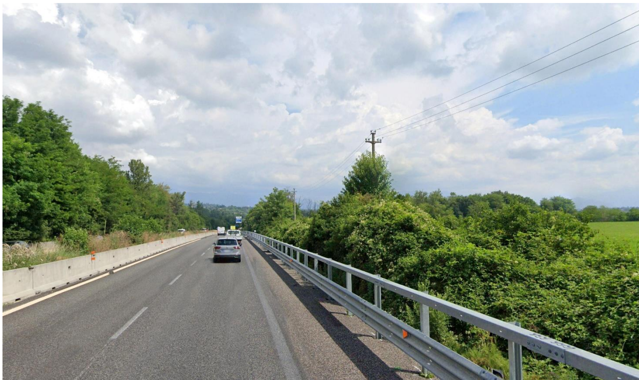
Figura 9: Vista dalla SS36, da sud-est verso il nuovo ramo della Curva Briosco – STATO ATTUALE
