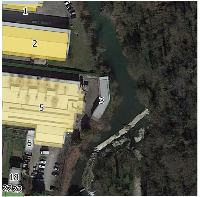
Identificazione del ricettore n. 3 ed eventuale foto a descrizione dello stesso (sotto).
