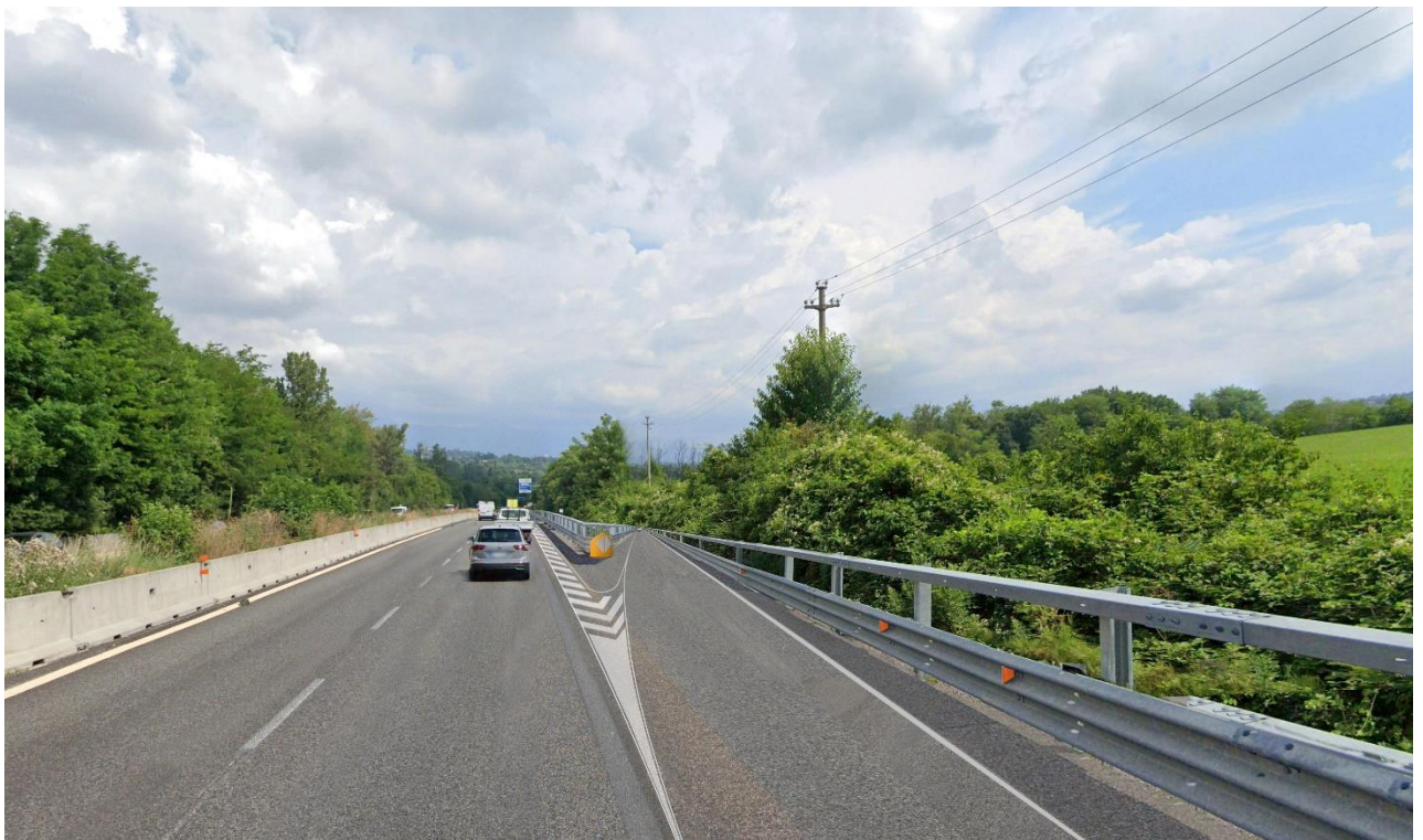
Figura 10: Vista dalla SS36, da sud-est verso il nuovo ramo della Curva Briosco – FOTOSIMULAZIONE
