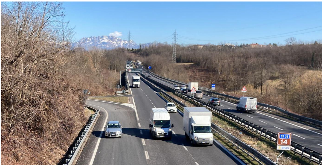
Figura 13: Vista dal sovrappasso sulla SP102 verso l'intervento sul viadotto Bevera - STATO ATTUALE
