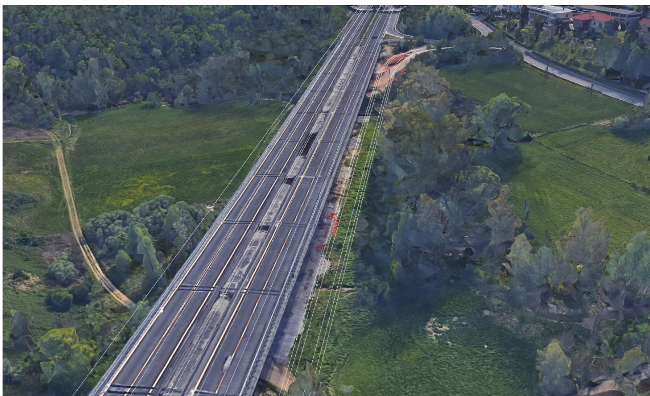
Figura 12: Vista a volo d'uccello da sud-est (Fonte: Google Earth) – Corsia di decelerazione D1.
