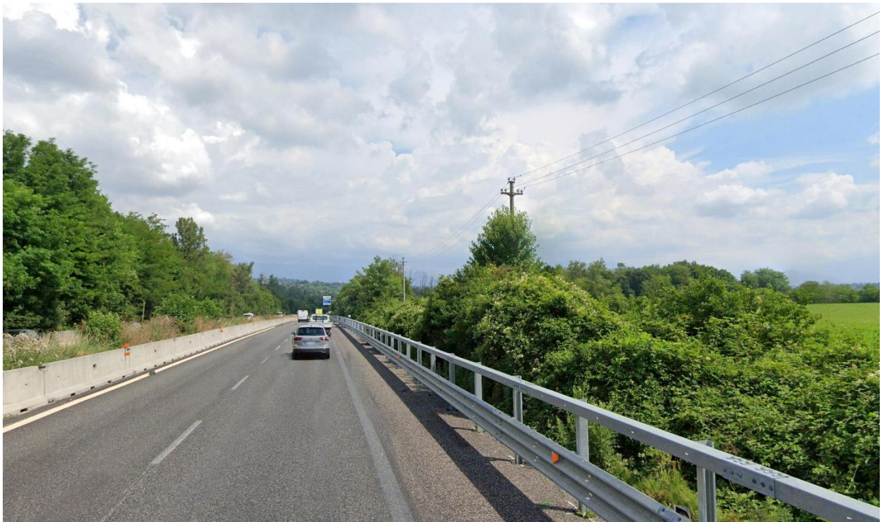
Figura 9: Vista dalla SS36, da sud-est verso il nuovo ramo della Curva Briosco – STATO ATTUALE
