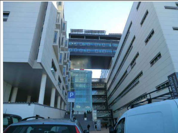
Vista da Nord
