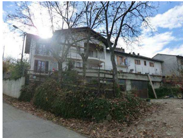
Vista da Nord
