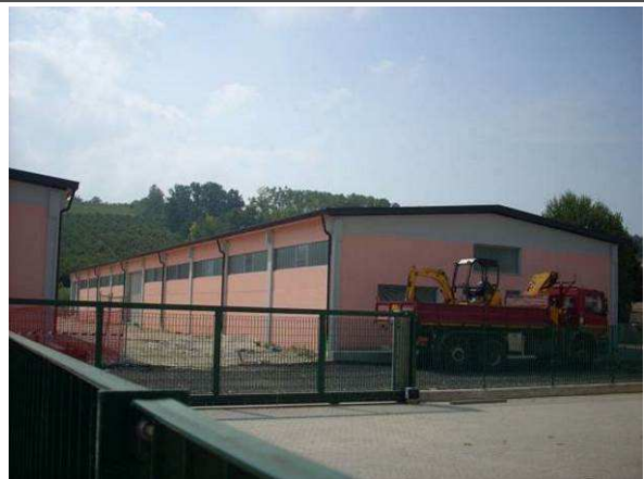
Vista da Nord
