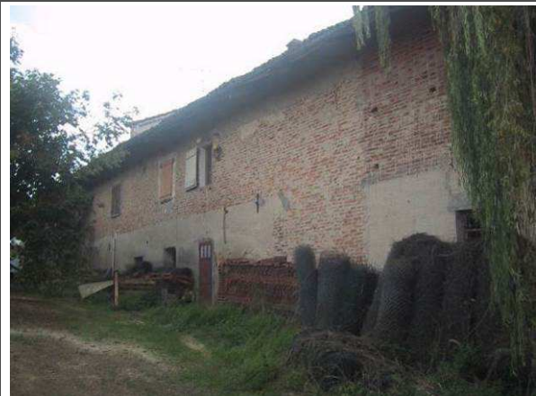
Vista da Nord
