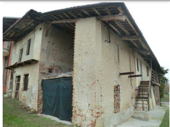
Vista da Ovest
