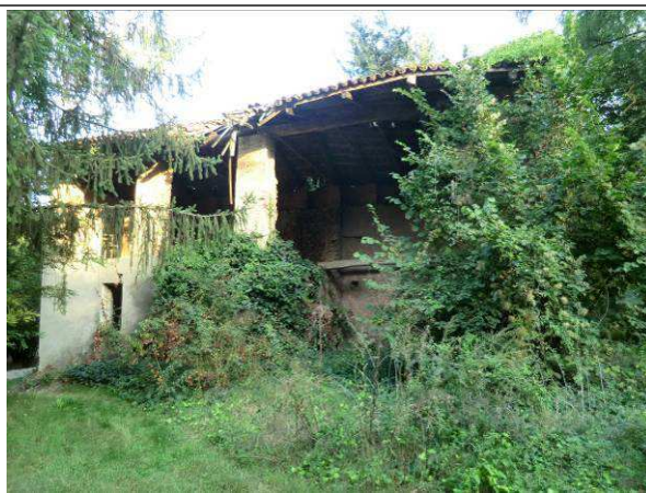
Vista da Nord
