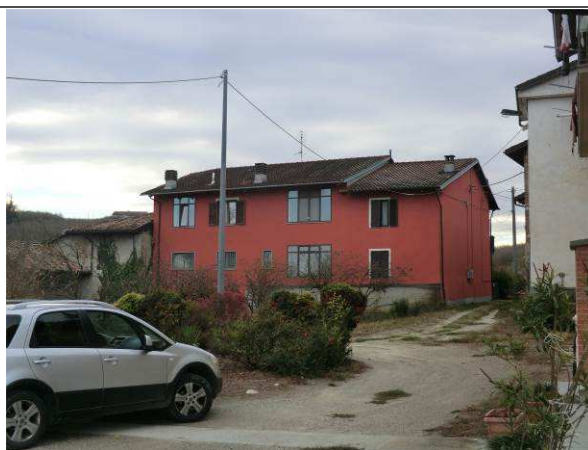
Vista da Nord
