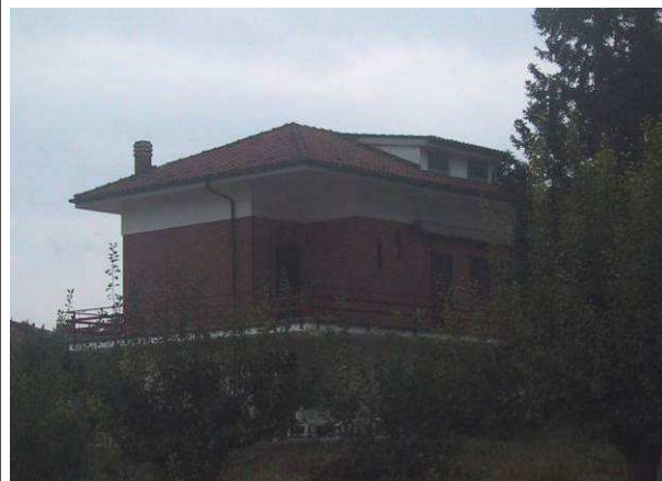
Vista da Ovest
