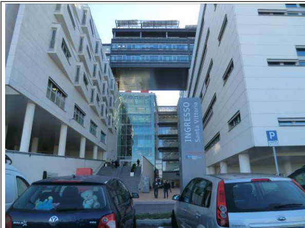
Vista da Nord
