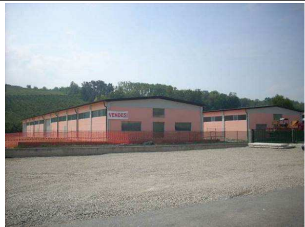
Vista da Nord
