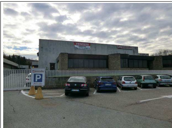
Vista da Nord
