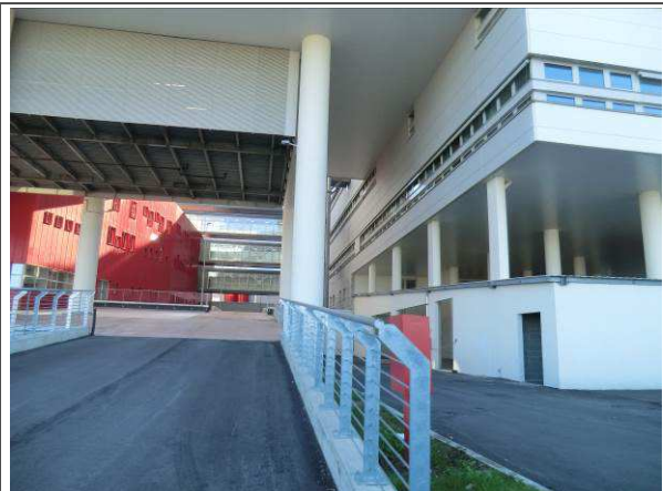
Vista da Nord
