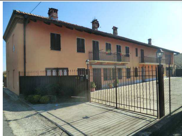
Vista da Ovest
