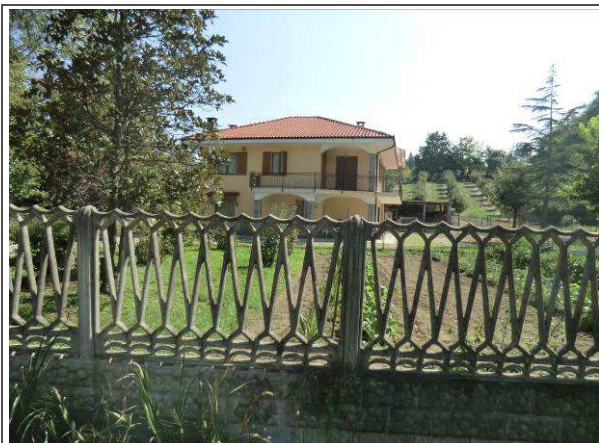
Vista da Nord
