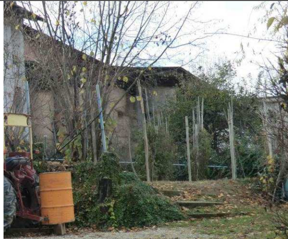
Vista da Nord
