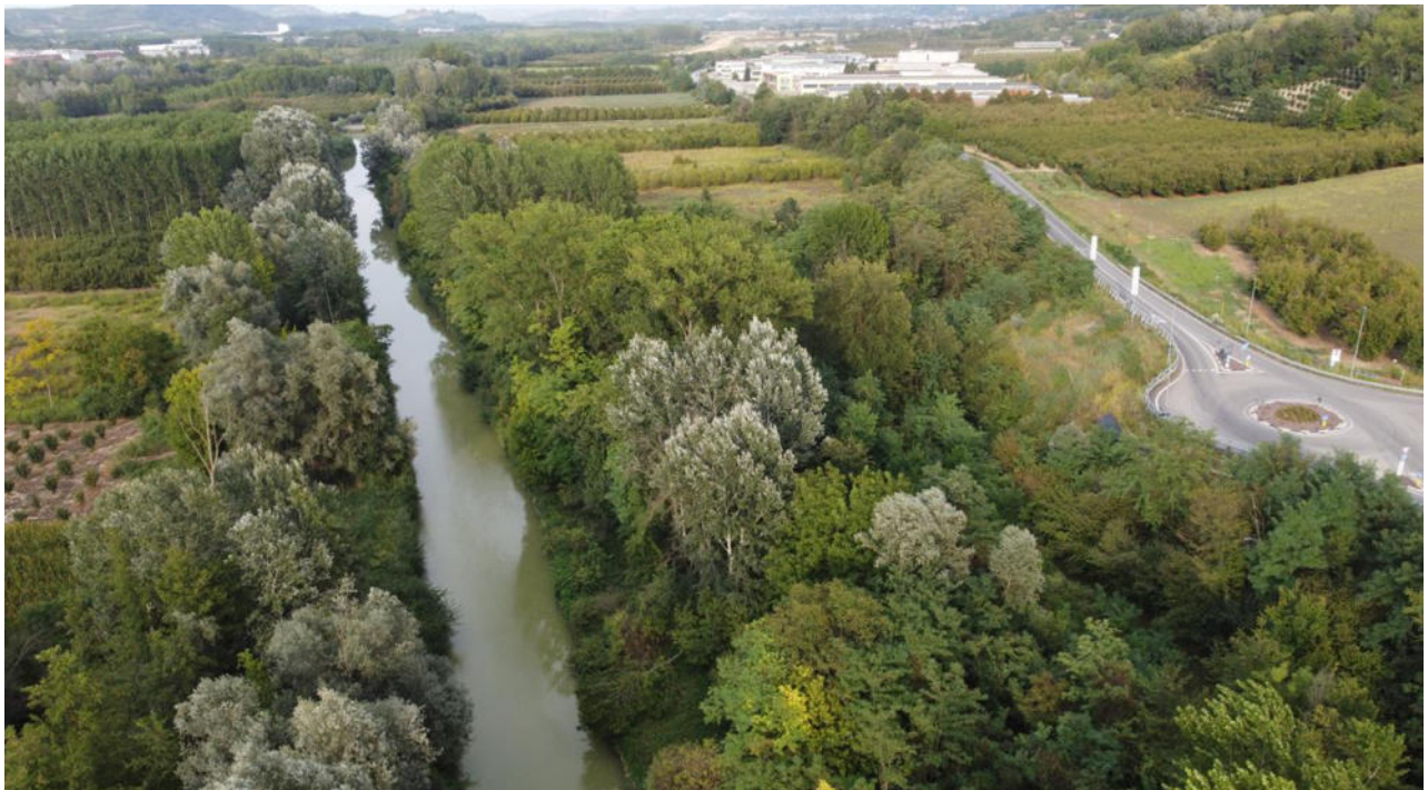
Figura 5.3 vista aerea sul canale di Verduno verso est. Si osserva la presenza di un soprassuolo dominato da pioppi neri e pioppi bianchi di dimensioni rilevanti, a cui si accompagna il salice bianco. Questo tratto del canale sarà oggetto di deviazione per il passaggio del nuovo tratto autostradale.
