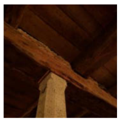
Travi di sostegno in legno
