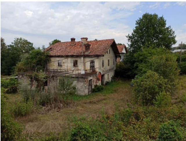
Visuale n.6 – vista degli esterni del mulino
