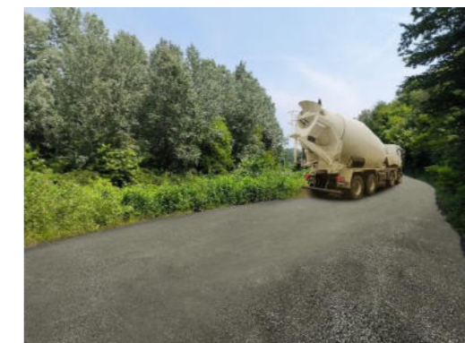
Figura 2-6 – tratto 1 della viabilità a servizio del cantiere
