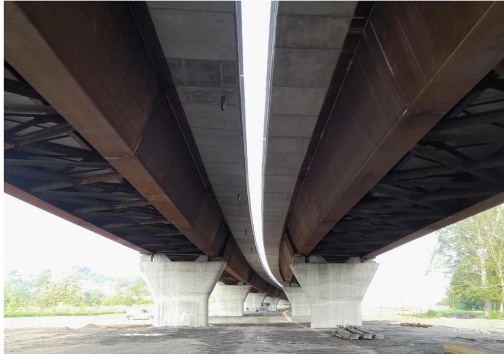
FIGURA 2-3 PARTICOLARE INTRADOSSO IMPALCATO E LASTRE PREDALLES PREFABBRICATE
