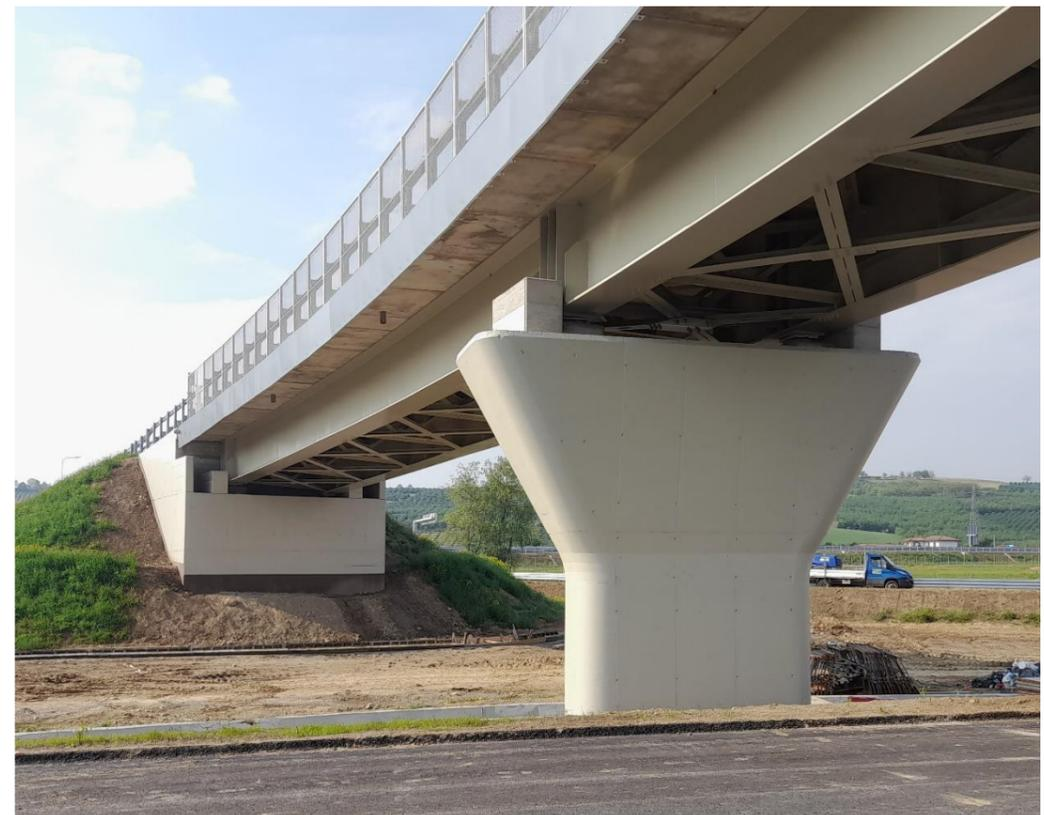
**FIGURA 2-12 RAMPA DI USCITA ASTI-ALBA OVEST – VISTA DELLA CAMPATA TERMINALE DI COLLEGAMENTO PILA-SPALLA. SI NOTI L'AMMORSAMENTO PARZIALE DELLA SPALLA NEL CORPO DEL RILEVATO DI APPROCCIO**
