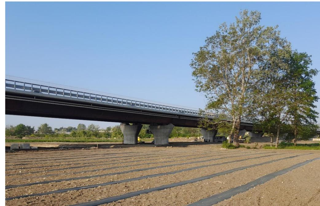
FIGURA 2-2 PARTICOLARE RAPPORTO TRA LUCE DI CAMPATA E ALTEZZA PILA E IMPALCATO
