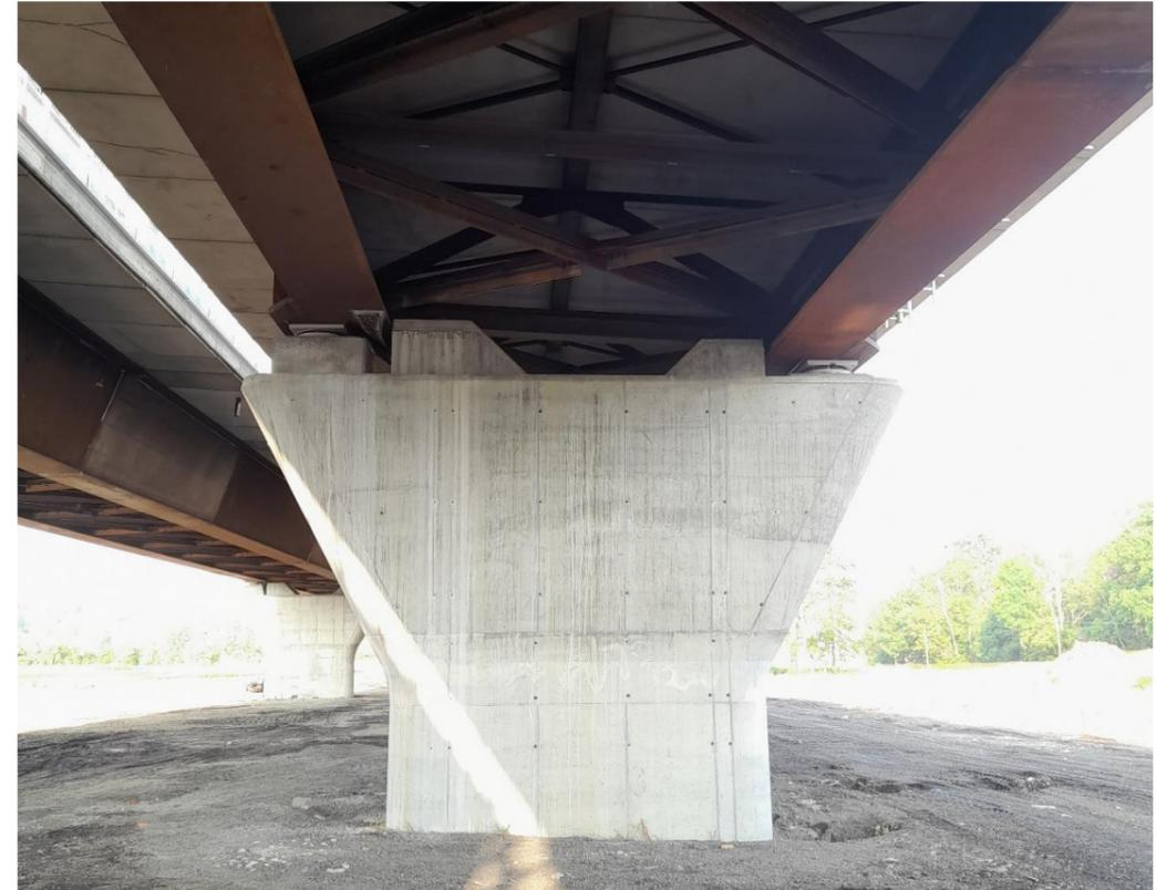
FIGURA 2-5 PARTICOLARE IMPALCATO A TRAVI INCLINATE E CONFORMAZIONE DELLA PILA (VISTA FRONTALE),
