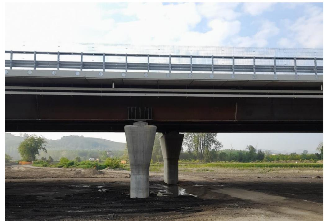
FIGURA 2-6 VISTA LATERALE DELLA CONFORMAZIONE DELLE PILE E DELL'IMPALCATO COMPRESSIVO
