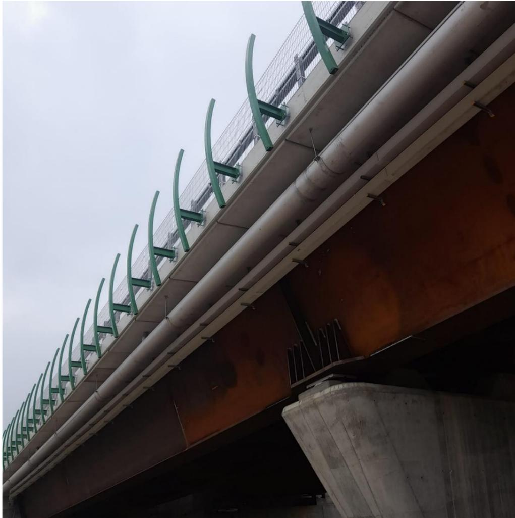
**FIGURA 2-24 VIADOTTO IN ASSE AUTOSTRADALE: PARTICOLARE DEL COLLETTORE DELLE ACQUE METEORICHE. SI NOTINO LE STAFFE DI SUPPORTO PER IL CARTER LATERALE, POSIZIONATO A PARZIALE MASCHERAMENTO DEL SISTEMA.**
