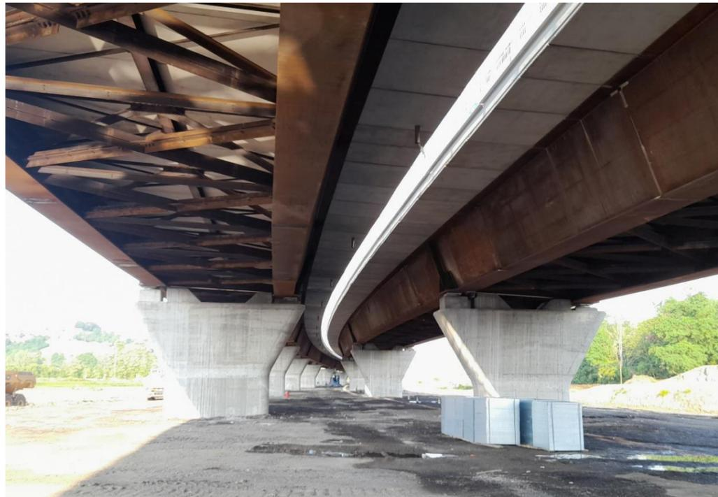
FIGURA 2-4 PARTICOLARE INTRADOSSO IMPALCATO E LASTRE PREDALLES PREFABBRICATE
