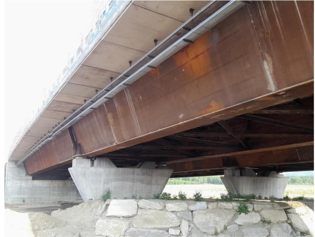
**FIGURA 2-22 SISTEMA DI APPENSIONE DEI CAVIDOTTI ALL'INTRADOSSO DELLA SOLETTA. SI NOTI LA PREDISPOSIZIONE DELL'AGGANCIO DELLE VELETTE, IN CORSO DI INSTALLAZIONE**
