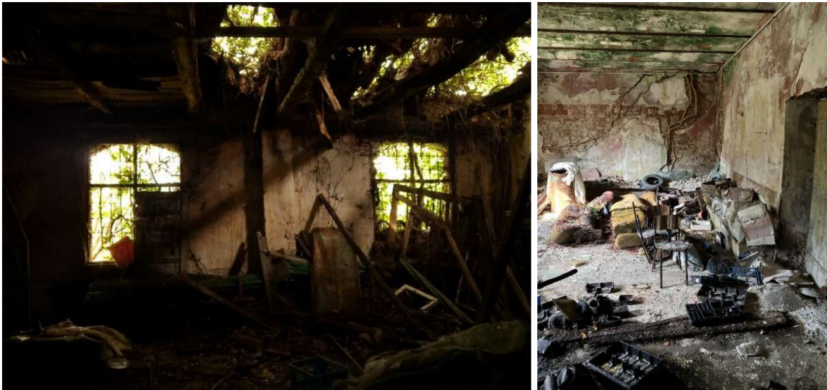
Figura 15. Stato di conservazione - interno
