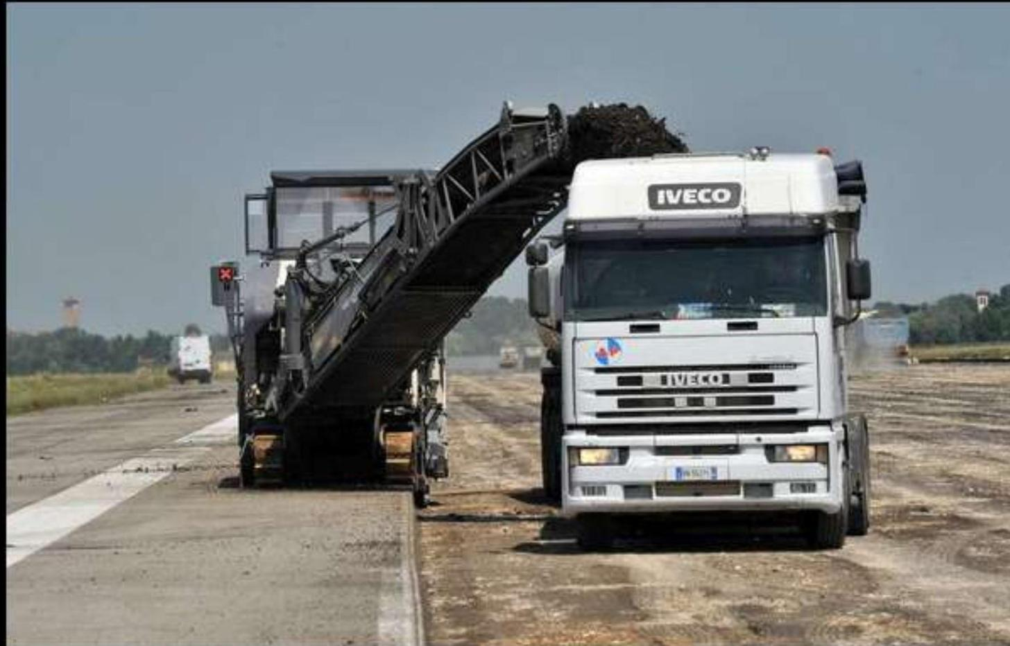
Le ingenti quantità di materiale (circa 130.000 metri cubi), necessarie per la ricostruzione della pista, hanno portato a prevedere il riciclaggio in situ di tutti i materiali provenienti dalla demolizione della struttura esistente.
