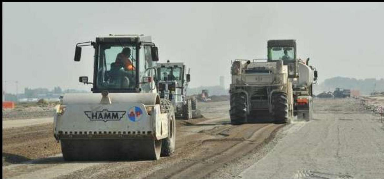
Su questo strato di fondazione ne è stato quindi steso un altro in misto cementato, con cemento al 2,5%, realizzato per 20 centimetri.
