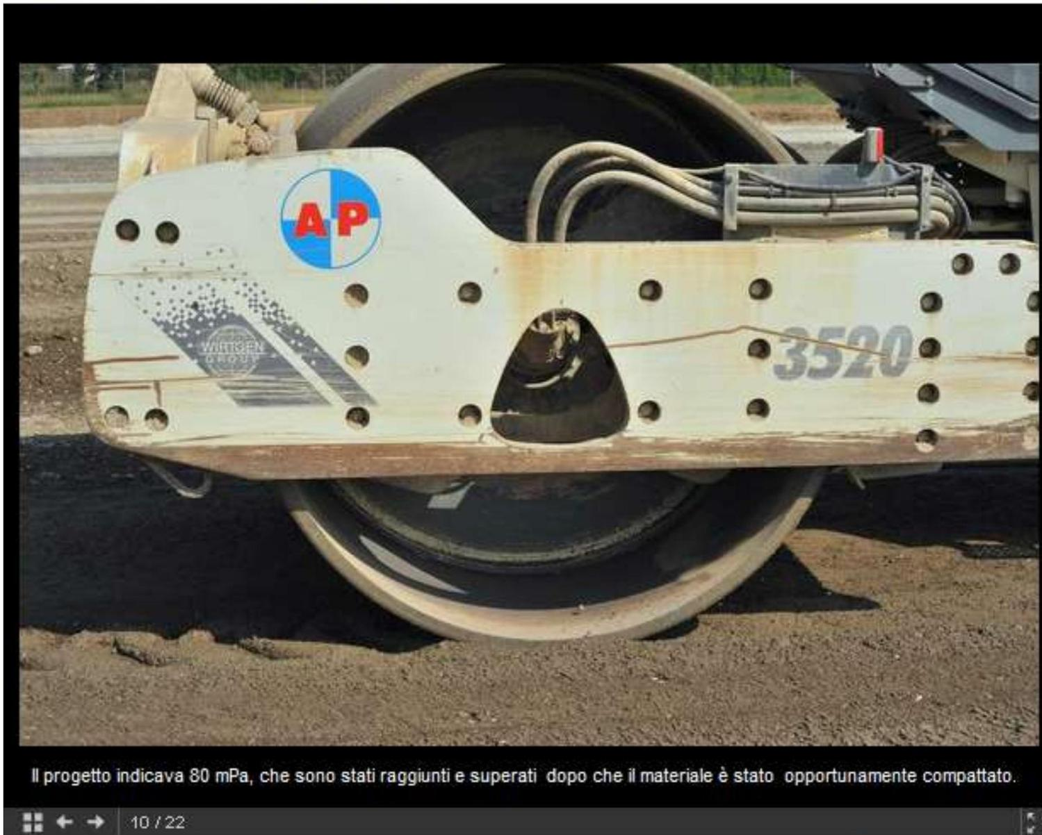
Il progetto indicava 80 mPa, che sono stati raggiunti e superati dopo che il materiale è stato opportunamente compattato.
