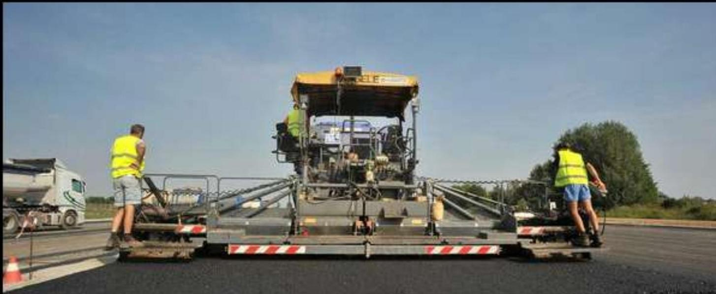
il binder di 5 centimetri e il tappeto di usura di 4 centimetri sono stati realizzati utilizzando bitume modificato.
