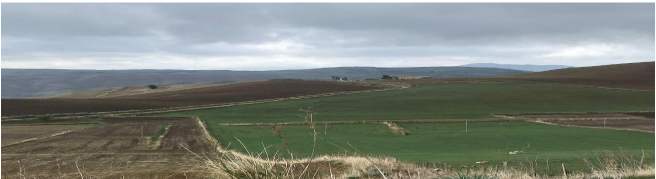
Figura 3 -Facies argillosa della Fm. di Pasquasia. Foto scattata che inquadra l'aerogeneratore WTG06
