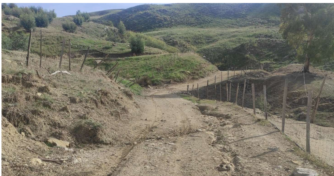
Figura 104 – Punto di passaggio del cavidotto in TOC
