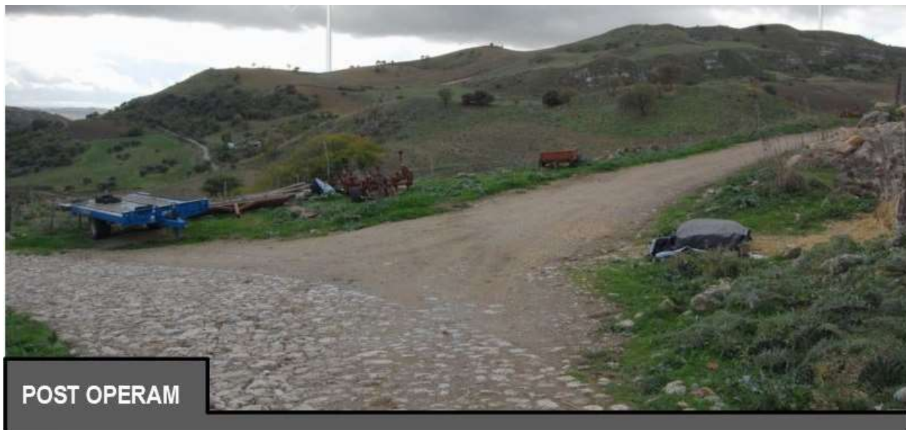
Figura 93 – F22 - POST OPERAM – ANALISI DELL'INTERVISIBILITÀ
