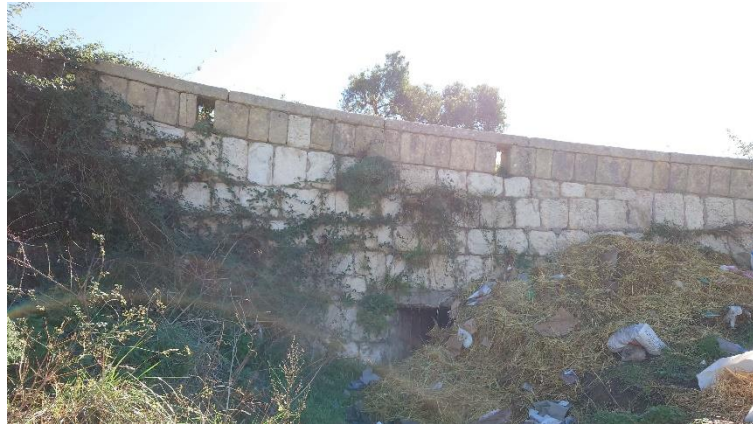
Figura 21 - Rilievo della I04 effettuato in situ
