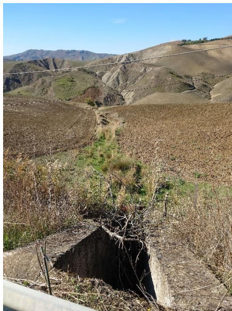
Figura 27 - Rilievo in situ della I08 con evidenza dell'opera di canalizzazione a valle
