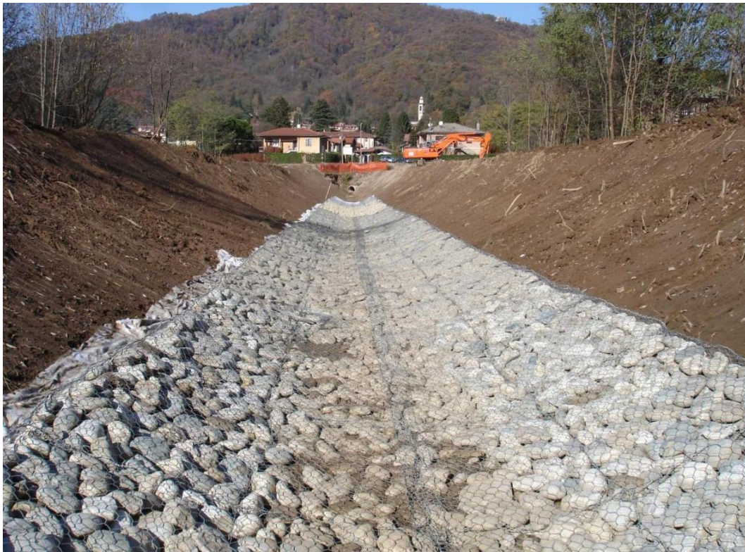
Figura 75 - Esempio di immagine che rappresenta i materassi Reno
