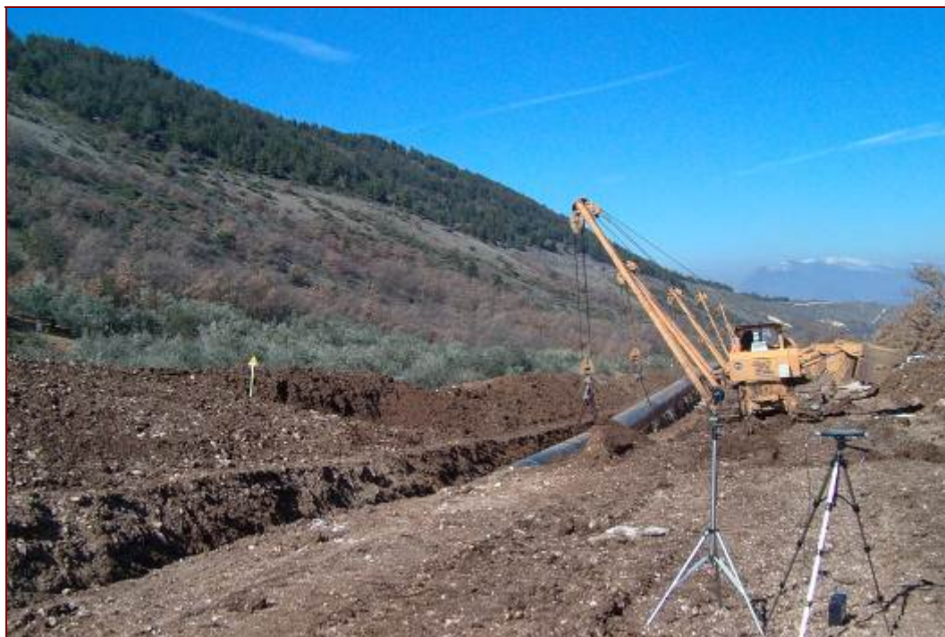
Fig. 5.1/A: Rilievi acustici durante l'operazione di posa di una condotta
