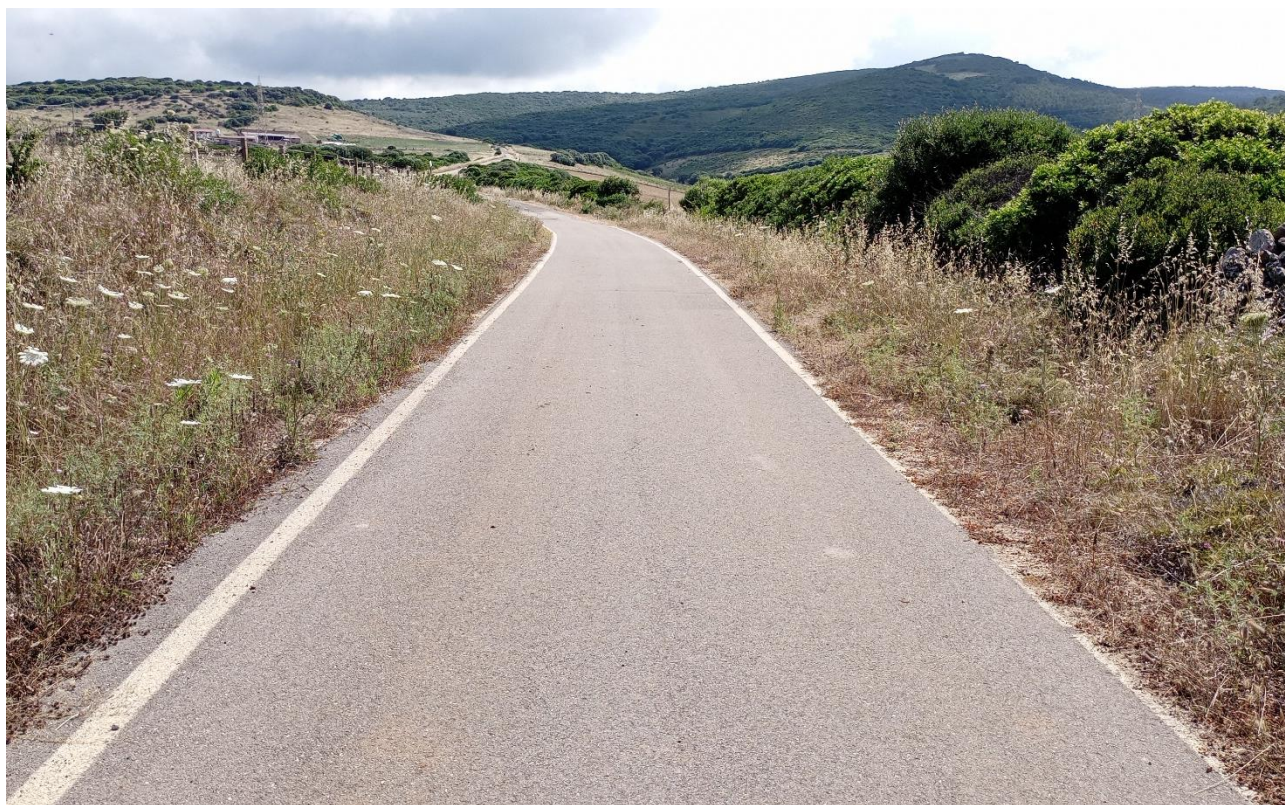
Figura 5.12 – Strada rurale bitumata di accesso alle postazioni eoliche del Cluster nord-ovest (direzione nord-ovest)
