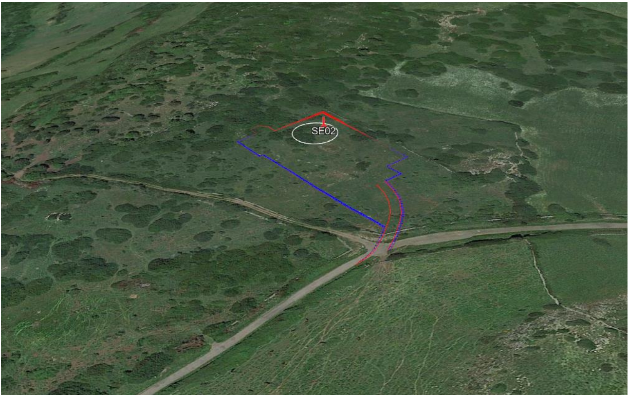
Figura 5.23 – Tracciato di nuova costruzione di collegamento alla postazione eolica SE02 (vista verso nord-ovest)
