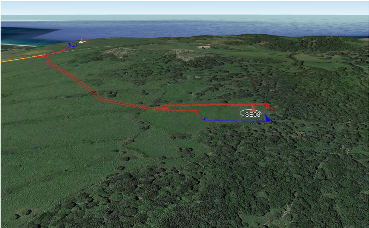
Figura 5.29 - Tracciato su nuova viabilità di collegamento alla postazione eolica SE08 (vista verso ovest)
