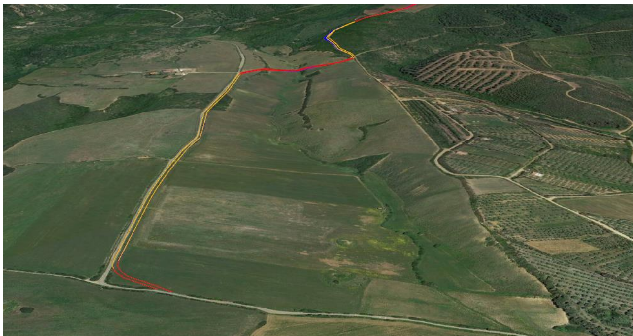
Figura 5.11 – Asse di accesso al raggruppamento delle postazioni eoliche del Cluster nord-ovest (vista verso nord-ovest)
