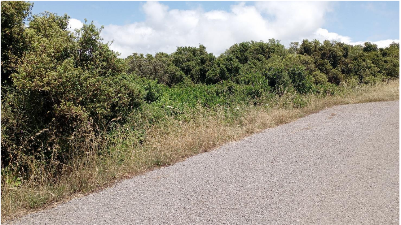
Figura 5.21 – Viabilità rurale esistente, lungo la quale si innesta la viabilità di accesso alla postazione SE05 (direzione nord-ovest)
