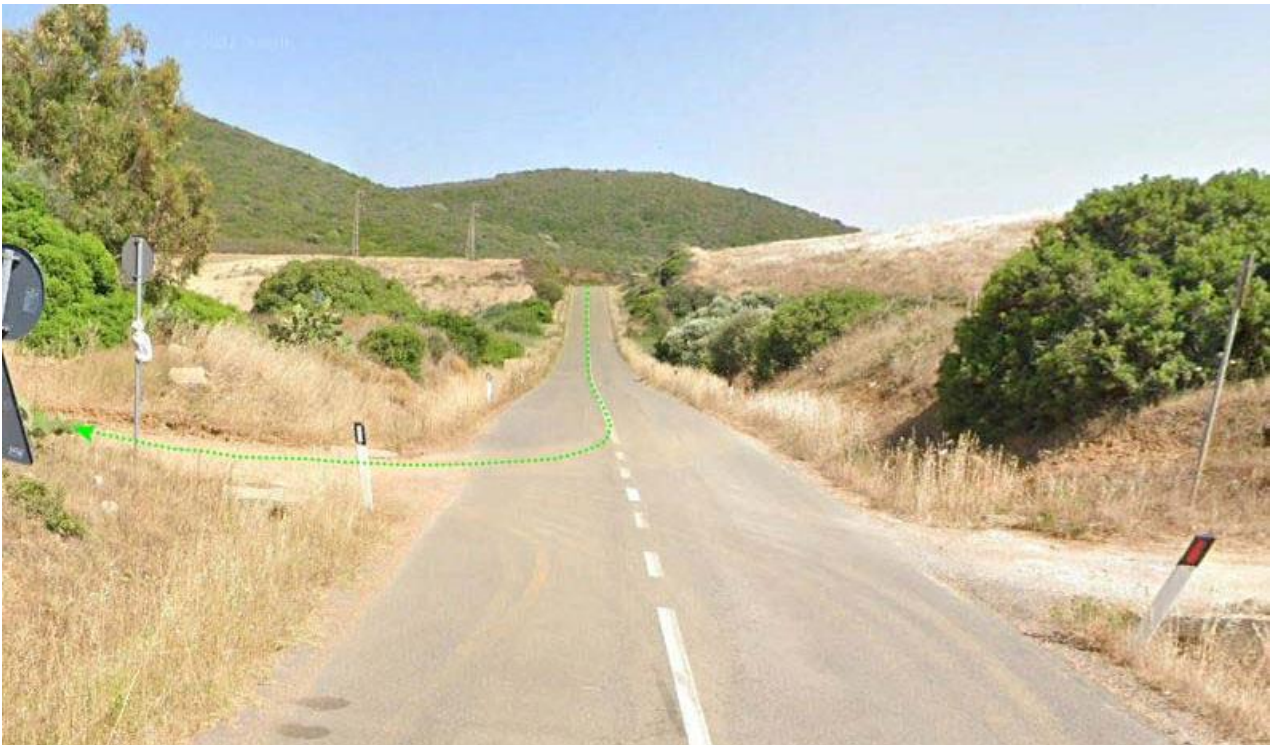
Figura 5.4 Accesso al Cluster Sud dalla strada di collegamento S.S.292 e S.P. 11 in località Sa Prunischedda (direzione sud-est)
