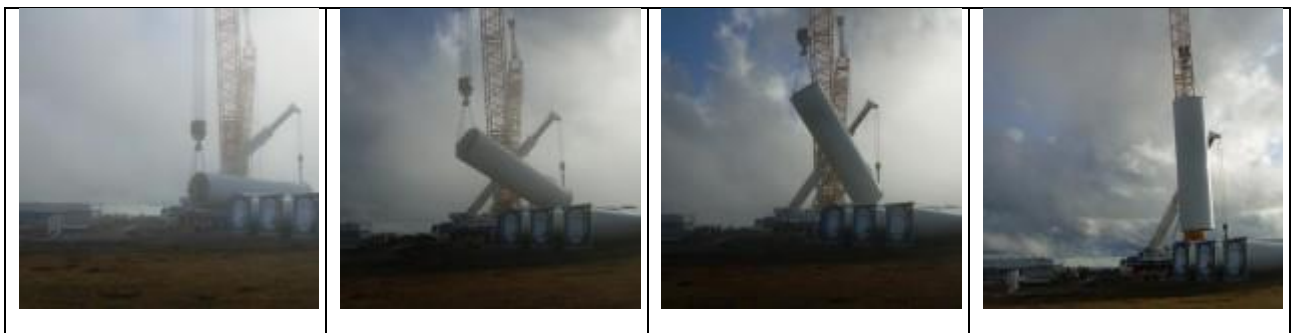
Figura 5.40 – Schema delle fasi di sollevamento dei componenti dell'aerogeneratore (Fonte sito web http://www.windfarmbop.com/ )
