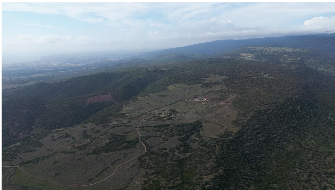
Figura 2.5 – Assetto geomorfologico dell'area di intervento.
