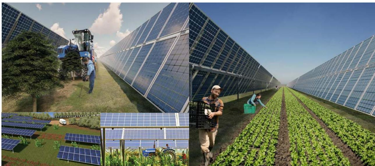
Figura – Coltivazioni sotto i moduli e negli spazi interfilari
