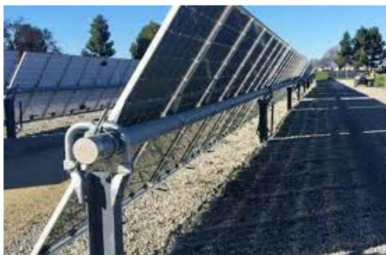
Figura 3.3 Esempio di struttura tracker monoassiale
