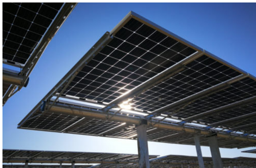
Figura 2.2: Esempio di struttura a tracker monoassiale.
