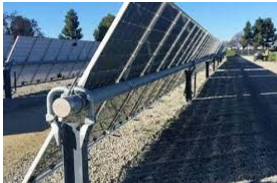
Figura 2.2 Esempio di struttura tracker monoassiale
