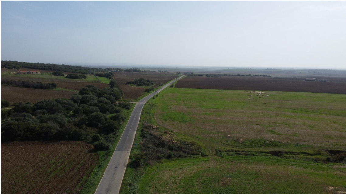
Figura 3.4. Strada della Campigliola a nord dell'area d'intervento
