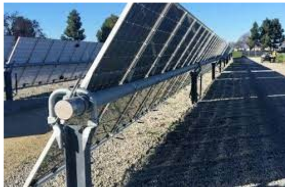
Figura 4.2 Esempio di struttura tracker monoassiale
