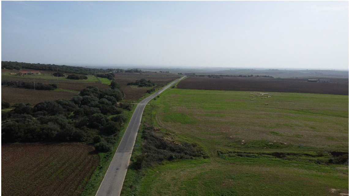
Figura 7-46: Strada della Campigliola a nord dell'area d'intervento
