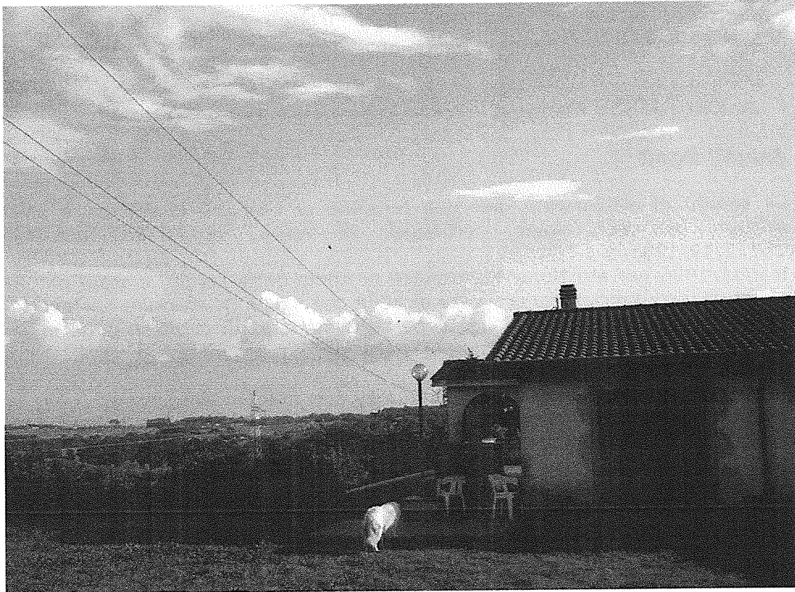
Immagine 5 - Elettrodotto 2. Flaminia – Monte Mario vista da Nord sopra abitazione e verso villaggio turistico.
