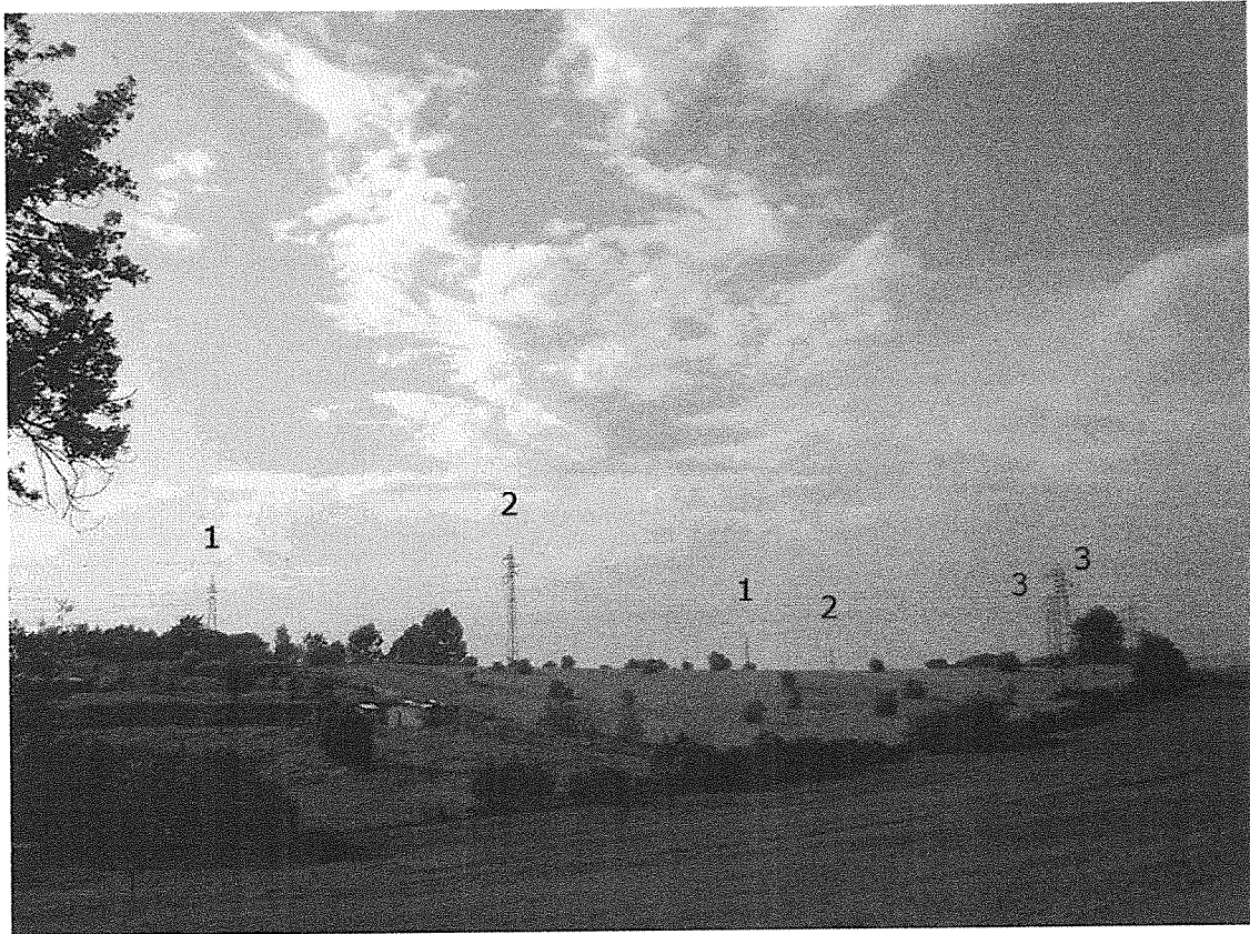
Immagine 6 – Vista degli elettrodotti da Sud – Est.
