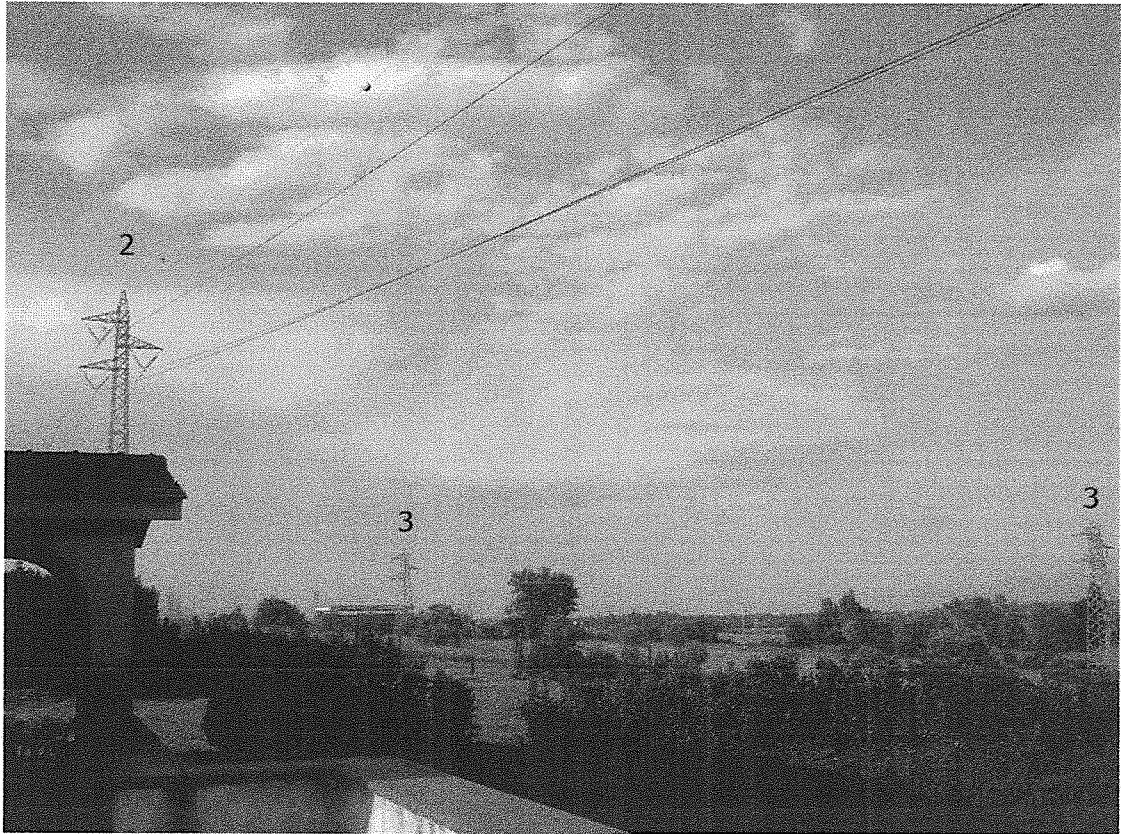
Immagine 4 - Elettrodotto 2. Flaminia – Monte Mario vista da Sud sopra abitazione. In basso tralicci elettrodotto 3. Flaminia – Forte Antenne.
