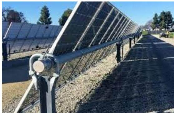
Figura 2.2 Esempio di struttura tracker monoassiale
