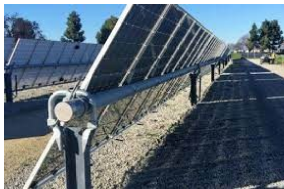
Figura 4.2 Esempio di struttura tracker monoassiale
