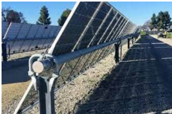
Figura 3.2 Esempio di struttura tracker monoassiale
