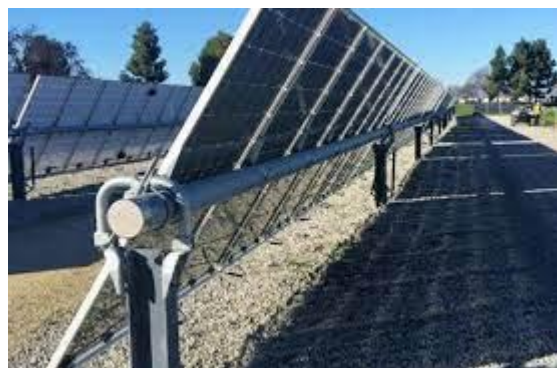
Figura 2.2 Esempio di struttura tracker monoassiale
