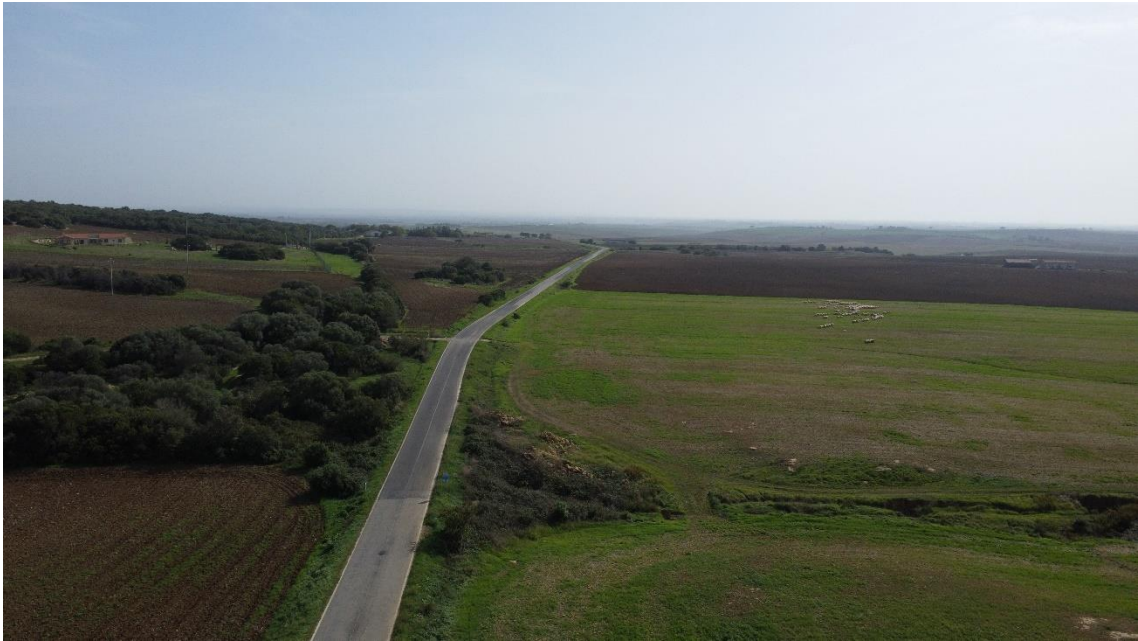
Figura 3.4. Strada della Campigliola a nord dell'area d'intervento
