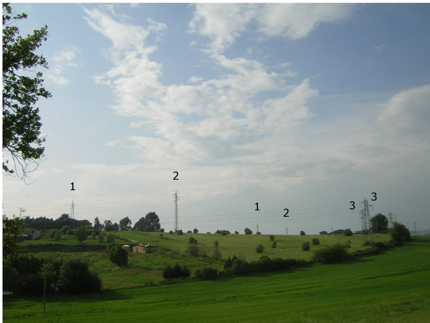
Immagine 6 - Vista degli elettrodotti da Sud - Est.
