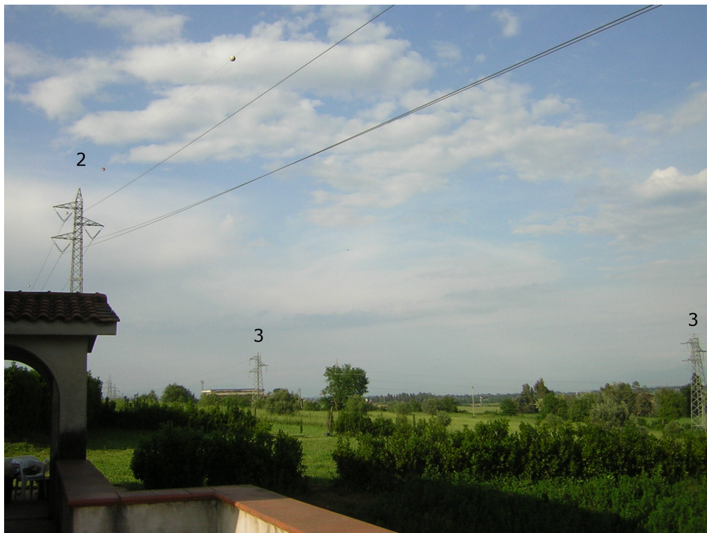
Immagine 4 - Elettrodotto 2. Flaminia - Monte Mario vista da Sud sopra abitazione. In basso tralicci elettrodotto 3. Flaminia - Forte Antenne.
