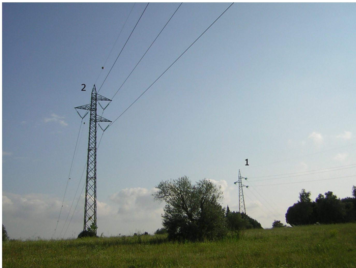
Immagine 3 – Elettrodotto 2. Flaminia – Monte Mario traliccio vista da Nord – Est. In secondo piano elettrodotto 1. Flaminia – La Storta.
