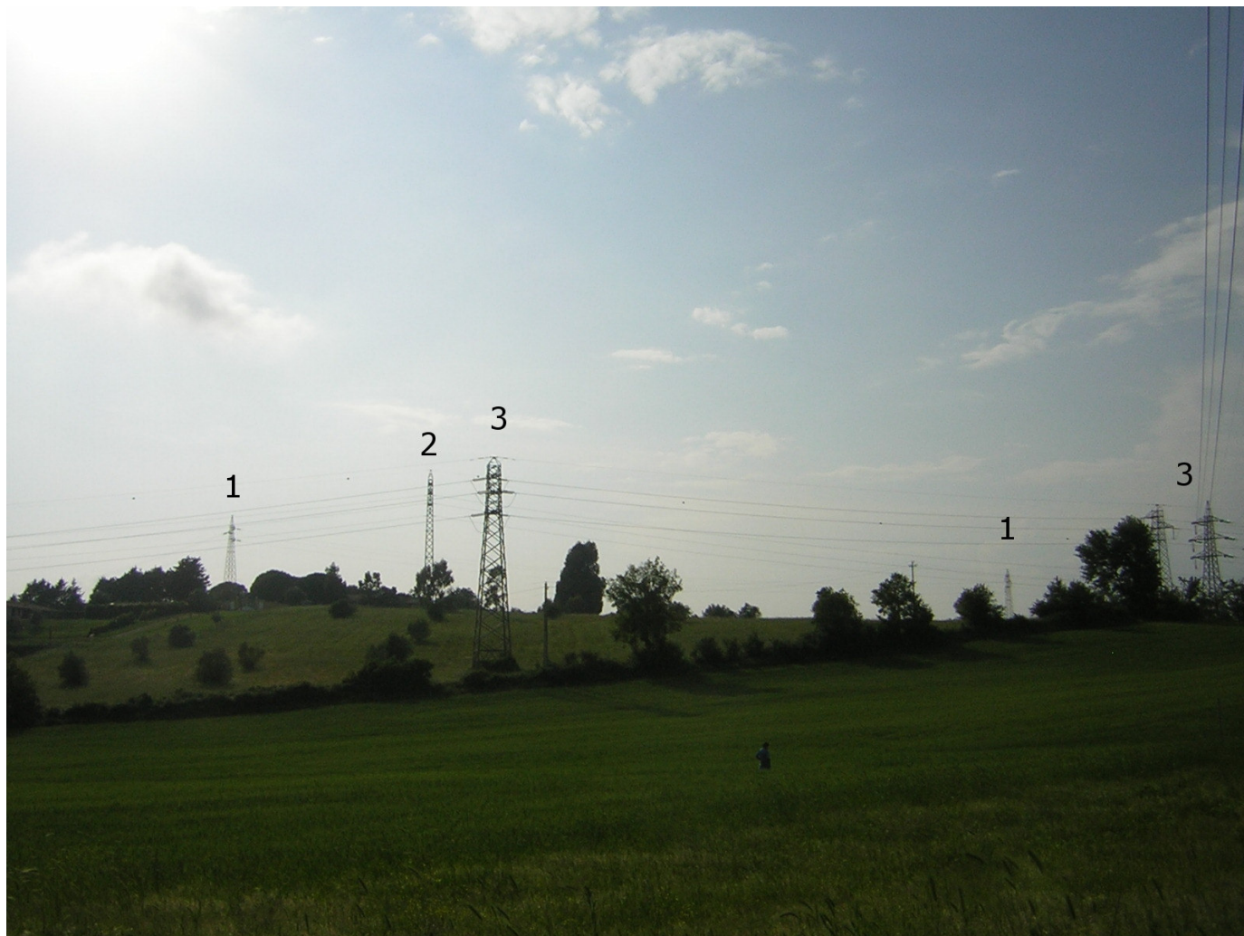
Immagine 7 – Vista degli elettrodotti da Est.
