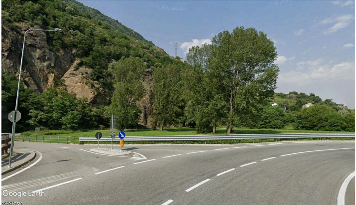
Figura 7-4 – Vista 2 dall’attuale svincolo per il centro commerciale di Castione Andevenno: l’area di cantiere è situata oltre il guard-rail nel settore di terreno agricolo dove sono presenti le visibili alberature. Oltre la linea di versante che chiude il bacino pianeggiante la massa boschiva che copre la scarpata rocciosa in direzione Sassella
