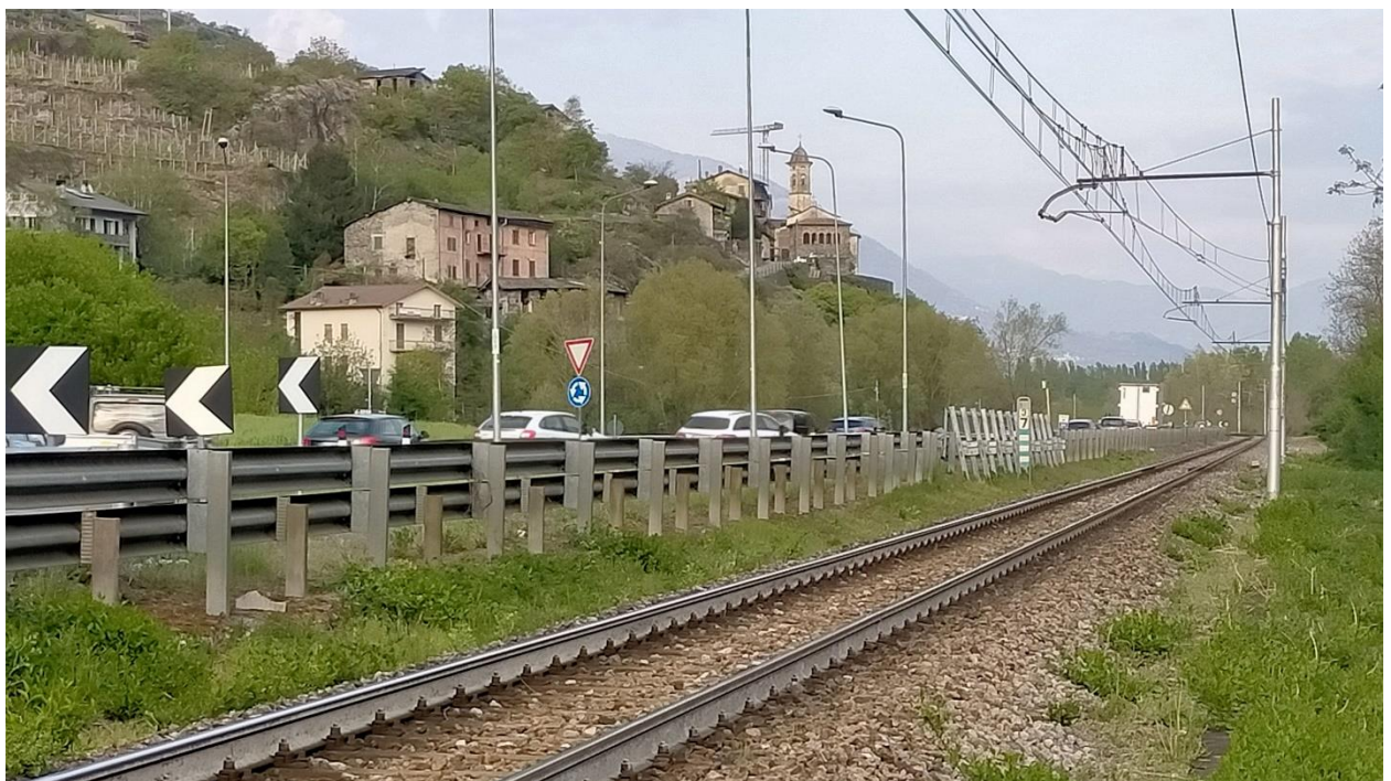
Figura 7-13 - Visuale 4 ante operam dell'attuale asse stradale della SS38 "dello Stelvio" nel Comune Sondrio lungo la linea ferroviaria Milano-Lecco-Tirano
