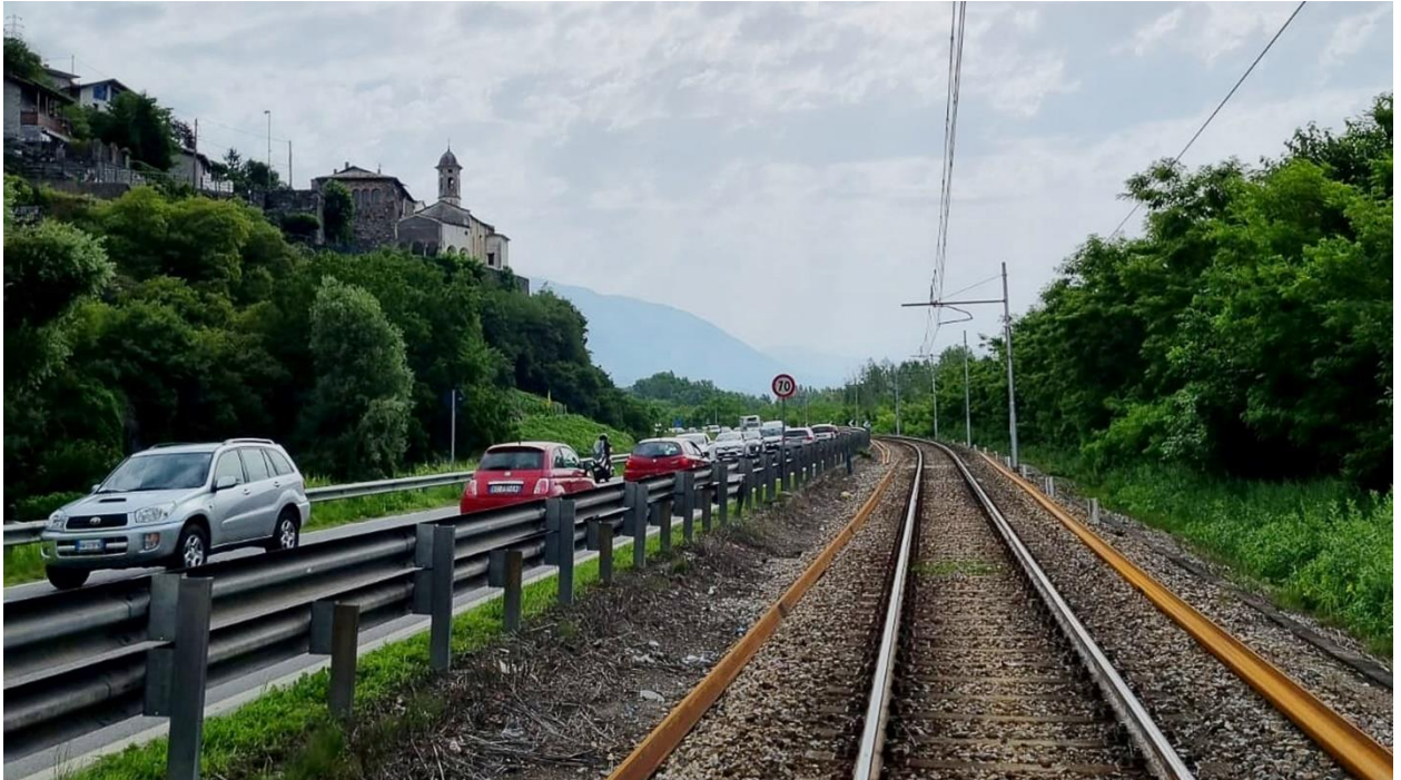
Figura 7-15 - Visuale 5 ante operam nel Comune Sondrio lungo la linea ferroviaria Milano-Lecco-Tirano
