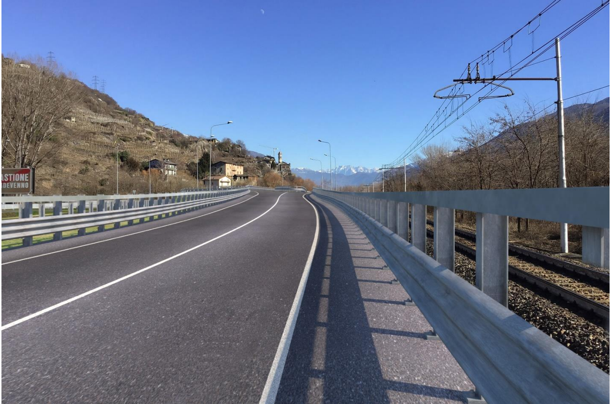
Figura 7-11 – Visuale 2 post operam dell'attuale asse stradale della SS38 "dello Stelvio" dal Comune di Castione Andevenno verso il Comune di Sondrio (zona commerciale) all'ingresso dell'attuale rotonda
