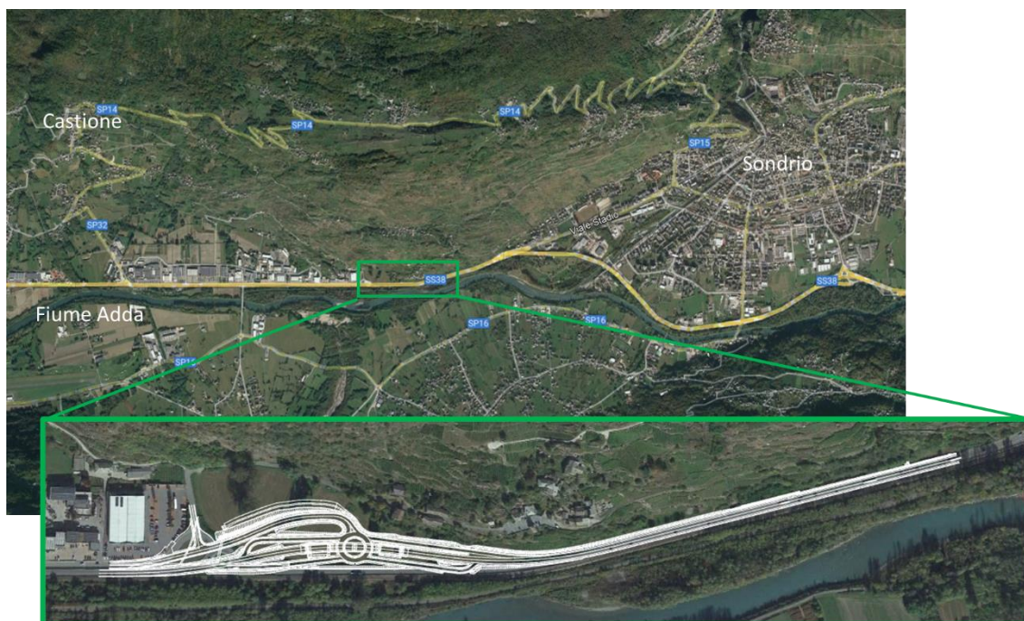
Figura 4-1 Contesto territoriale di inquadramento della SS38 relativo intervento di realizzazione del nuovo svincolo "Sassella" e riqualificazione dalla pk 34+150 alla pk 35+200 nei Comuni di Sondrio e Castione Andevenno.
