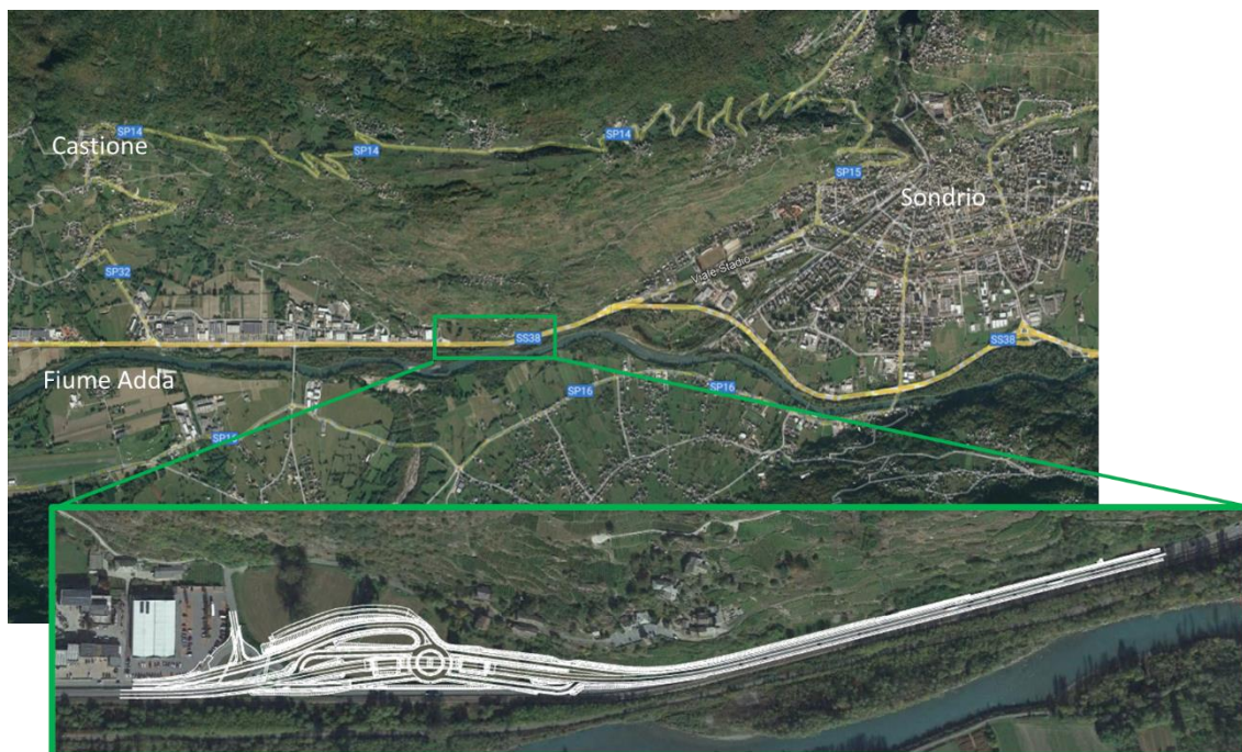
Figura 2-2 Inquadramento dello svincolo "Sassella" – SS38 Sondrio e Castione Andevenno nel contesto territoriale dei Comuni di Sondrio e di Castione Andevenno
