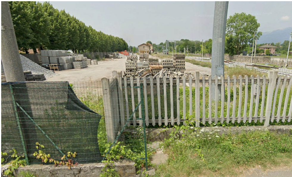
Foto 2 – vista dall'area di accesso al cantiere
