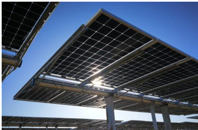
Figura 3.4 - Esempio di struttura a tracker monoassiale 2p
