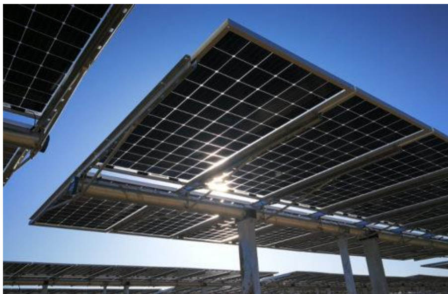
Figura 4.3 - Esempio di struttura con tracker monoassiale 2p
