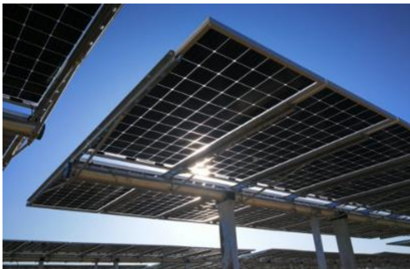
Figura 3.3: Esempio di struttura a tracker monoassiale
