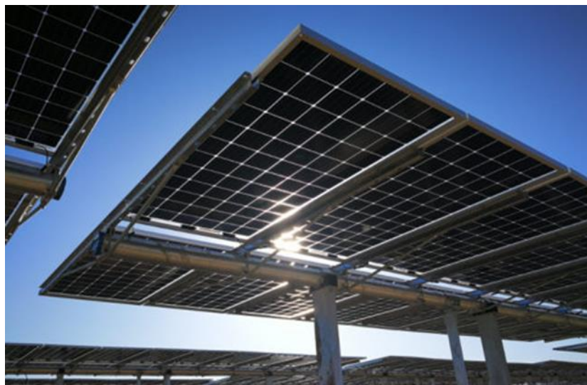
Figura 2.7: Esempio di struttura a tracker monoassiale 2p
