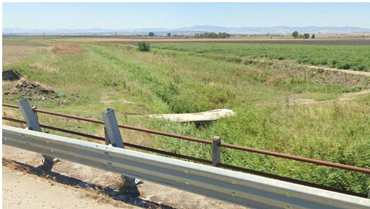
Figura 4.5: Il torrente Triolo in prossimità dell'area di intervento
