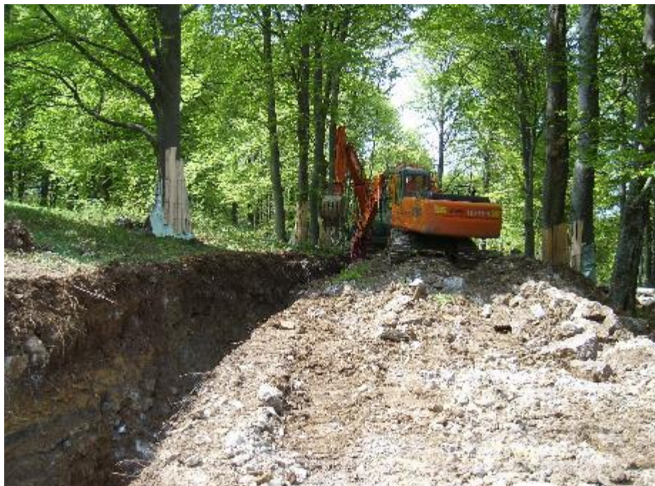
Figura 0-5 Foto tipica di scavo della trincea
