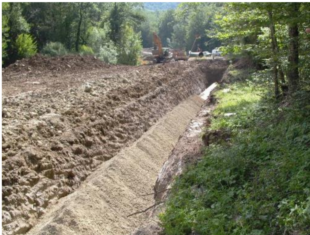
Figura 0-7 Rinterro della condotta
