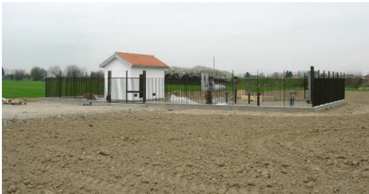
Figura 0-9 Esempio di Punto di intercettazione di linea (PIL) telecomandato
