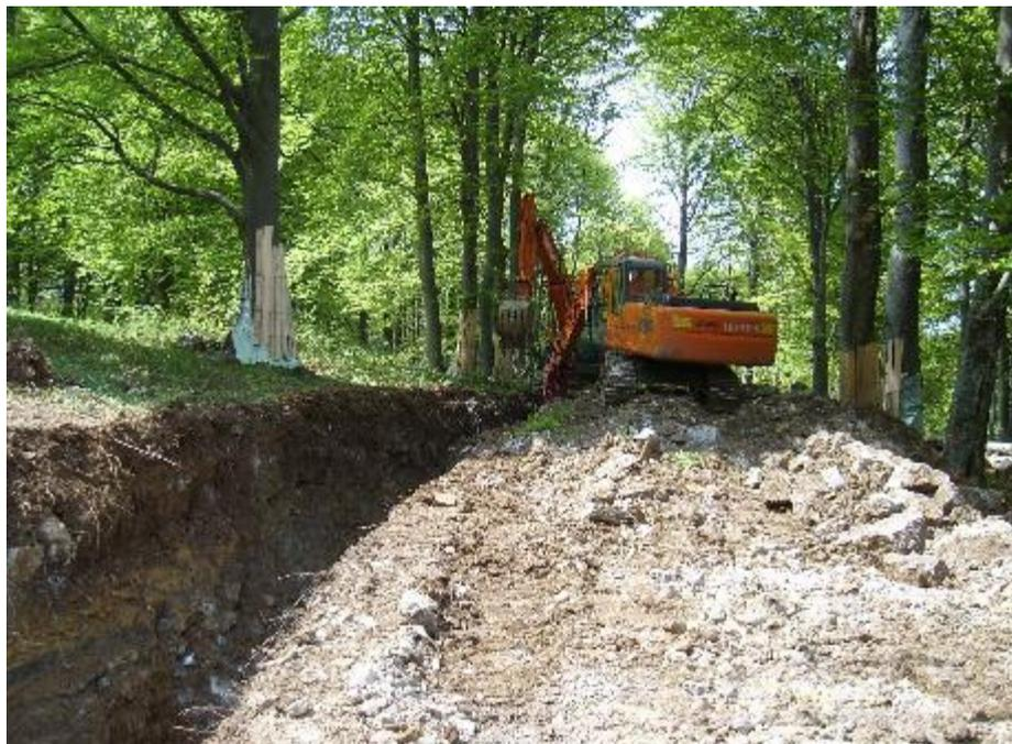
*Figura 0-5 Foto tipica di scavo della trincea*
