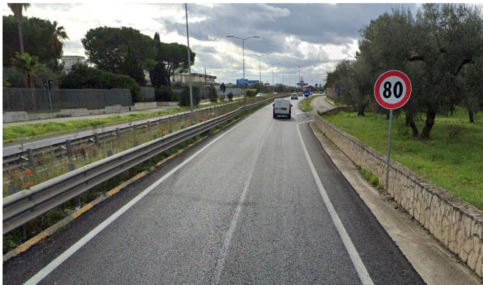
Figura 4.6 – Strada esistente: Sp60 (Direzione Nord lato monte) - inizio tratto
