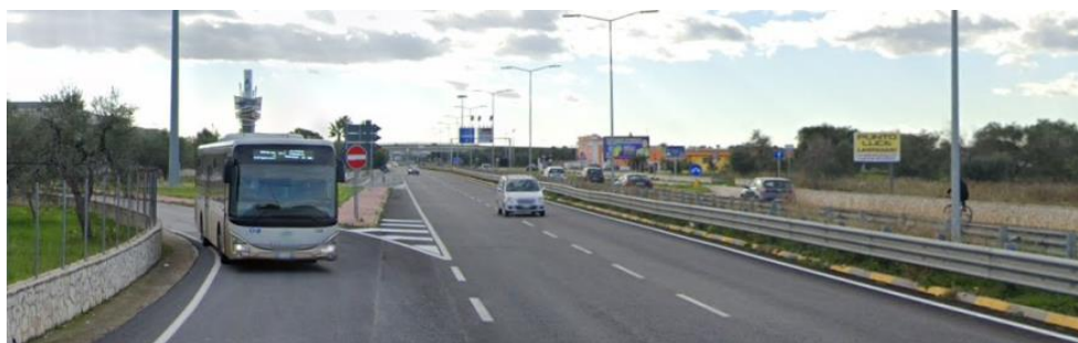
Figura 4.3 – Strada esistente: SP60 (direzione sud mare) Ingresso da via Giannarelli
