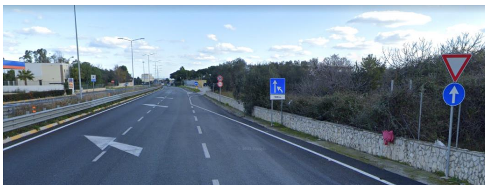
Figura 4.4 – Strada esistente: SP60 (direzione sud mare) Termine della corsia di Ingresso da via Giannarelli
