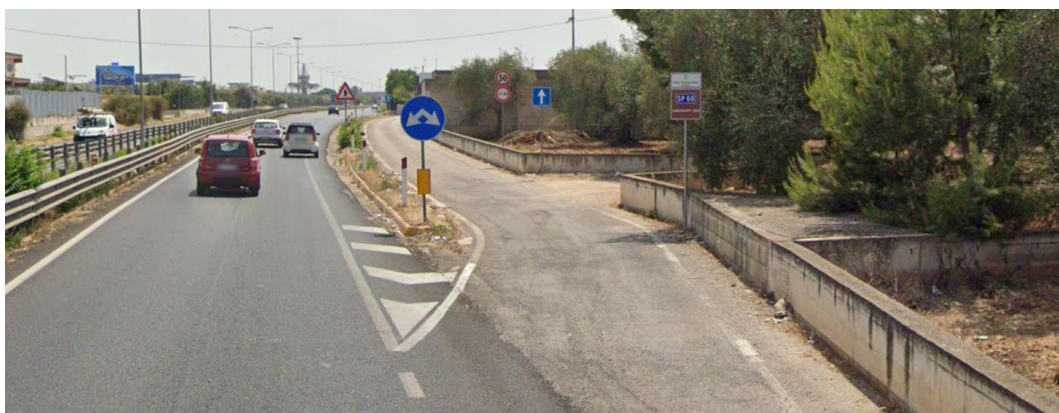
Figura 4.7 – Strada esistente: Sp60 (Direzione Nord lato monte) – Uscita complanare nord
