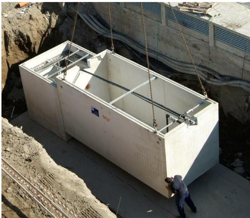
**Figura 7-5 - Moduli prefabbricati tipologici per le vasche di prima pioggia**
