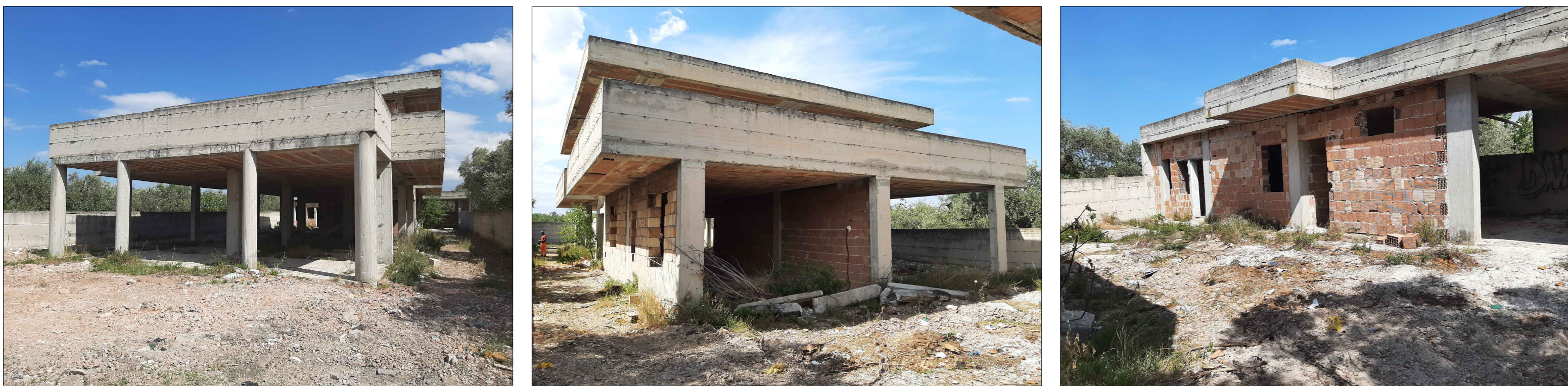
FABBRICATO DA DEMOLIRE-FA23
