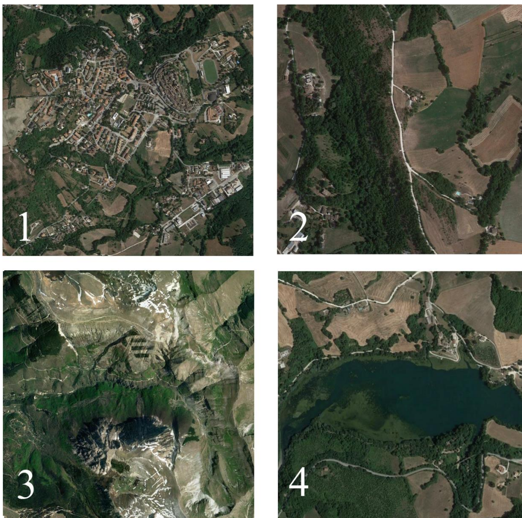
Figura 3-11 – Mosaico dei principali elementi strutturanti il paesaggio dell’ambito di intervento: nell’immagine 1: centri urbano sorti nella fascia pedemontana dei Sibillini: l’abitato di Sarnano; immagine 2: crinale con presenza di rete viaria, aree agricole e boschive; nell’immagine 3: dorsale appenninica dei Monti Sibillini presso ambito di intervento; immagine 4: invaso acquifero lungo il corso del fiume Tenna
