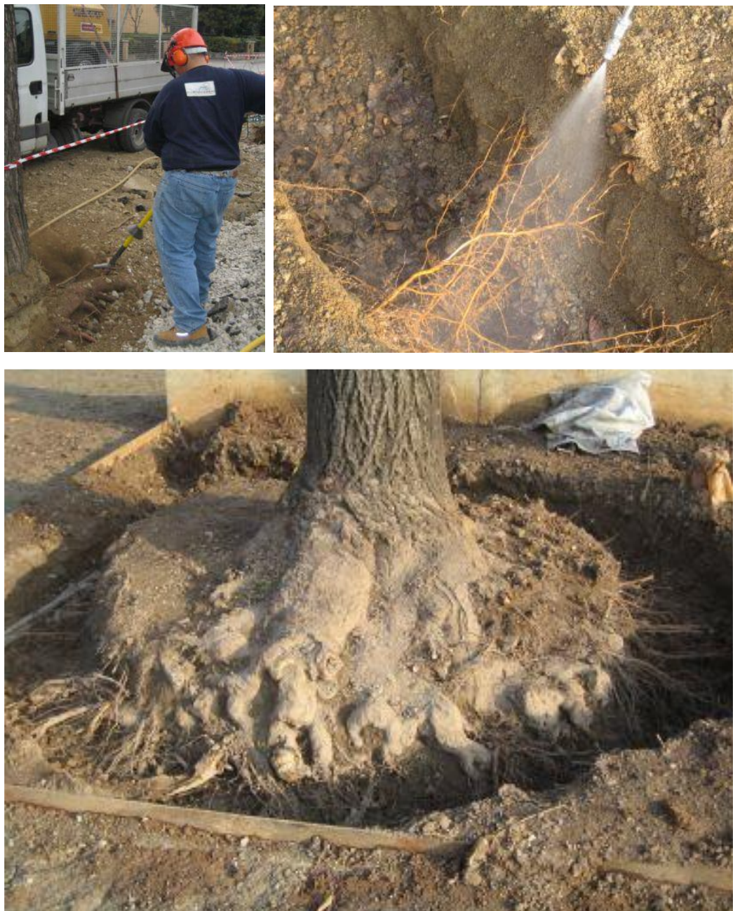
Figura 4-20 Ispezioni apparato radicale con tecnologia AIR SPADE®
