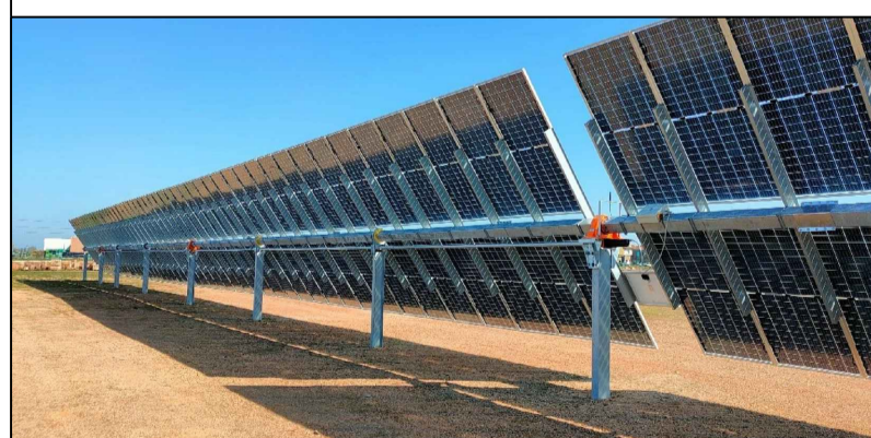
FASE DI MONTAGGIO
