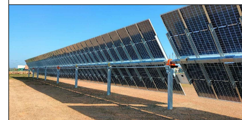
FASE DI MONTAGGIO
